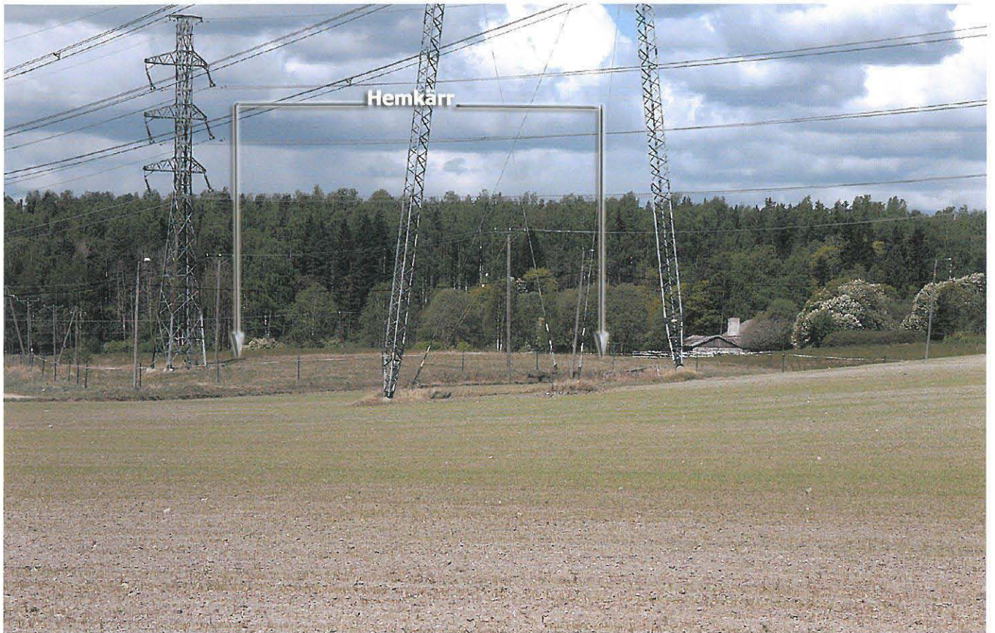
Kuva 18: Yleiskuva Hemkärrestä. Kuvass merkitty kohteen rajat nuolilla. Kaakosta.
