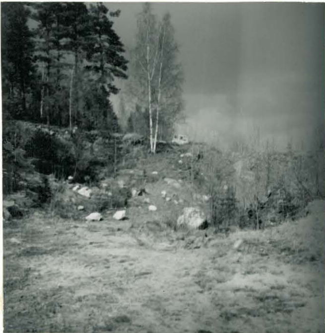
48. MYNTIN HIEKKAKUOPPA. KAIVAUSSALUE 1958 OIKEALLA.
