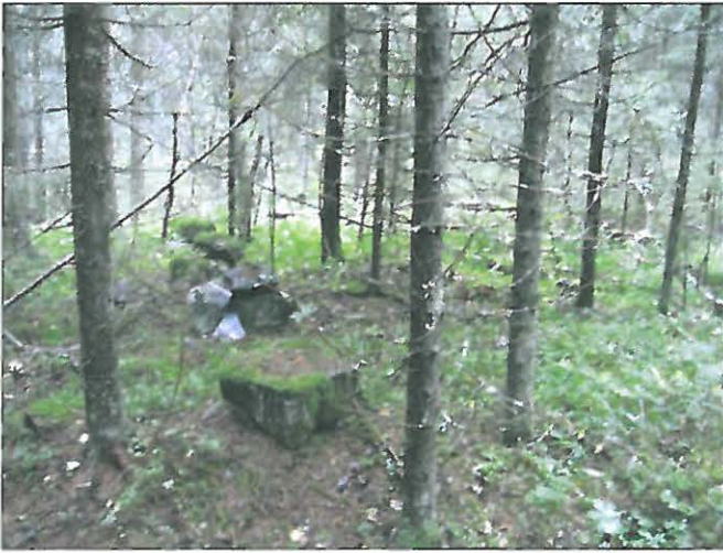
Img 1344: Kohde 80, Kantola 6. Rakennuksen perustus. Idästä 22.8.2008.
