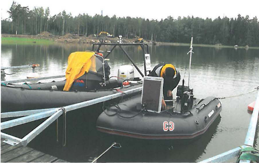
Kuva 5. Taustalla näkyy ruoppaustöitä Matinsaaren venelaiturin vierellä. Kuva MA200725:6.29.
