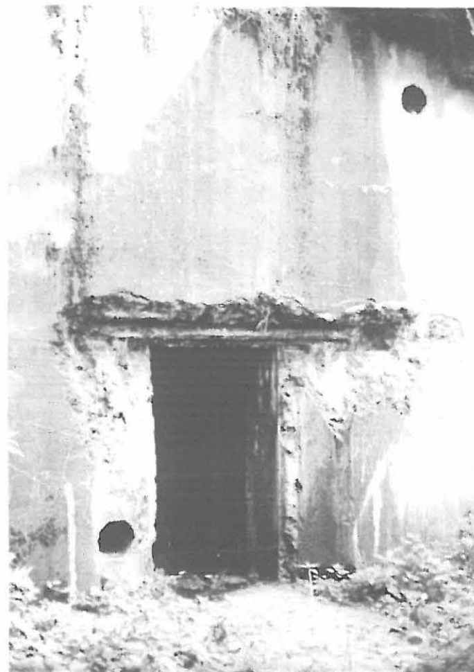
f.61162 Kuva 18. AMMUSVARASTON BETONINEN ETUSEINÄ SUUAUKKOINEEN.
