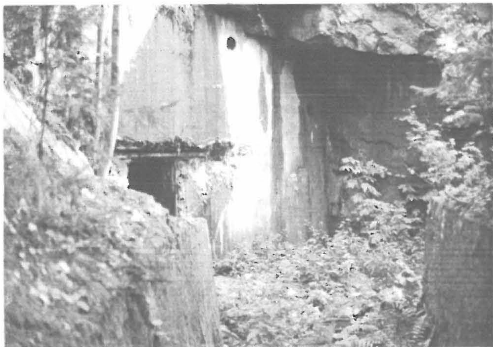
f.61161 Kuva 17. AMMUSVARASTON EDESSÄ ON YLHÄÄLTÄ LINNAVUOREN PÄÄLTÄ VALUNUTTA MAATA, HIEKKAA JA KIVIÄ.
