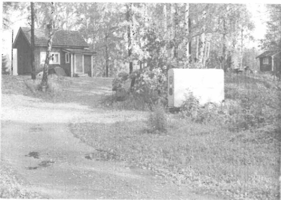
f. 61172 Kuva 23. PUOLUSTUSJÄRJESTELMÄ JATKUU MÄENRINNETÄ PITKIN KOHTI LINNANHERRANTIETÄ. TONTILLA 1 456 SIJAITSEVA TALO (KUVASSA VASEMMALLA) ON V. 1946 RAKENNETTU BUNKKERIN PÄÄLLE. KUVA ETELÄSTÄ.
