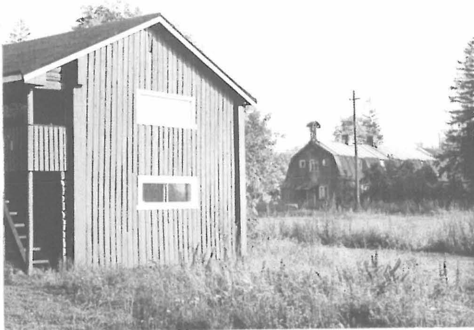
f. 61187 Kuva 38. ETUALALLA KUVASSA VASEMMALLA TONTILLA 1 605 SIJAITSEVAN AITTARAKENNUKSEN PÄÄTYÄ JA TAUSTALLA OIKEALLA BORGSIN TILAN TYÖVÄENRAKENNUS VELLIKELLOINEEN. KUVA LUOTEESTA.
