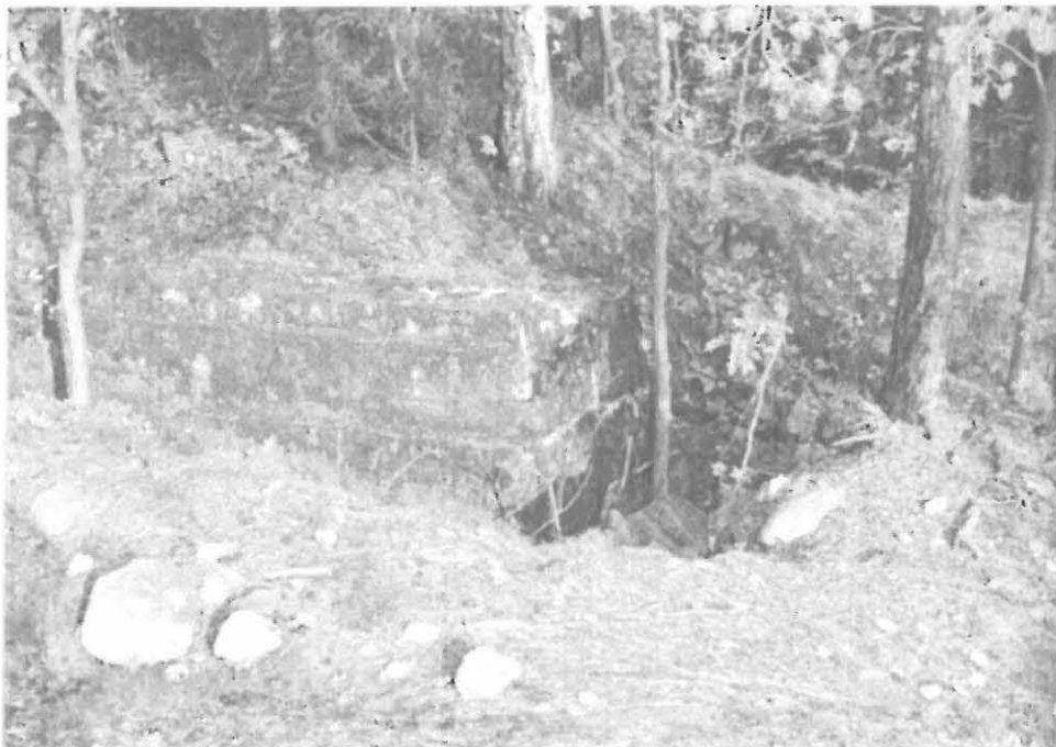
f. 61158 Kuva 14. LINNAVUOREN KOILLISRIINTEEN BETONILLA TUETTUA JUOKSUHAUDAN SEINÄMÄÄ.
