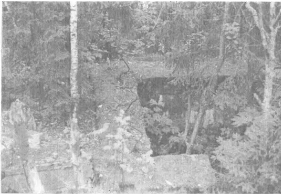
f. 61157 Kuva 13. LINNAVUOREN POHJOISRIINTEEN BETONIBUNKKERIA.
