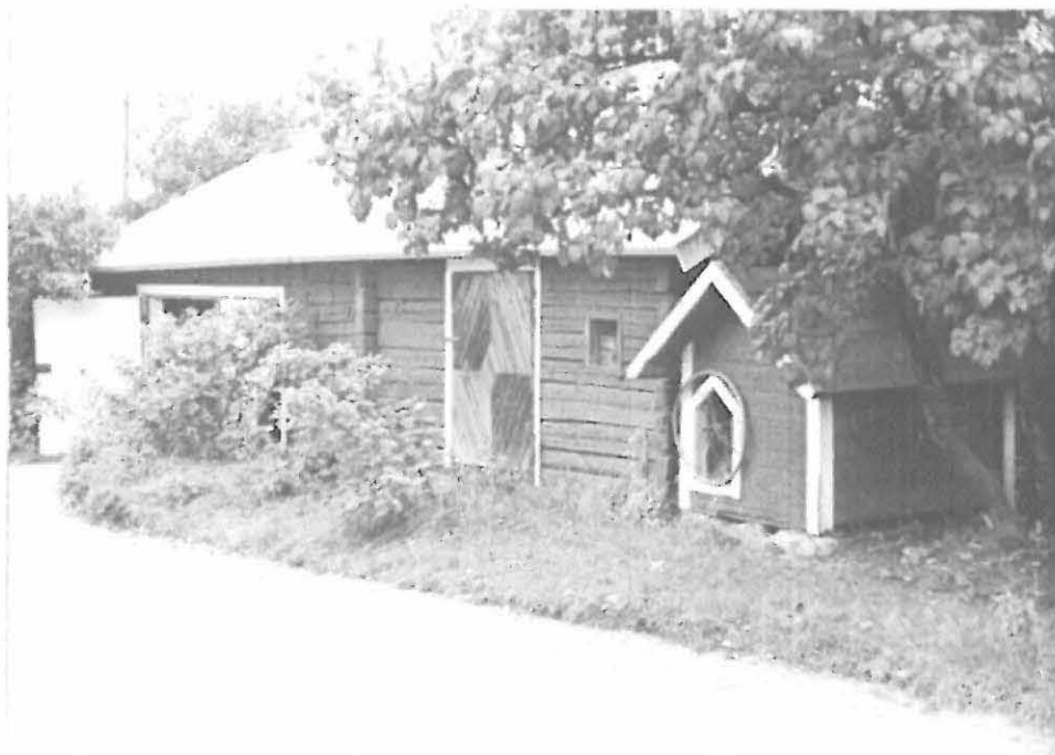
f. 61182 Kuva 33. TILAN RAKENNUKSIIN KUULUVA YKSIKERROKSIINEN AITTA.
