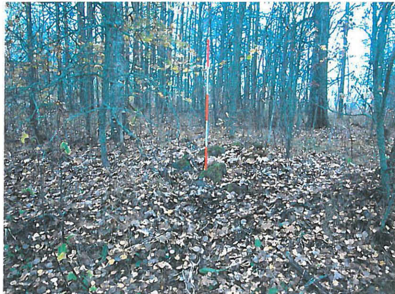
Heinijärvi. Rakennuksen kivijalkaa.
