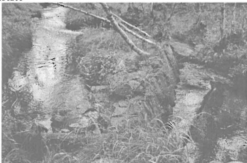
Kuva 17. Inari Luttojoki Saariselkä 2. Kullankaivuun liittyvä puurakenteinen pato. Kuvattu lounaasta. Neg. 136267
