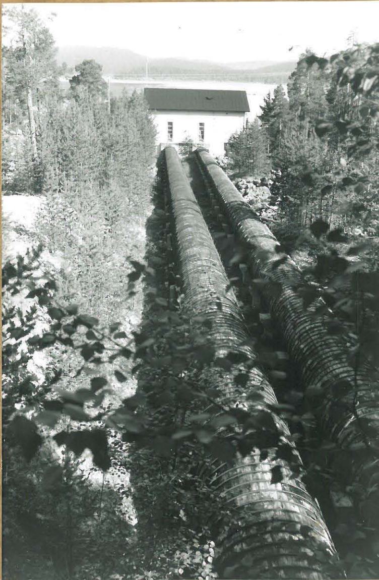
KIRAKKAKÖNKÄÄN VOIMALAITOS SYÖKSY- PUTKINEEN, TAUS- TALLA UKONJÄRVEÄ. AA 1991
