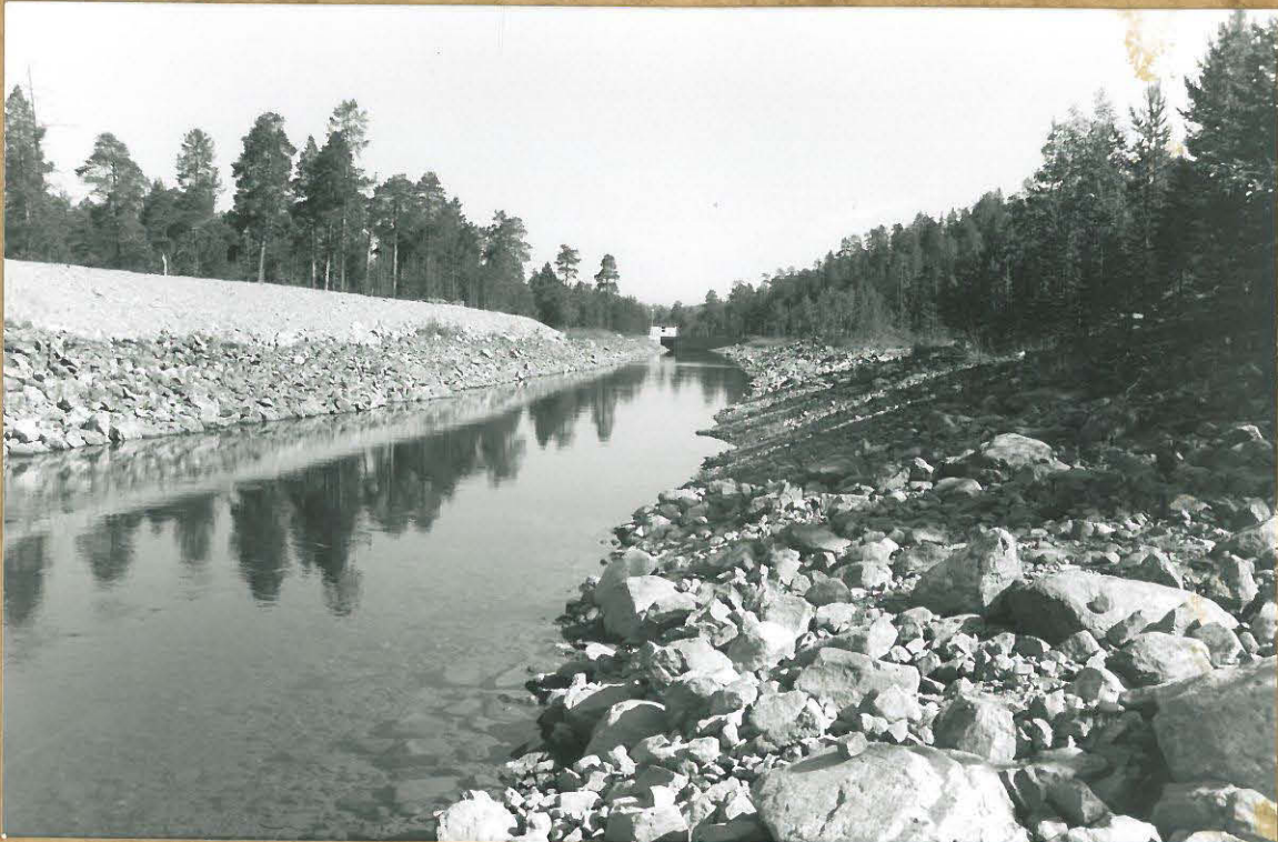
KIRAKKAKÖNKÄÄN VOIMALAITTIKSEN SYÖTÖ- KANAVA. AA 1991
