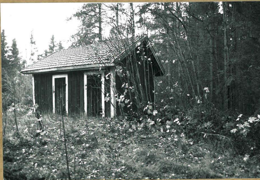
KARJAA 72 NÄSE LÄHES TUHOUTUNUT RÖYKKIÖ ULKORAKENNUKSEN ALLA JA PÄÄDYSSÄ. IDÄSTÄ.
