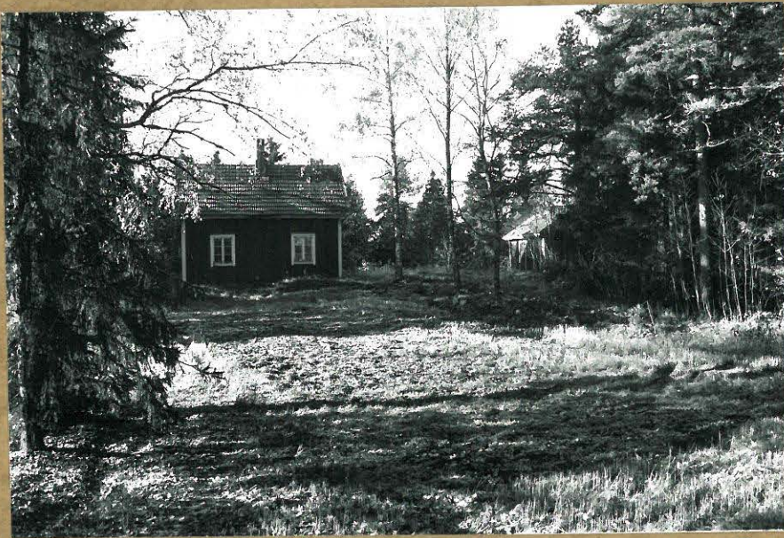
KARJAA 72 NÄSE RÖYKKIÖ OIKEALLA ULKORAKENNUKSEN ALLA JA PÄÄDYSSÄ. KOILLISESTA.
