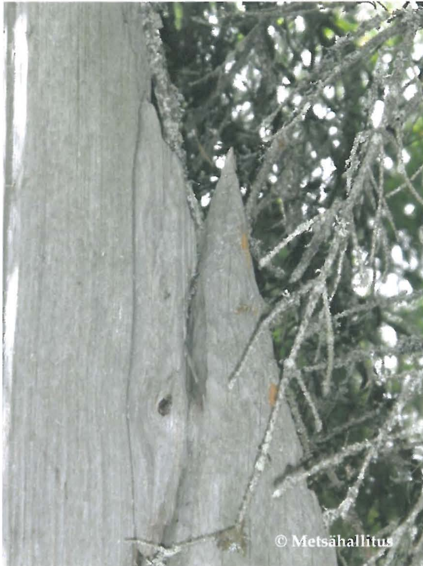
Kuva 34. Hangassalmi. Yksityiskohta käpälälaudasta.
