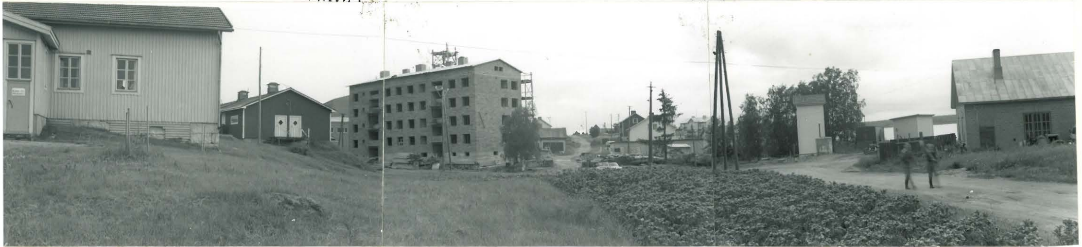
KEMI OY:N PALSTAN PERUNAMAAN, JOSTA LÖYTYI KVAARTSIA KM 15+14. LOUNASTA? VASTAÄÄTÄ HILLAHAKA ASUNTO-OSAKEYHTIÖN RAKENNUSTYÖMAASTA.
