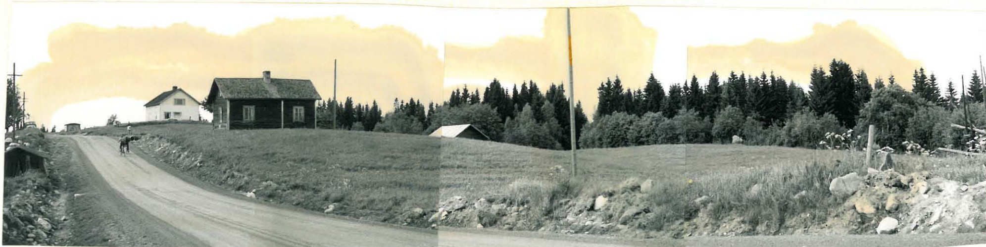
11. Heinävaaran Kalmisto-pelto. Mäkin perustuksia kaivettaessa löytyi säkullinen luuta. Etelästä nähtynä ff. 32789-32790, 32783
