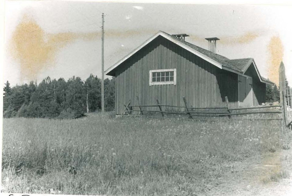
5. Tämän ladon alla on perunakuoppa, joka kaivettiin v. 1947. Paikka nähtynä etelästä f. 33655
