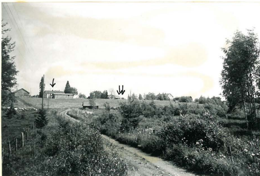
23. Romppalan Autiomäki etelästä nähtynä. ↓ osoittaa entisen kestkievevarin paikkaa; ↓↓ ortodok- sista kalmistoa f. 33673
