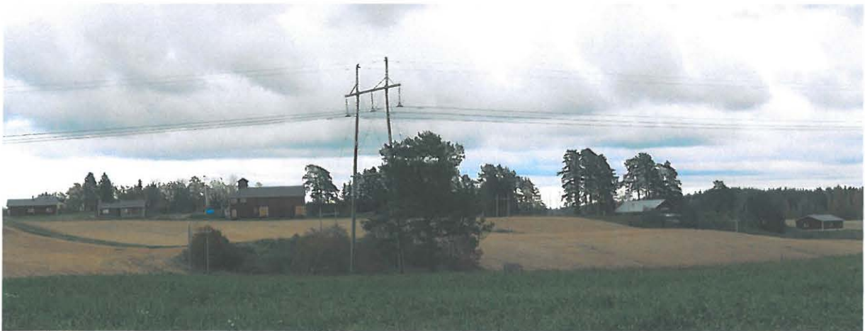
DG374:1 Anjalankoski Sippolan koulukoti, yleiskuva. W-E, 9.10.2008 J. Enqvist, MV/AO.
