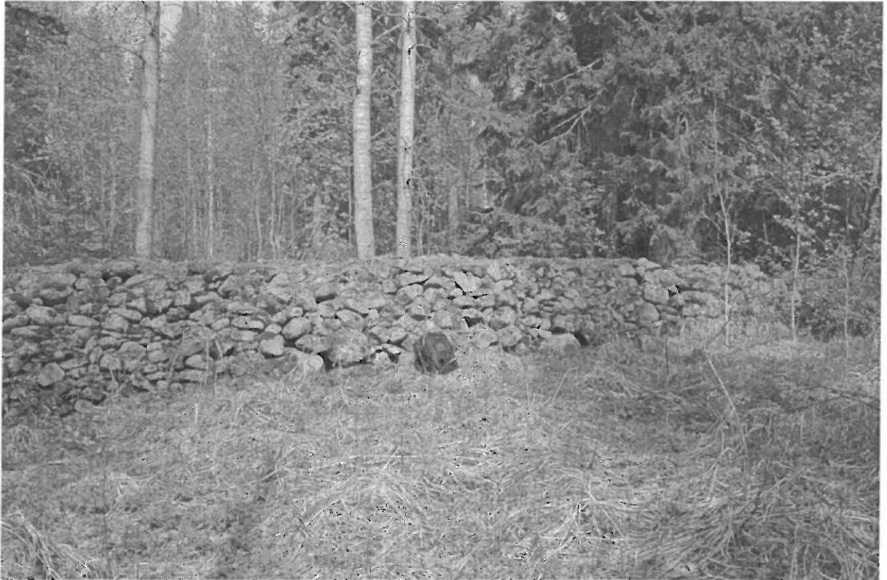
Solvängenin kivimuuri kuvattuna idästä (dia 59667).
