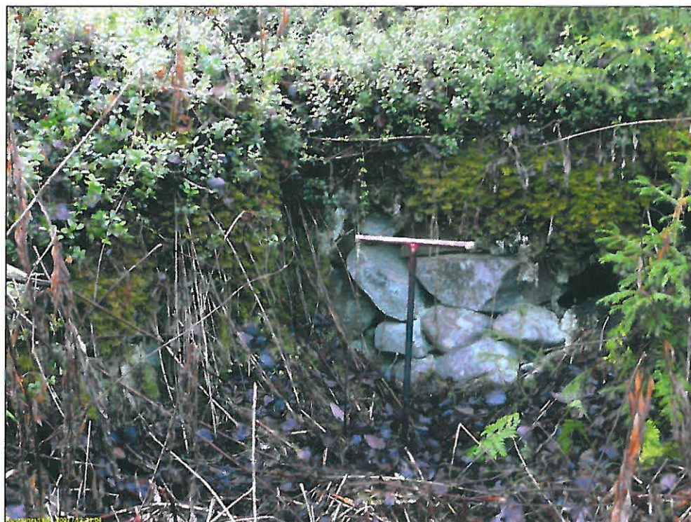
Kuopan kivettyä seinämää.
