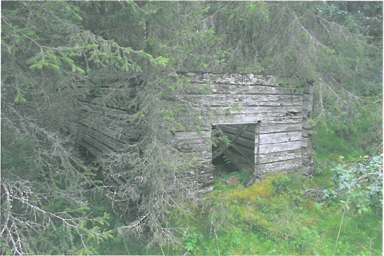
Kuva 23. Uusi kohde 6. Noiviojoki. Osittain sortunut myllyrakennus Noiviojoen pohjoispuolella. Säilyneitä hirsikertoja kaksitoista. Kuvattu itäkoillisesta.
