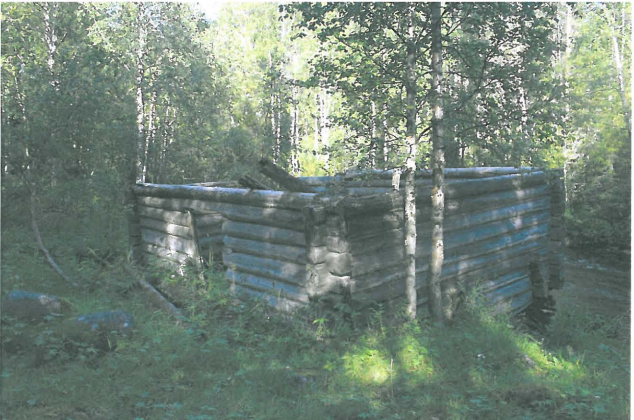
Kuva 20. Uusi kohde 5. Myllykoski, Naatikkajoki. Osittain sortunut myllyrakennus Naatikkajoen rehevällä luoteisrannalla. Kuvattu lounaasta.
