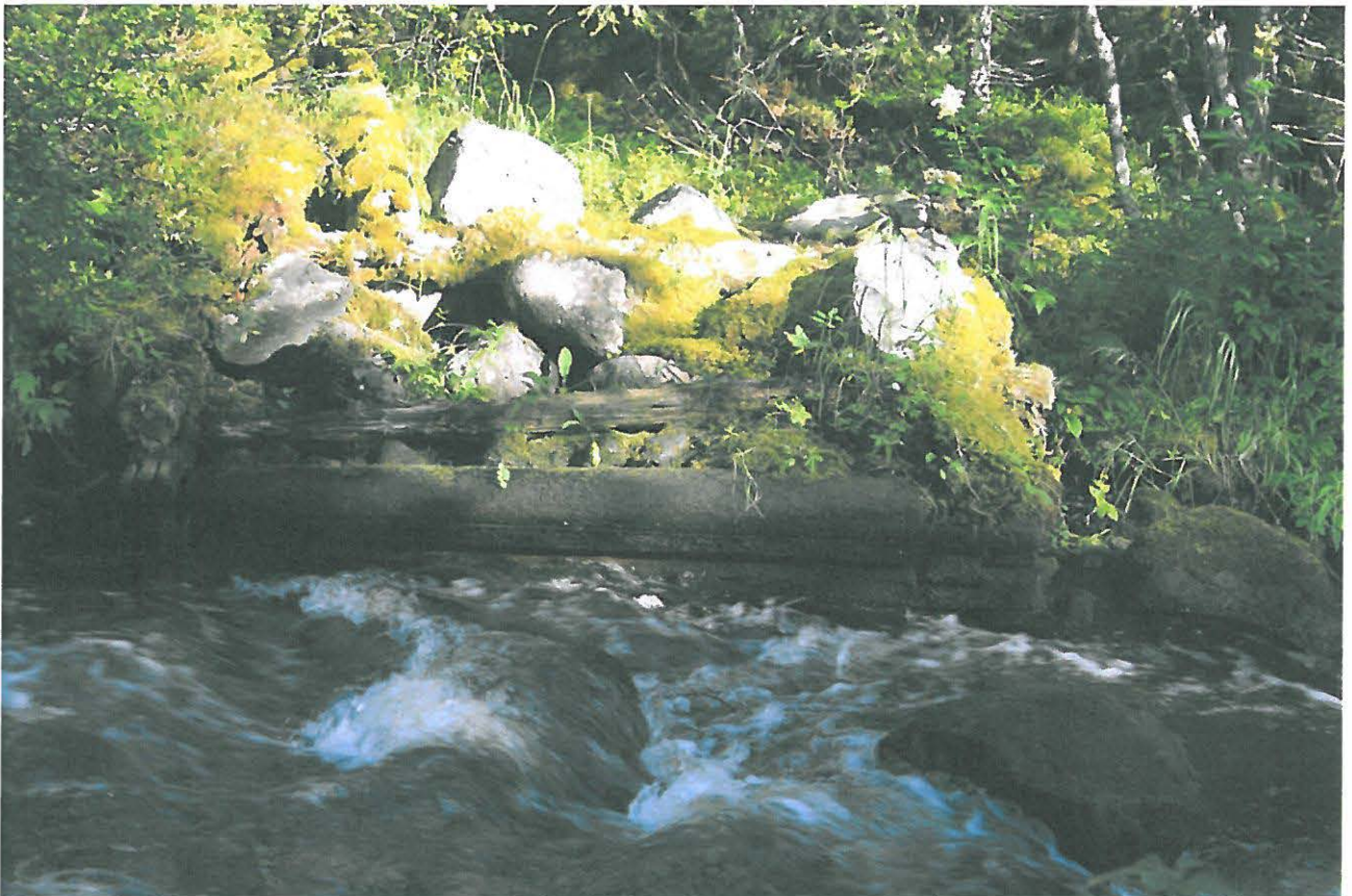
Kuva 22. Uusi kohde 5. Myllykoski, Naatikkajoki. Hirsistä ja kivistä koostuvaa myllyn patorakennetta Naatikkajoen kaakkoisrannalla. Kuvattu länsiluoteesta.
