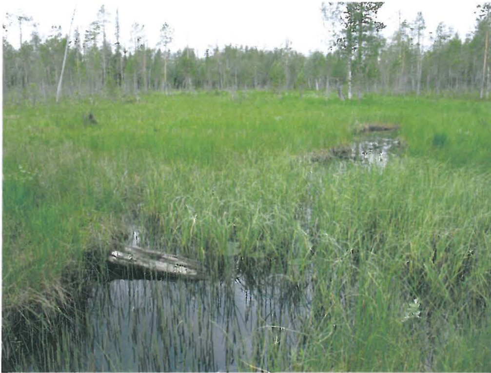
Yllä: Närängänvaara Ellinpuro 3 tammi (82770). Tammen jäänteet noin 130 metriä Ellinpuron niittyäldolta (82768) luoteeseen. Puro on kohdalla noin kolme metriä leveä, hirsyä on purossa parin kymmenen metrin matkalla siellä täällä. Itse tammi on aika selvästi edelleen erottuva. Kuvattu koillisesta lounaaseen, 3.7.2009.
