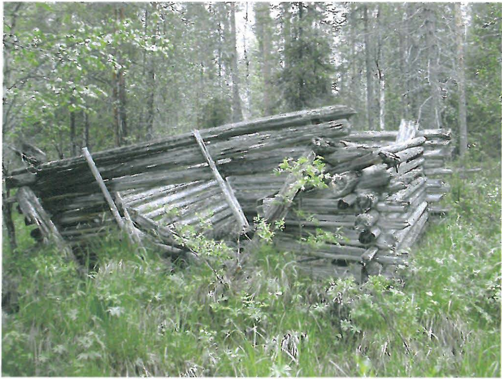
Närängänvaara Yli-Ahmosen niittylato (82570), lähikuva rakenteesta. Kuvattu 17.6.2009.
