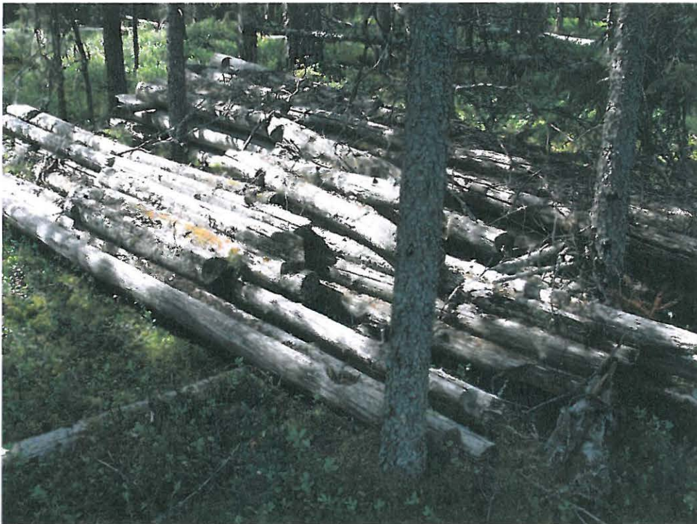
Närängänvaara Metsäpuuro 2 purettu niittylato (82611). Rytiluoman koillispuolella, Metsäsuon eteläpäässä olevalla metsäisellä niemikkeellä on kasassa jätökset niittyladosta. Kuvattu idästä länteen, 1.7.2009.
