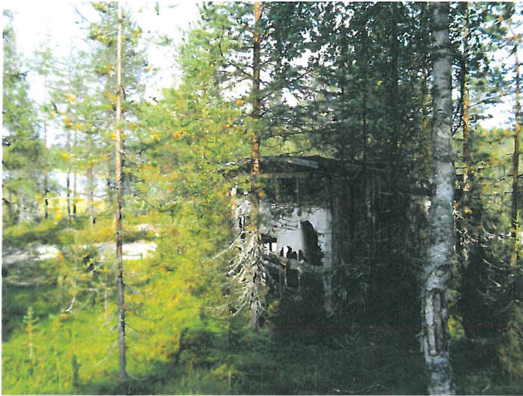
Romevaara Ylimmäinen Lohilampi S maja (82906). Merkillinen, osittain purettu viritelmä lammen eteläpäässä, aivan tien reunassa. Kuvattu 11.8.2009.
