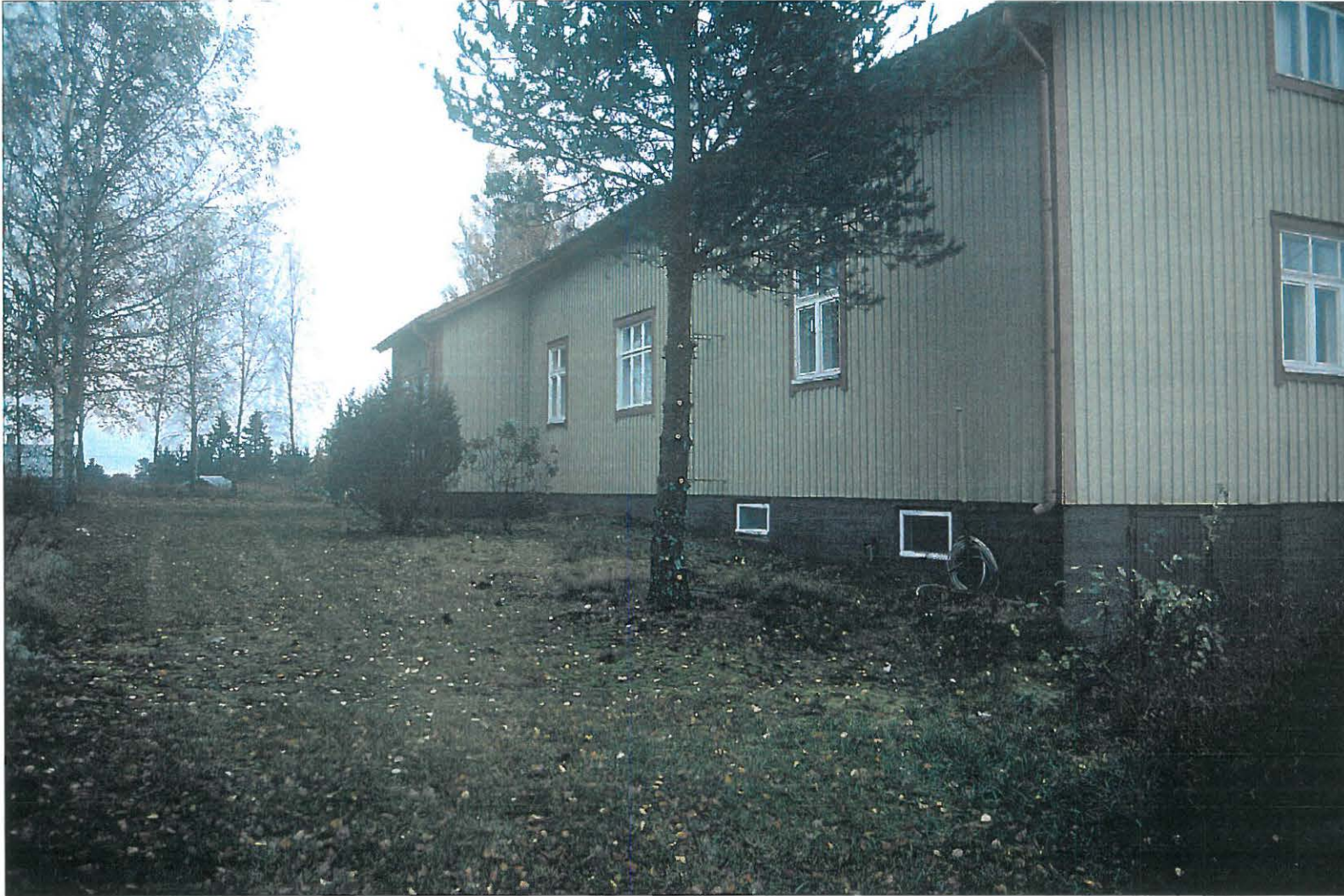
Kohde 7 UNTAMALA. Eino Heinikkalan talo ja KM 15140:1-15 löytöpaikka talon pitkällä sivulla vasemmanpuoleisimman ikkunan alla. Pohjoisluoteesta. Kuva: S.-L. Seppälä.
