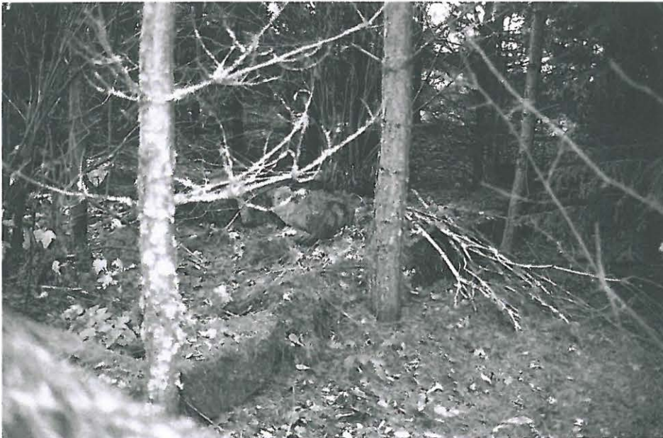
Kuva 11 (mv-kuva 145177:3) Storby gård. Ison kivitalon perustukset (kohde 2). Kuva kaakosta.
