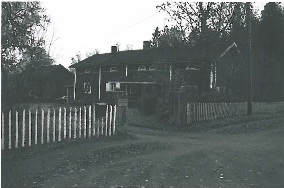
Kuva 4 (mv-kuva 145184:2). Holmgården nykyinen päärakennus. Kuva koillisesta.
