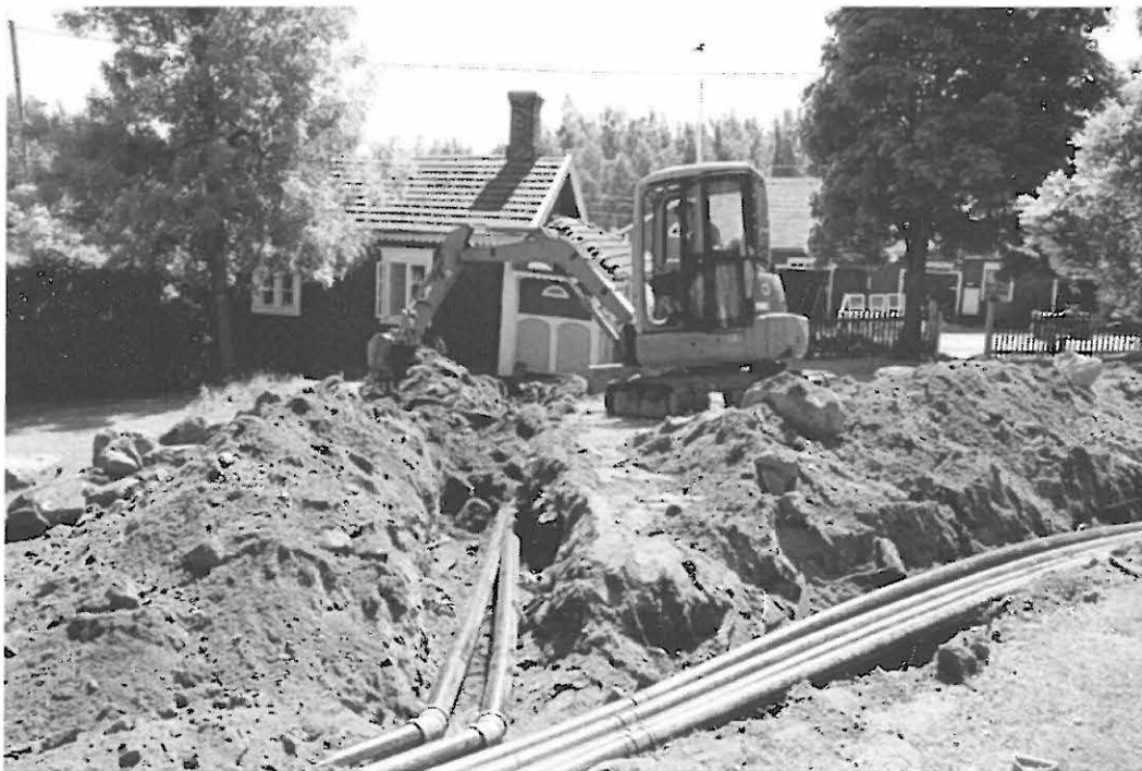
Kuva 4. Sjalö (Sjalö/Fogdeby). Näkymä nk. Valkoisen talon sisäänkäynnin edestä (pohjoisluoteesta) Meijerille. Etualalla pohjoiskoillisen-etelälounaan suuntainen, sekä pohjoisluoteen-eteläkaakon suuntainen kaivanto. Foto: Juhana Ahlamo.
