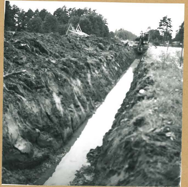
Kuva 15. Maakaasuputken kaivantoa kolmostien varressa paalun 4200 kohdalla. S. Neg. 65830
