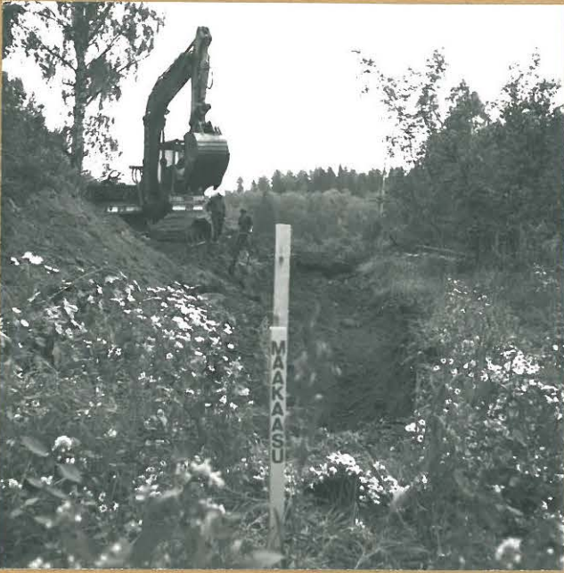
Kuva 14. Maakaasuputken kaivantoa kaivetaan paaluvälillä 3400-3600 kolmostien länsipuolella. Taustalla Rajolan hirttovuori. SW. Neg. 65827
