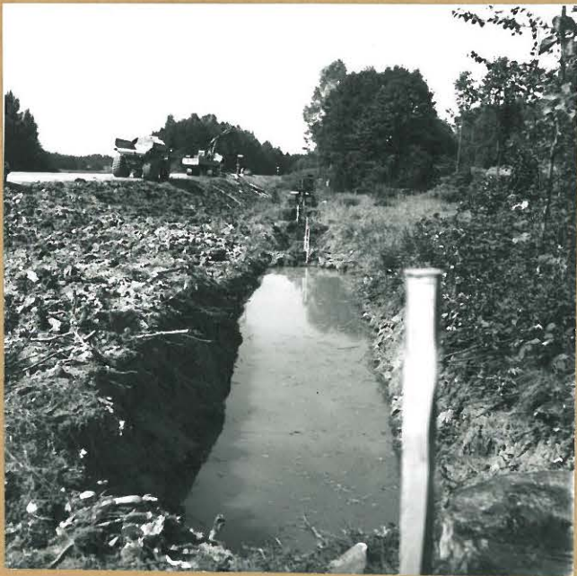
Kuva 16. Maakaasuputken kaivantoa kolmostien varressa paalun 4400 kohdalla. S. Neg. 65833
