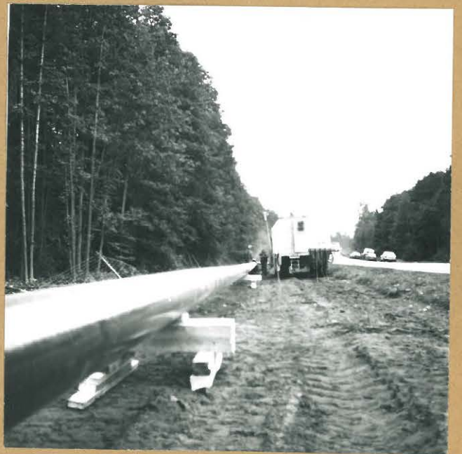
Kuva 17. Venäläiset Nitsaavat maakaasuputkea kolmostien var- rella. N. Neg. 65836
