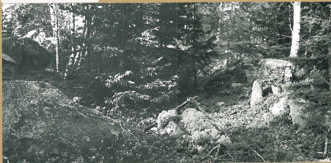
Keskiaikaisen? rakennuksen perusta, etelästä. f. 63869-870
