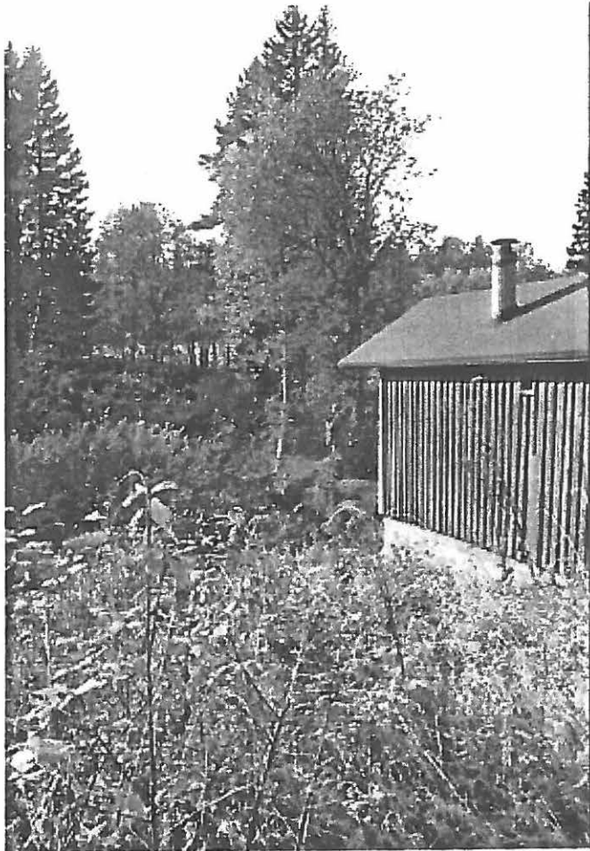
Kuva 7. Myllypelto. Patorakennelma saunarakennuksen edessä vasemmalla. Kuvattu idästä (LKM 134803:11).
