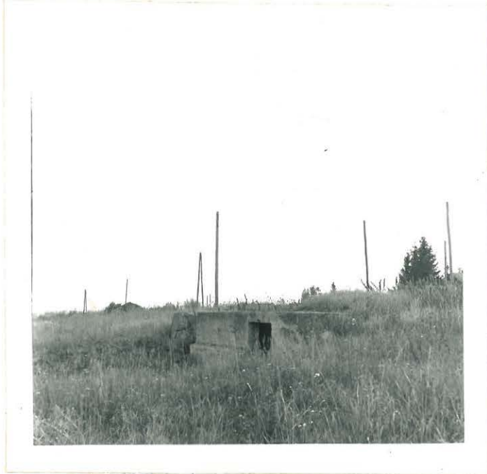
Op. Viktori Tyrmän rakennuksen perustus, kellari etualalla, kaikkiaan kairan ym (KM 9118) ja murens (KM 9242) löytöpaikka. Kuvattu itäkaakosta.
