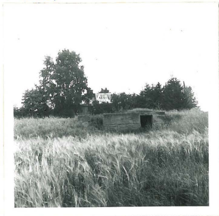
Op. Tyrmän rakennuttaman ja op. Suvisen ostaman rakennuksen perusta kellareineen, kuvattu etelästä.
