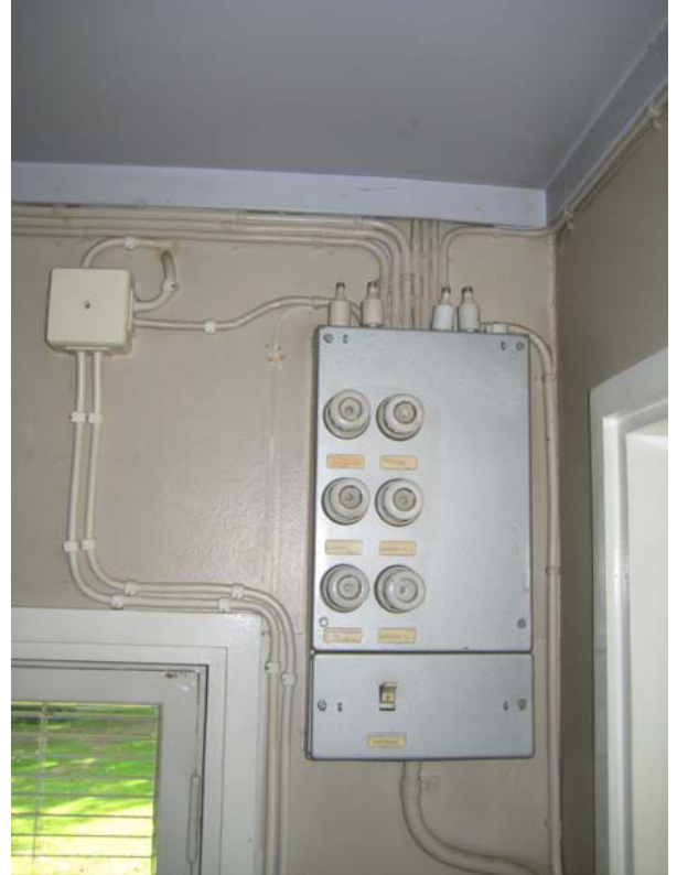
Sähköjohtojen asennukset on tehty levypintaan. Kuva VP
