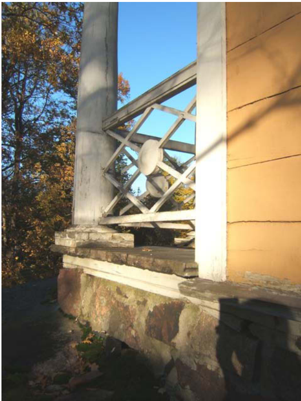
Ulkonäön vuoksi yhtenäiseksi rakennettu kivisokkeli on saumattu laastilla. Kuva MaS 2007
