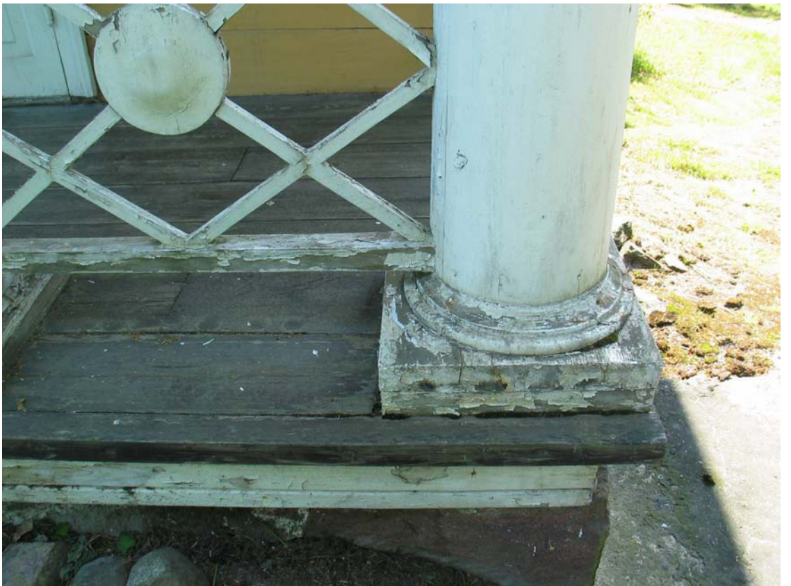
Joonialaisen pylvään jalusta ja varsi on veistetty puusta. Kuva MoS 2009
