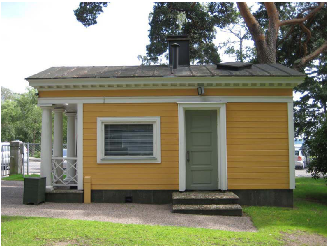
Julkisivu länteen, nykytilanne. Entinen henkilökunnan sisäänkäynti on jäänyt käytöstä. MS
