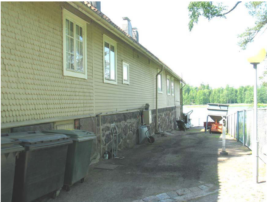
Talusrakennuksen pohjoissivulle on muodostunut verkkoaidan rajaama huoltopiha. Pihaan on rakennettu kivinen pintavesikouru. Piha-alue on toiminut huoltopihana 1900-luvun alusta saakka.
