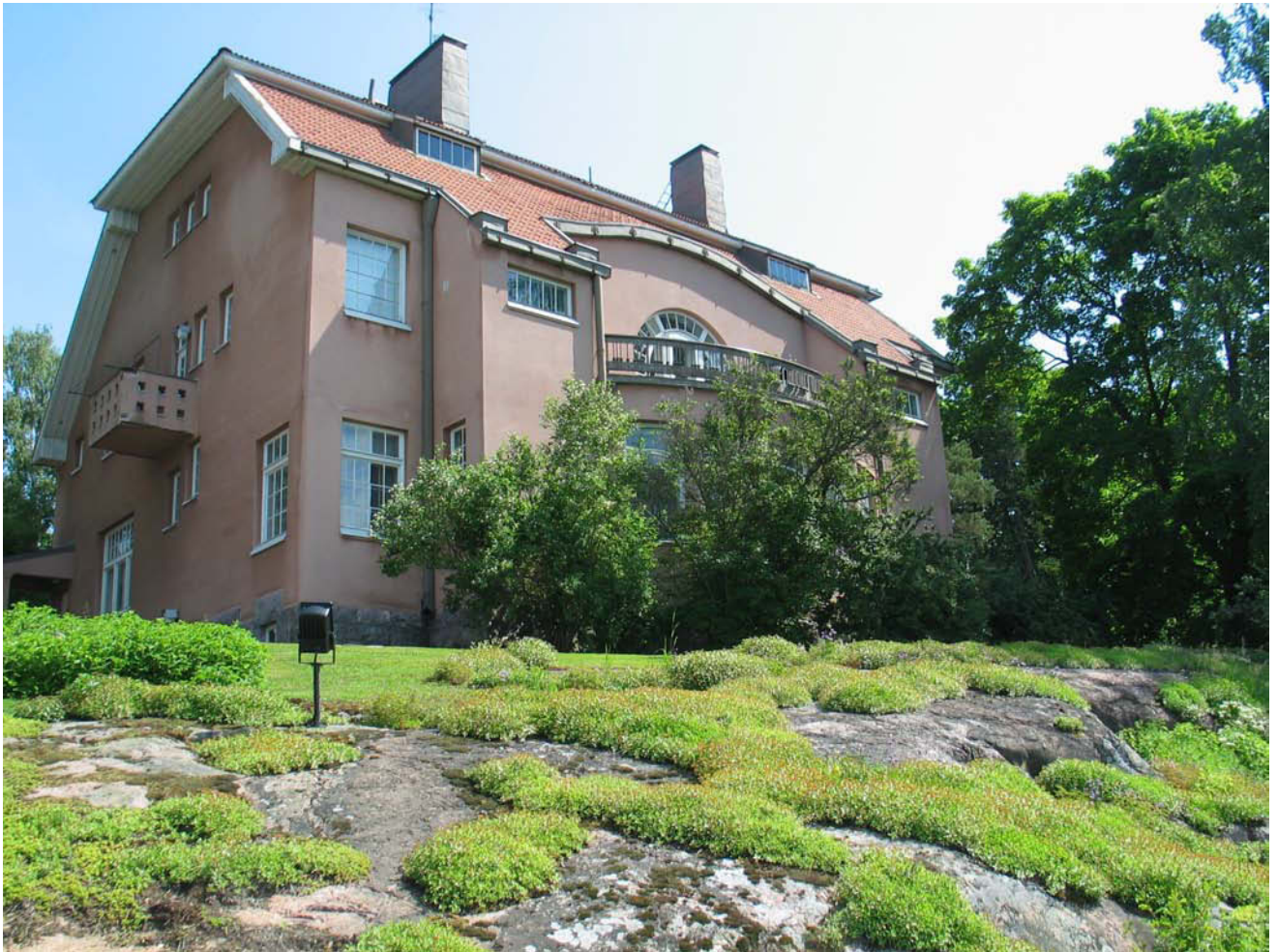
Tilanne vuona 2009. Olohuoneen ikkunan edessä on tuuhea pensasryhmä. Rinteeseen on levinnyt kalliokasviollisuutta.
