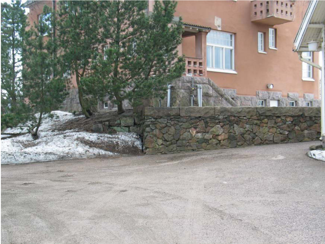
Kattilahuoneen ulkopuolelle on pihaterassiin upotettu öljysäiliö. Jo 1920-luvulla kellarin asennettiin keskuslämmityslaitos. Kivinen tukimuuri saattaa nykyasussaan olla 1950-luvulta.
