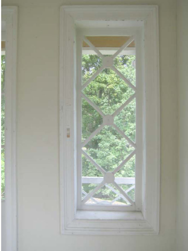
Ulko-ovea kehystävissä ikkunoissa on ristikkoaiheinen, poikkeava puitejako. MaS 2007
