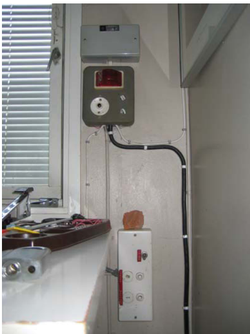
Vartiotuvan laiteasennuksia. Kuva VP
