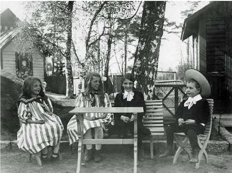
Leikkikentän reunalla on leikkimökki. Vasemalla näkyy talusrakennuksen päädyn eteen rakennettu matala hirsirakennus. MV Hka
