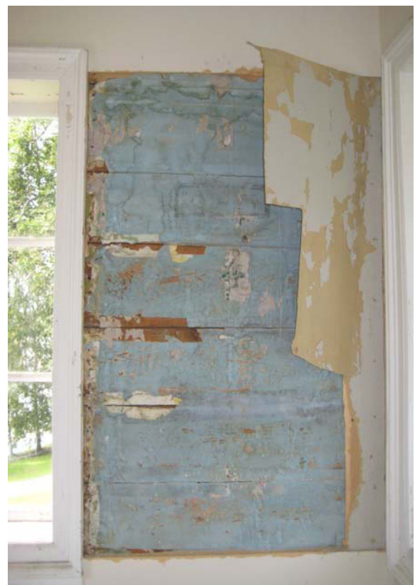
Sisäseinissä on jäänteitä lukuisista muutoksista; tapeteista ja maalauskerroksista. Kuva MoS
