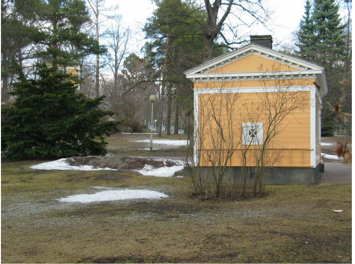
Pääty etelään. Keskilinjassa on neliömäinen, ristikkäisillä puitteilla jaettu ikkuna. MS
