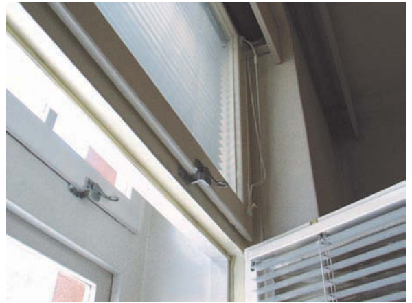
Ikkunassa on erilliset sisä- ja ulkopuolen karmit ja väljä puiteväli.
