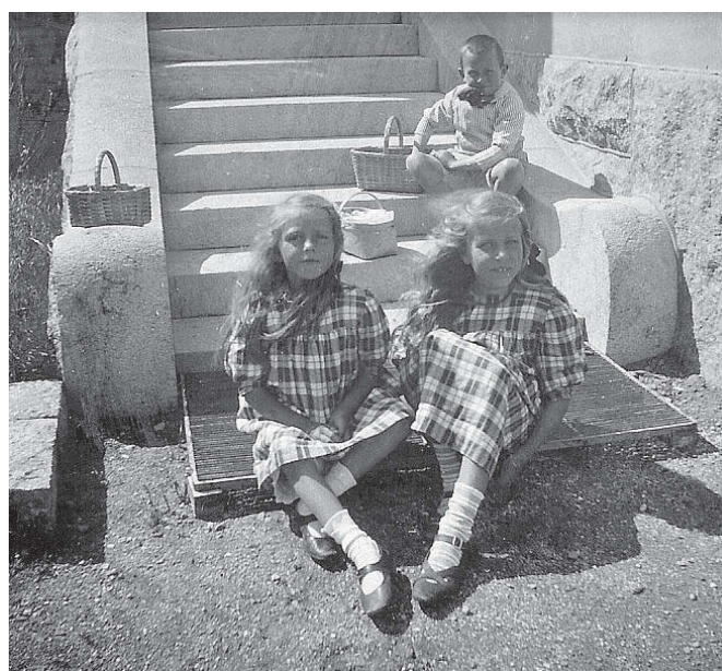
Villa Nissen, kuvausaika n. 1907. Oikealla julkisivun alkuperäinen, sileä rappauspinta ja sokkelin makkarasäuma. Kuvat n. 1907-10. Anne Marie Appelgrenin kokoelma. MV
