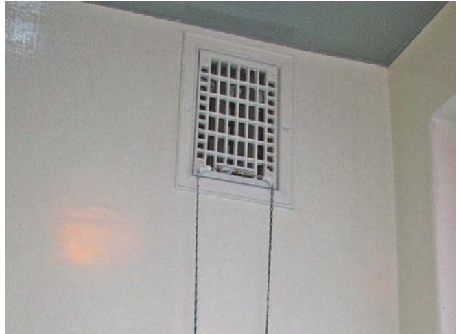
Valurautainen poistoventtiilit.
