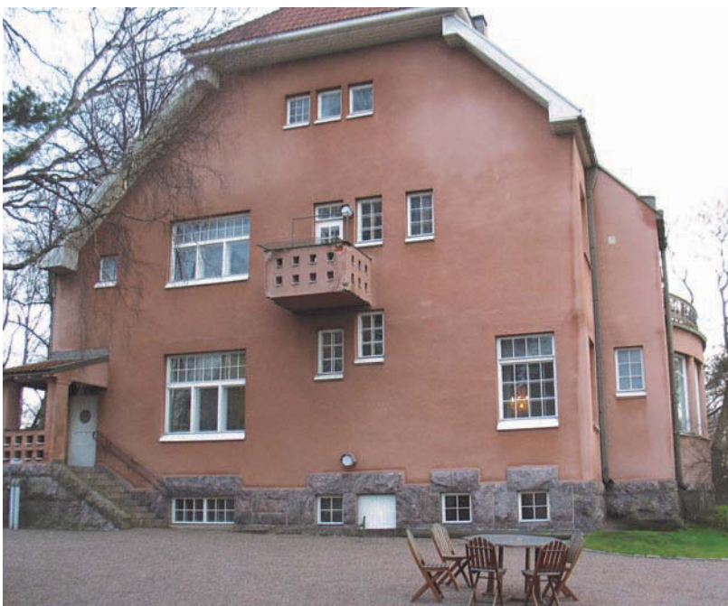
Pääty luoteeseen, vasemmalla keittiön avoin kuisti. Toisessa kerroksessa on sivuportaan rapattu, rataakiskojen tukema ulokeparveke. MS 2008
