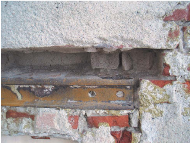
Ulkoseinän ikkuna-aukon yli kulkee rata-kiskopalkki. Rakenneavaus 2010.
