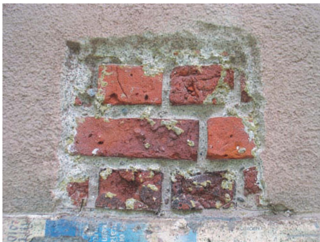
Rappauksen osittainen poisto 9.6. 2010. Ympäriällä läpivärjättyä Terrasit-pintaa 1970-luvulta, pohjalla keltaista Signal-laastia.
