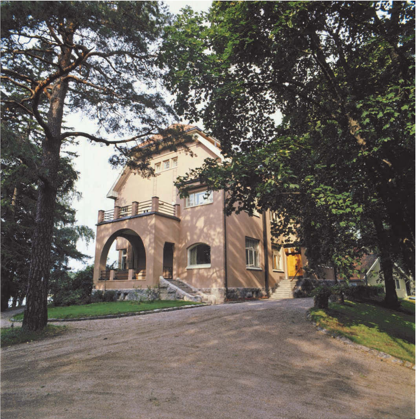
Tamminiemen päärakennus uudelleenrappauksen jälkeen. Pintarappaus tehtiin läpivärjättyllä, punertavalla Terrasit-laastilla. Valok. Kari Haavisto 1974. A-lehdet.
