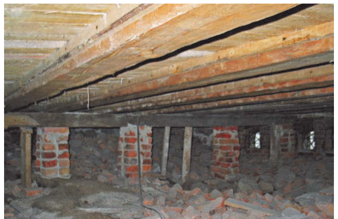
Alapohjan rossipohja olohuoneen ryömintätilassa, oikealla ritilöiden suojaamat tuuletusaukot.
