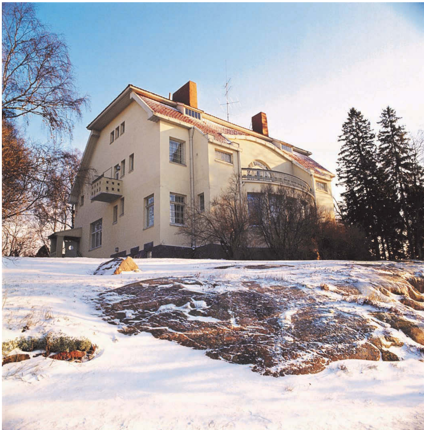
Tamminiemen päärakennus vuonna 1973 ennen julkisivukorjausta. Avotakka-lehden toimittaja luonnehti väriä keltaisesta harmaantuneeksi. Kuvat Kari Haavisto 1973. A-lehdet
