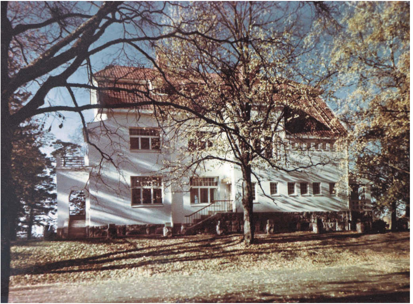
Tilanne v. 1956 peruskorjauksen jälkeen. Foto Roos. Rakennushallituksen valokuvat, KA RakH.
