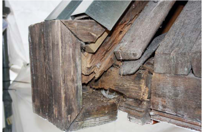
Luoteispäädyn räystäslaatikon rakenne. MS 26.10.2010
