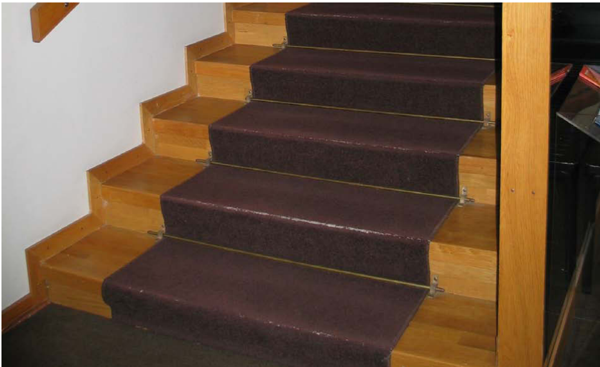
Ensimmäisestä kerroksesta välitasolle. Porrasmaton messinkitankokiinnitys. MS 2009
