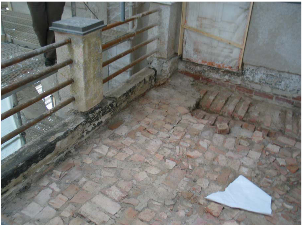
Purkuvaihe. Parvekkeen laatoituksen alusrakenne ja pilarin peltihattu ennen purkua. MS 18.8.2010
