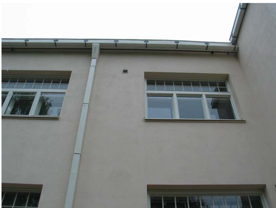
Julkisivu koilliseen, yksityiskohta. Räystäskourut ja syöksytorvet vastaavat väritykseltään suunnittelijoiden tulkintaa julkisivun varhaisimmasta ulkoasusta. MS 16.5.2011
