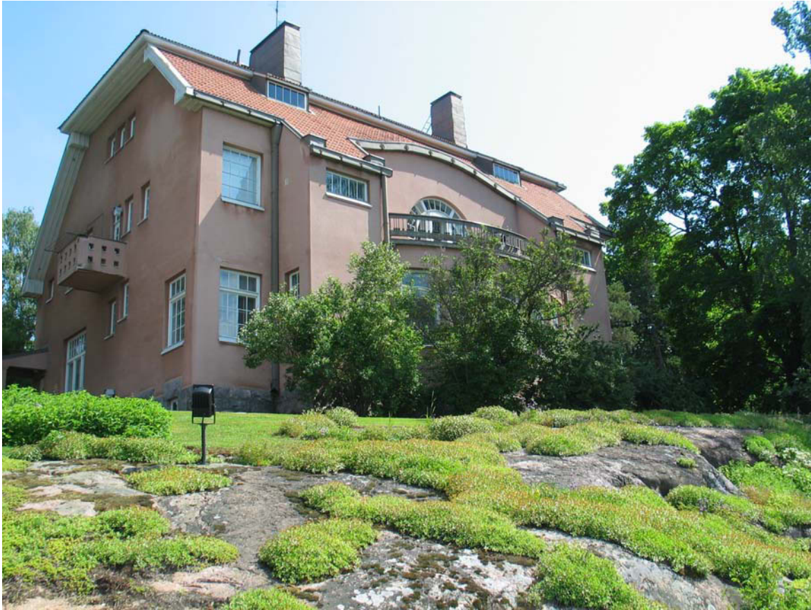
Julkisivu lounaaseen, merelle. Ms 13.6.2009
