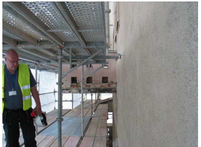
Raimo Laeslehto, julkisivukorjauksen valvoja. MS 6.7.2010
