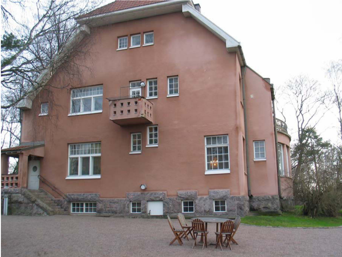
Julkisivu luoteeseen. Vasemmalla keittiön sisäänkäynti. MS 16.11.2008.
