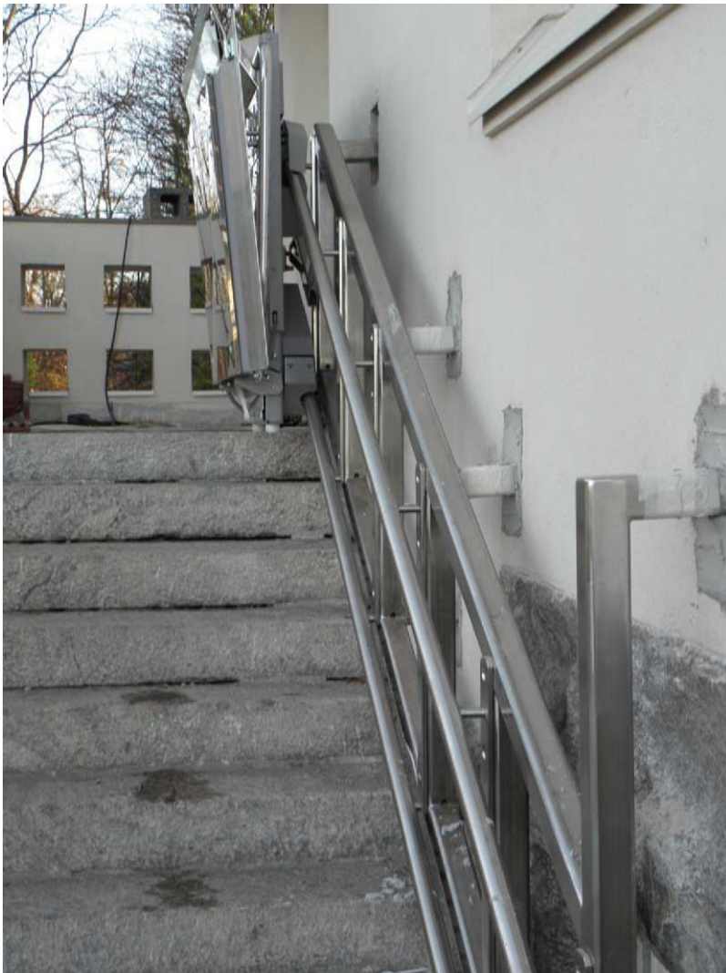
Nostimen putkirungon kiinnitys ulkoseinään, ennen viimeistelyä. MS 9.11.2011
