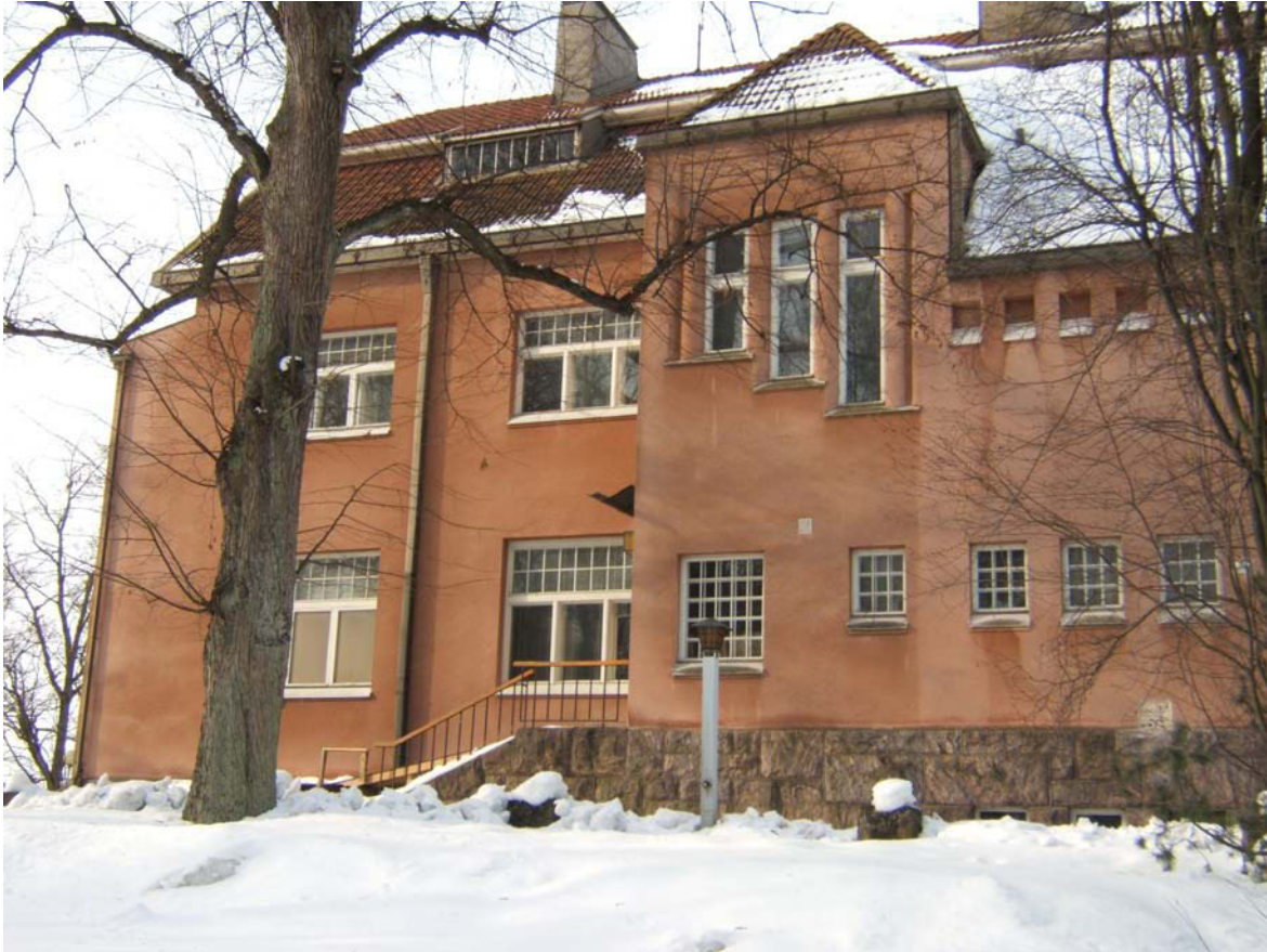
Julkisivu koilliseen. Keskellä pääsisäänkäynnin porras. MaS 26.3.2010
