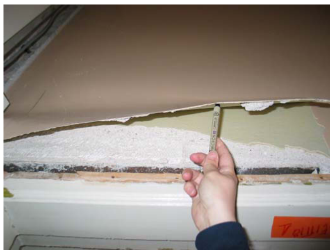
109 Keittiön eteinen, 1. kerros. Seinän vanhemmat maalipinnat ovat säilyneet pähvikerroksen alla. MS 20.6.2011
