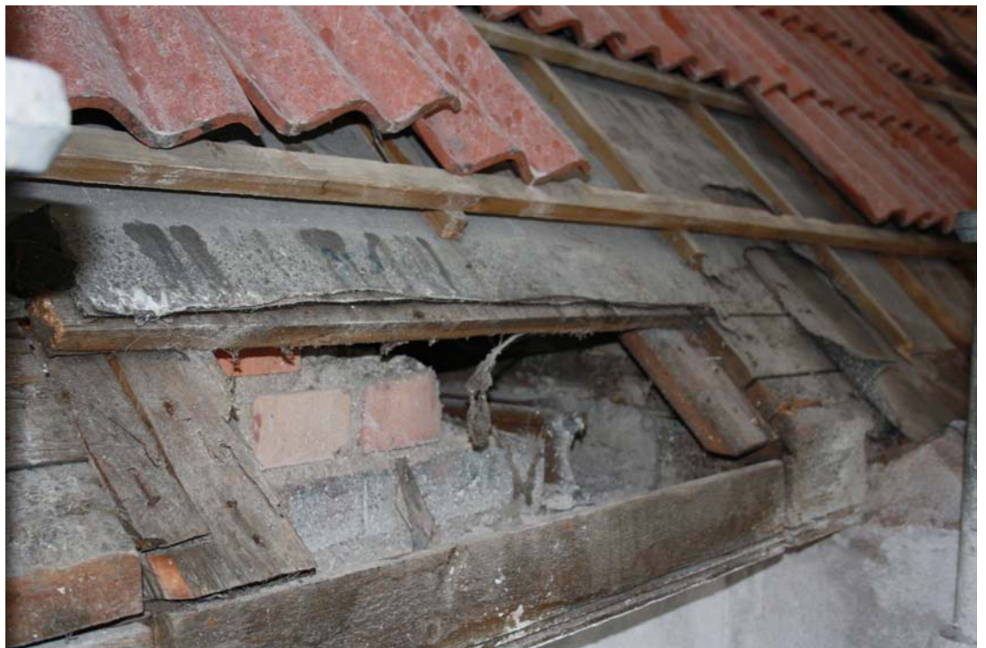
Lounaissivun räystäsrakenne avattuna. MS 26.10.2010
