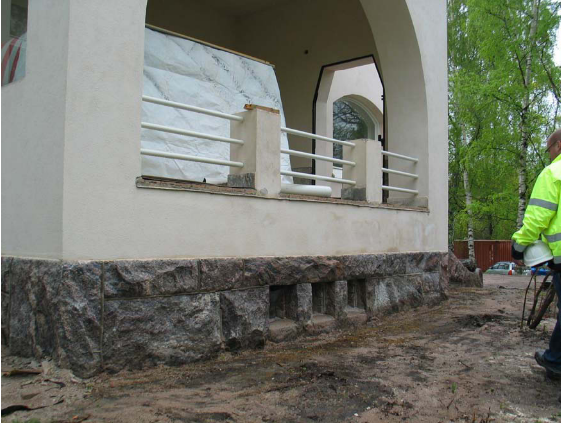
Vilpolan lattiatason reunapellit puuttuivat vielä keväällä 2011.. MS 16.5.2011
