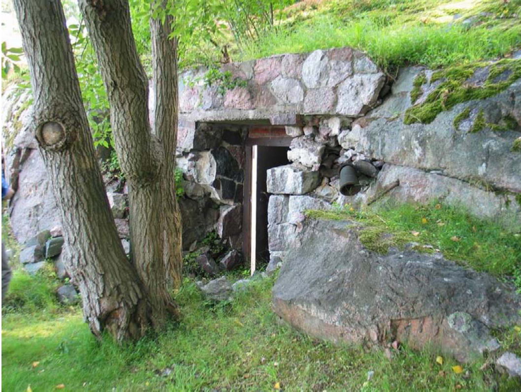
Väestönsuojan kulkuaukko kalliorinteessä päärakennuksen lounaispuolella. MS 2009.
