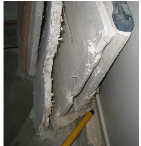
Pontatut, kuituvahvisteiset kattolevyt purettuina. MS 22.4.2010
