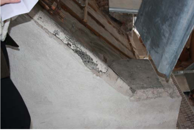
Lounaissivun kaarevan parvekkeen viereinen rapattu erk-kerikoroke. MS 26.10.2010
