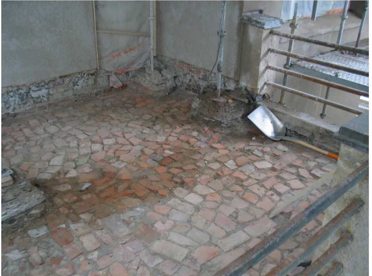
Purkuvaihe. Parvekkeen laatoituksen alusrakenteena vanha tiililadontakerros. MS 18.8.2010
