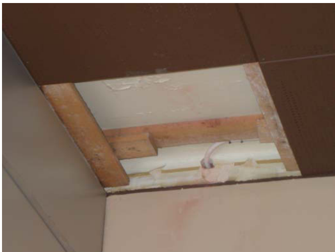
Keittiön katon avauksen yhteydessä tuli hetkeksi näkyviin vanhaa, valkeaa kattopintaa, seinän maalipintaa ja maalattu, kellanruskea reunaboordi. MaS 1.6.2011
