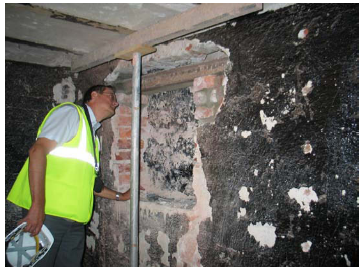
Rakennesuunnittelija Tapio Jauhiainen, tarkastaa purkutyön etenemistä tiiliverhouksesta kiviladelman. MS 18.8.2010.
