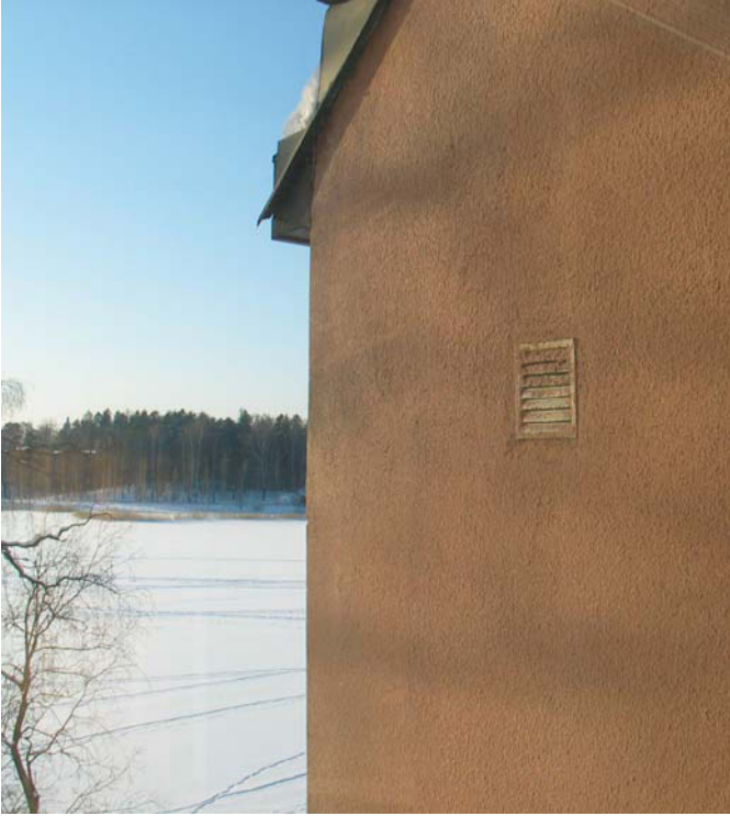
Julkisivu lounaaseen, merelle. Ms 18.2.2009
