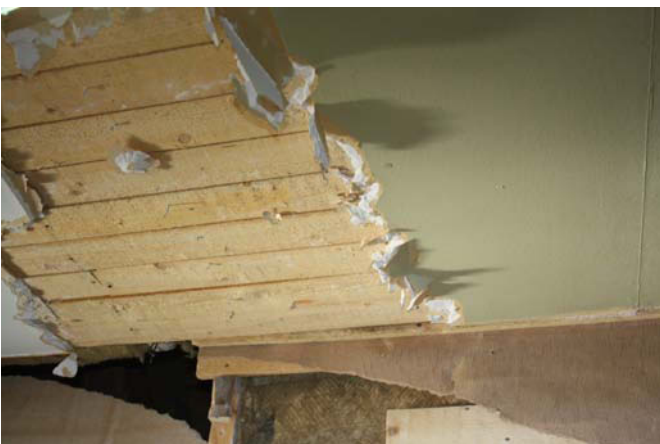
Ullakon katto- ja seinäpintojen avauksia purkutyön yhteydessä. MS 2.3.2011
