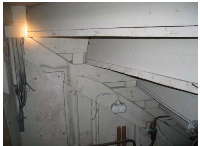
002 Eteisen puuportaat 1. kerrokseen alapuolelta kuvattuna. MS 10.8.2010
