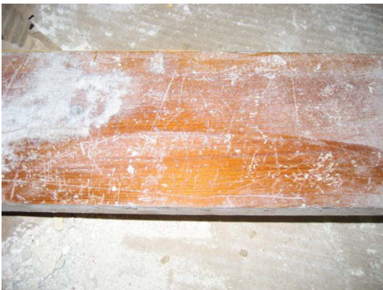
Kuultokäsitelty lautalattia on jäänyt myöhempien kerrosten alle. MS 4.5.2010.
