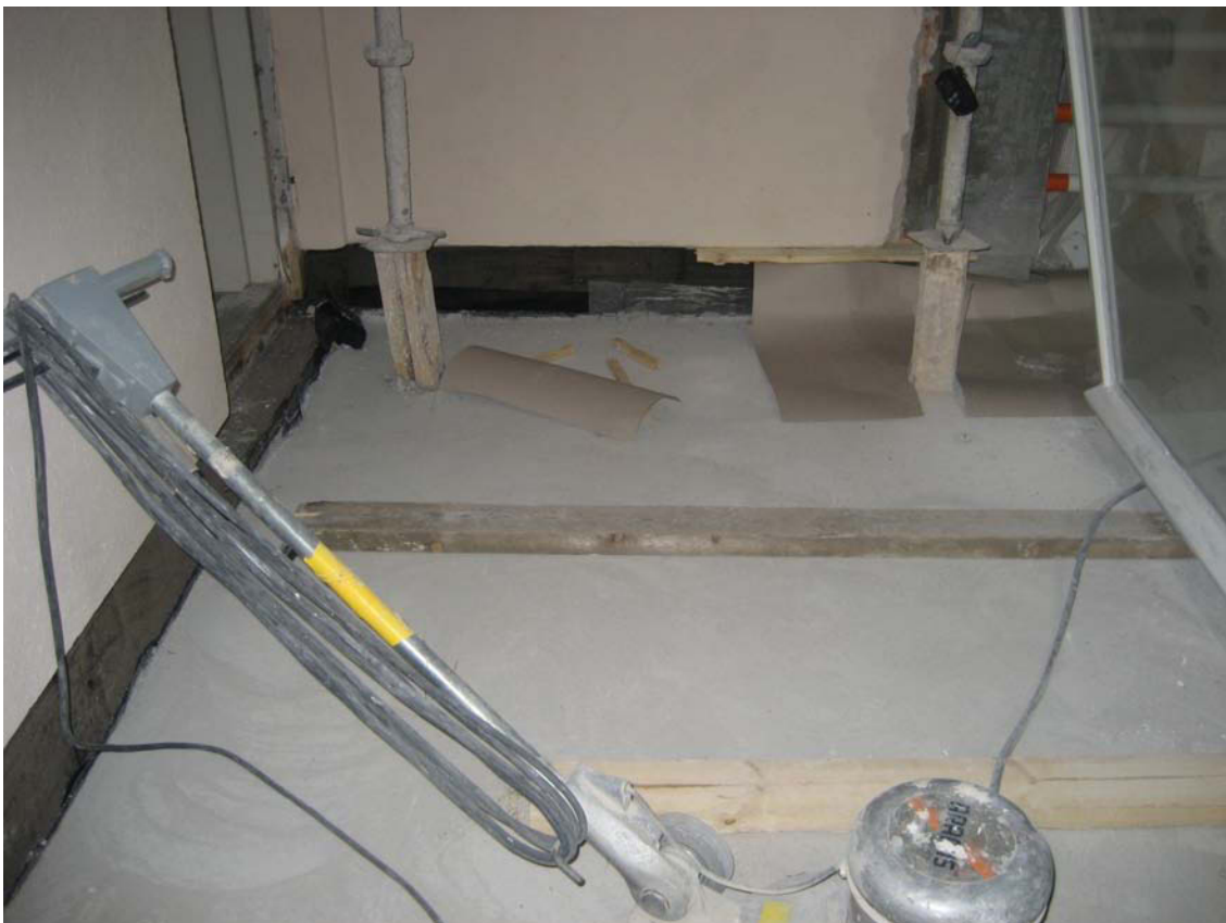
Parvekkeiden vedeneristys ja pintalaatan valusta on rakennesuunnittelija antanut uuden työselostuksen työn edistyessä. MS 23.11.2010
