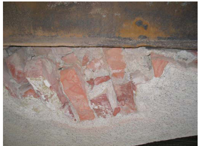
Vilpolan aukon tiilestä muurattu holvikaari, päällä teräspalkki. MS 6.7.2010
