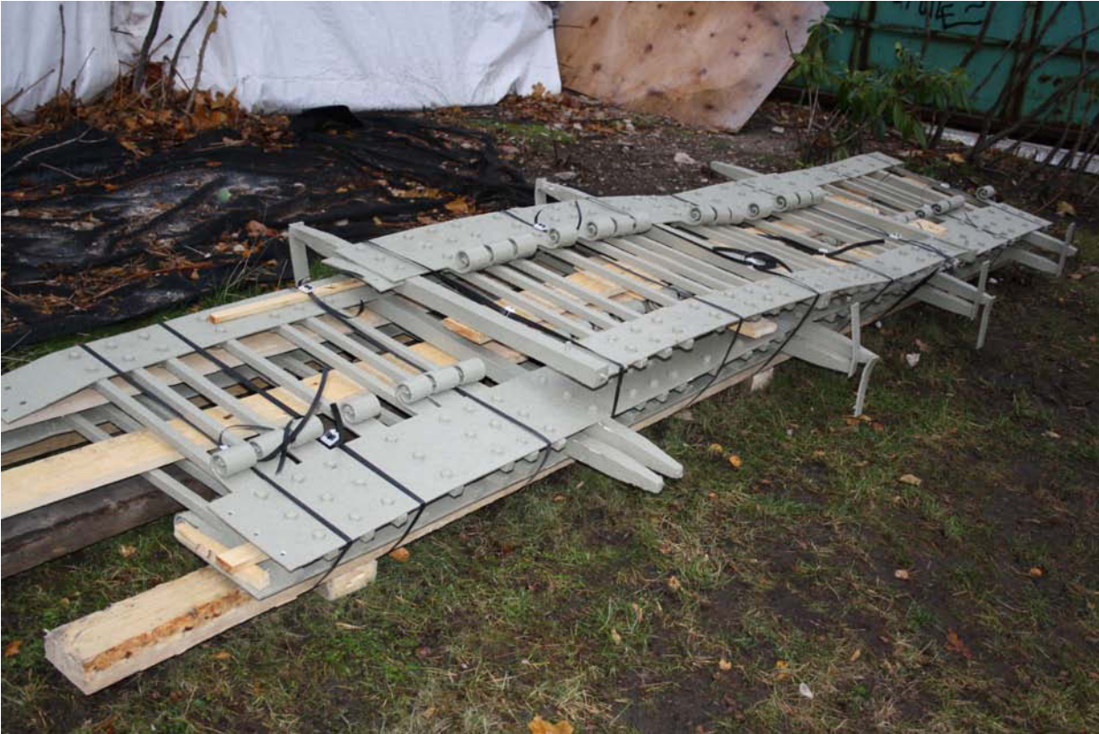
Kunnostettu ja öljymaalattu takorautakaide. MS 11.11.2010.
