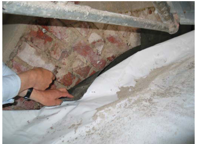
Vanha alushuopa nostettuna muurin pintaa vasten. MS 18.8.2010
