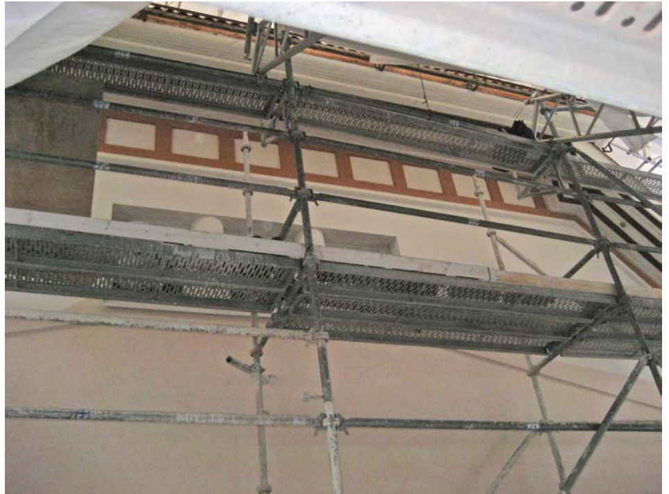
Kaakkoispäättyyn palautettiin ruutuaiheen kaksivärisyys. Taustalla valkea julkisivupinta, alempana sävytetty pinta. MS 23.11.2020
