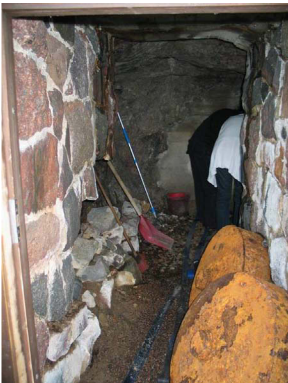
Väestönsuojan rannanpuoleisen käytävän ylätasanne. MS 2009.
