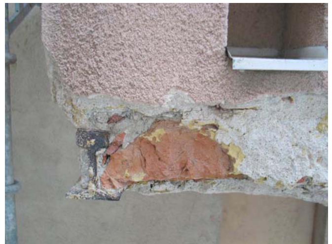
Ratakiskopalkki parvekkeen reunassa. MS 6.7.2010
