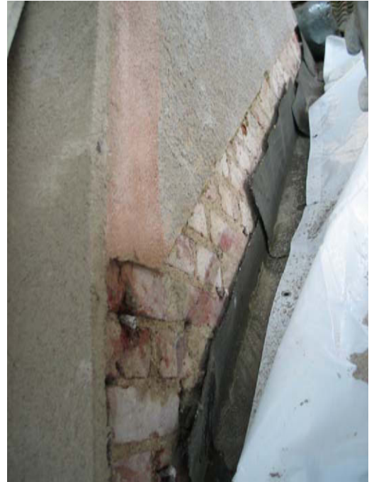
Vanha alushuopa nostettuna muurin pintaa vasten. MS 18.8.2010
