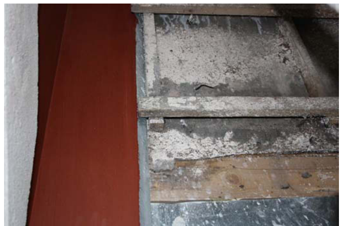
Sama kohta korjattuna ja pellitettynä. MS 26.10.2010
