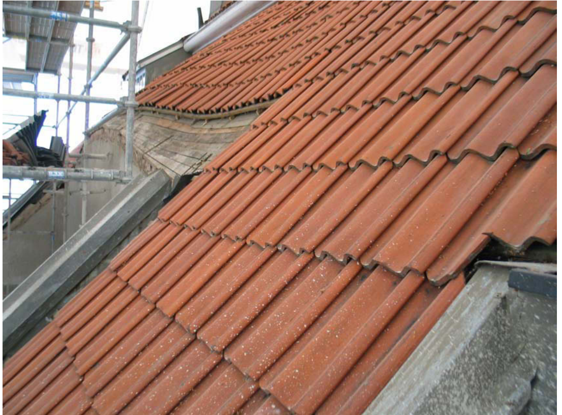
Kaarevaan räystäslinjaan liittyvä kaareva kattopinta. MS 18.8.2010
