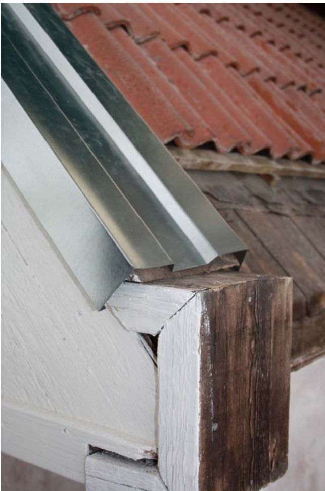
Luoteispäädyn tuulilauta ja räystäslaatikko. Peltiprofiilin mallikatselmus. MS 26.10.2010
