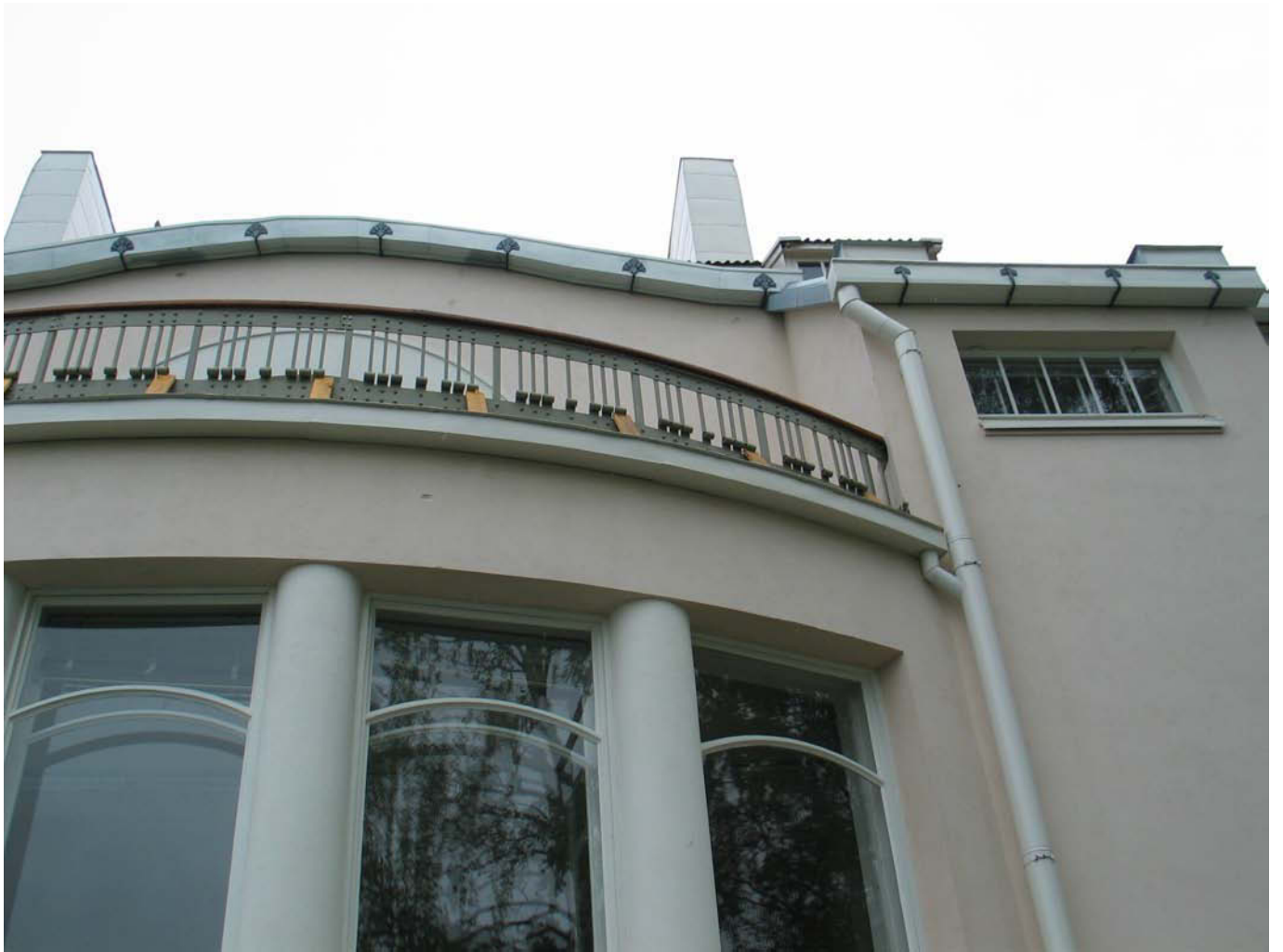
Lounaissivun korjattu parveke ja parvekekaide. MS 16.5.2011
