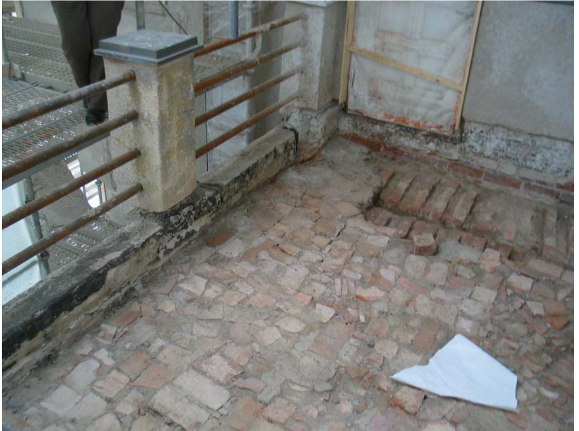
Purkuvaihe. Parvekkeen laatoituksen alusrakenteena vanha tiililadontakerros. MS 18.8.2010
