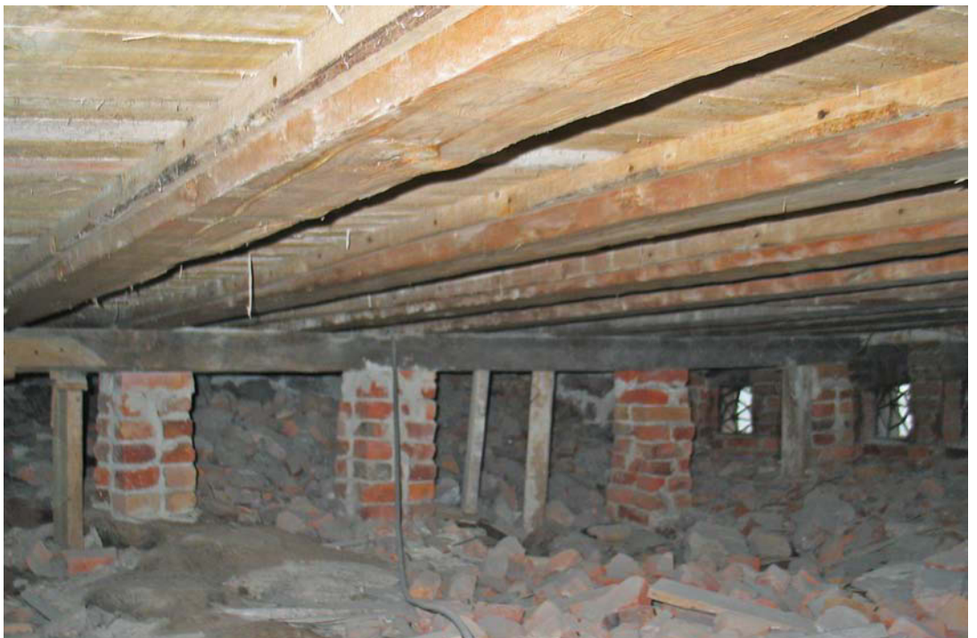
Alapohjan rossipohjarakenne ja tiilipilarituenta nähtynä kellarin perusmuuriin puhkaistusta aukosta. Oikealla ryömintätilan tuuletusaukot lounaispuolella. MS 18.8.2010.
