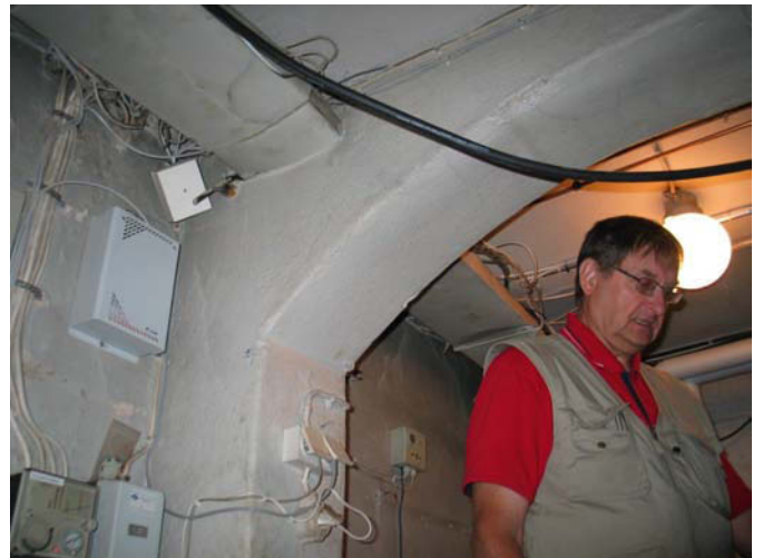
Rakennesuunnittelija Tapio Jauhiainen pohtii kellariin rakennettavaa tuentaa kevythissille. MS 10.8.2010
