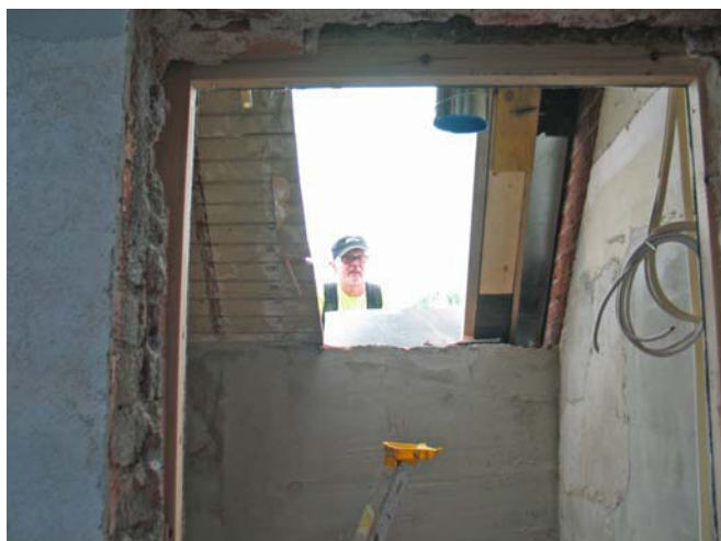
Vesikattorakenne avattuna pohjoiskulman lähellä. MS 20.6.2011
