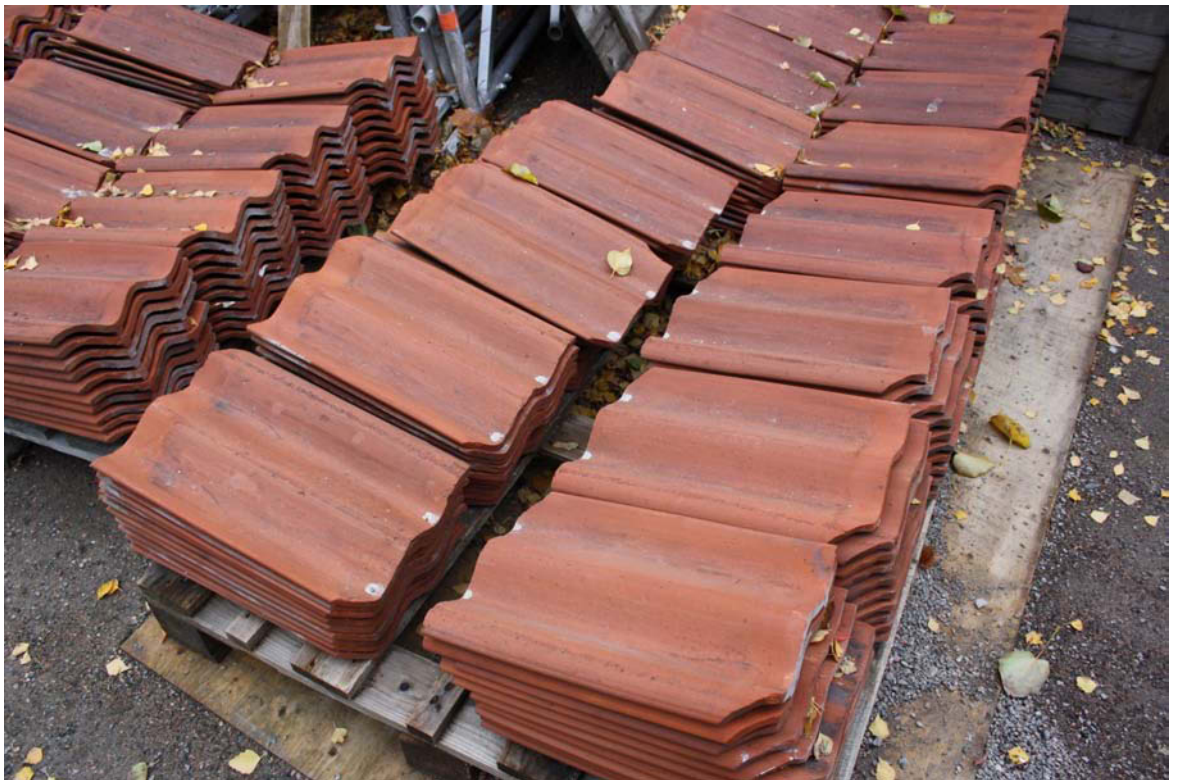
Kattotiilien puhdistus suoritettiin hiilihappojääpuhalluksella. MS 26.10.2010
