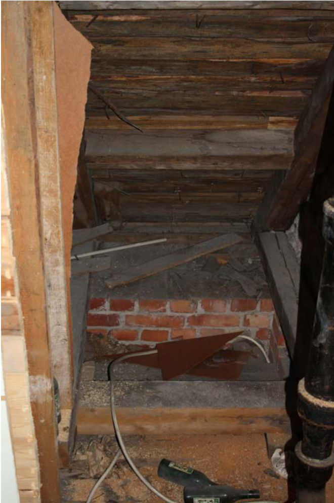
Huoneen 3030 komeron takaseinään avattiin uusi oviaukko ullakolle tarkastuskäyntejä varten. Kuvassa näkyy räystäään rakenne ullakon puolelta. MS 2.3.2011
