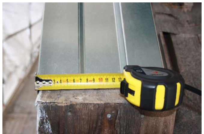
Luoteispäädyn tuulilaudan suojapellin mallikatselmus. MS 26.10.2010
