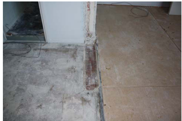
Pukeutumishuoneen 1950-luvun väliseinä on purettu ja kylpyhuoneen purku on alkamassa. Oikeanpuoleiseen tiilliseinäähän puhkaistaan uusi oviaukko esteettöntä wc:tä varten. Välipohjaan puretaan aukko uutta kevythissiä varten. MS 2.3.2011
