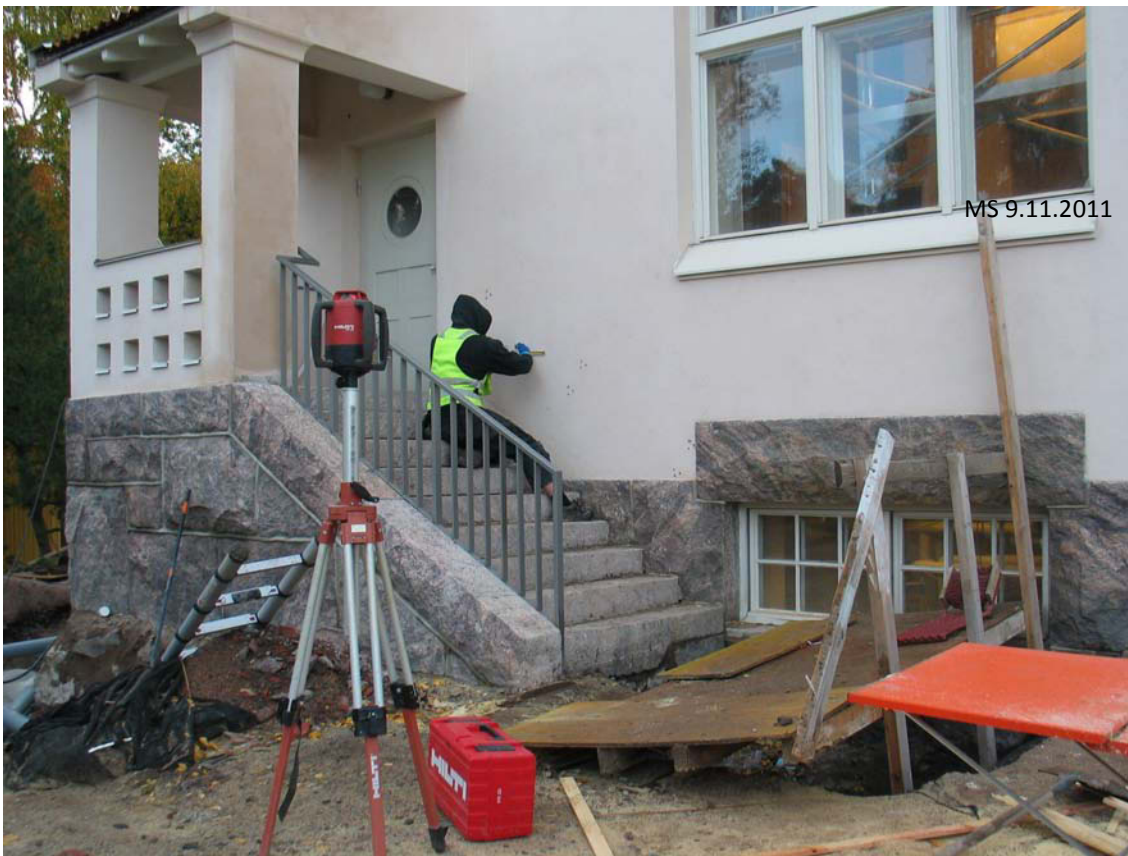
Uusi kaide on asennettu. Vanhempi käsijohde irrotetaan. MS 12.10.2011
