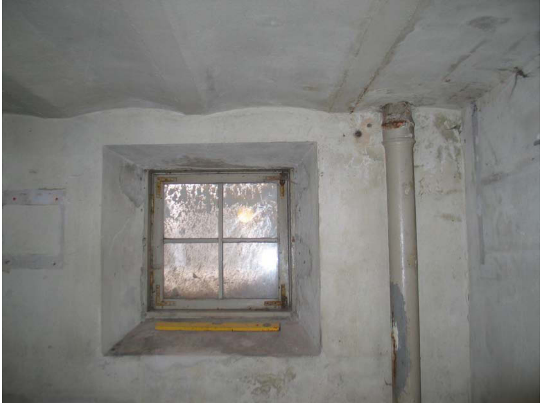
Elementtikylmiöiden purkaminen toi näkyviin 1970-luvulla sisäpuolella peitetyt kellarinikkunat. Kellarin välipohjana on kappaholvi. MS 10.8.2010.
