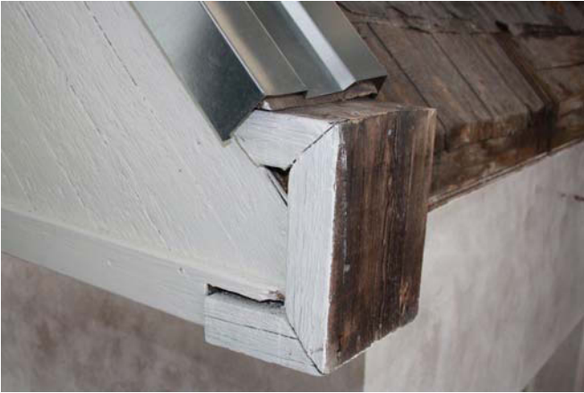
Luoteispäädyn räystäslaatikon pääte. MS 26.10.2010
