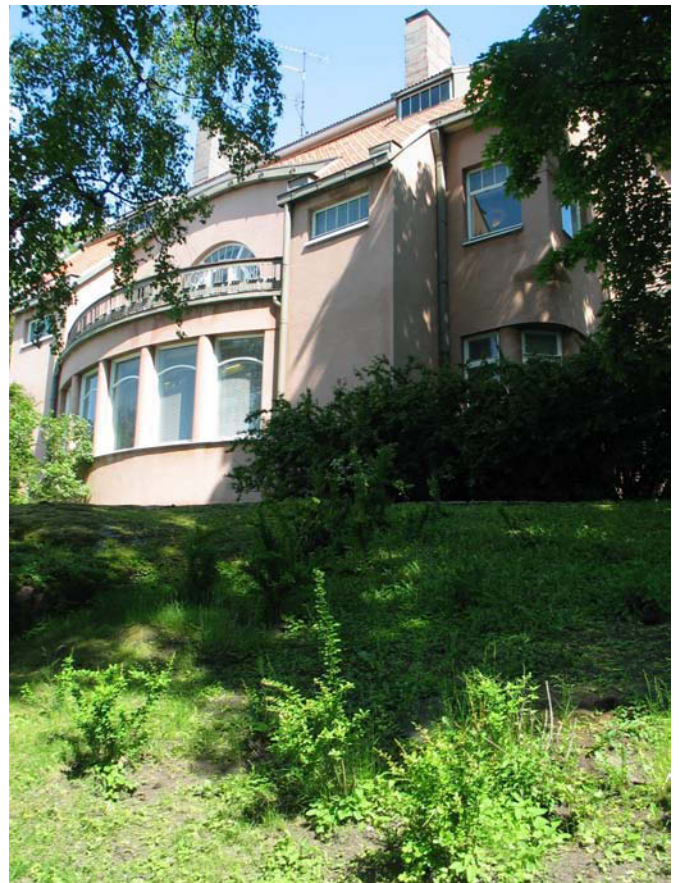
Julkisivu lounaaseen, merelle. Ms 13.6.2009
