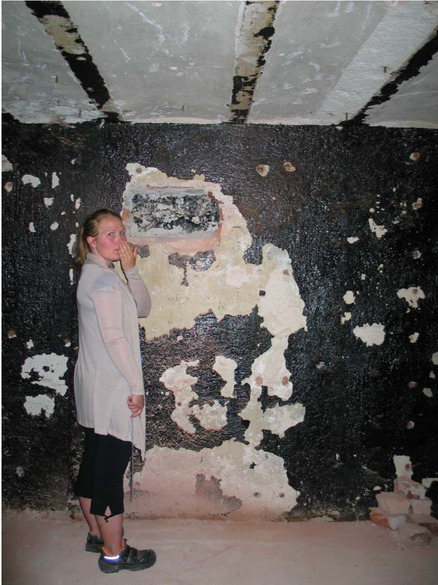
Projektinjohtaja, rakennuttajainsinööri Ilona Venetpalo, tekeillä kellarin perusmuuriin avattava tarkastusaukko. MS 10.8.2010.
