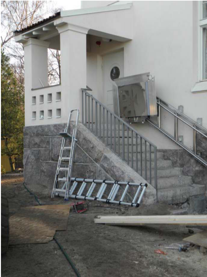
Porrasnostin asennettuna. MS 9.11.2011
