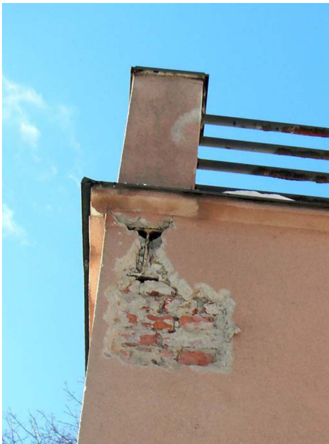
Vilpolan kulmassa on paljastettu I-teräspalkki. Kuva Ilona Venetpalo maaliskuu 2010, MV.
