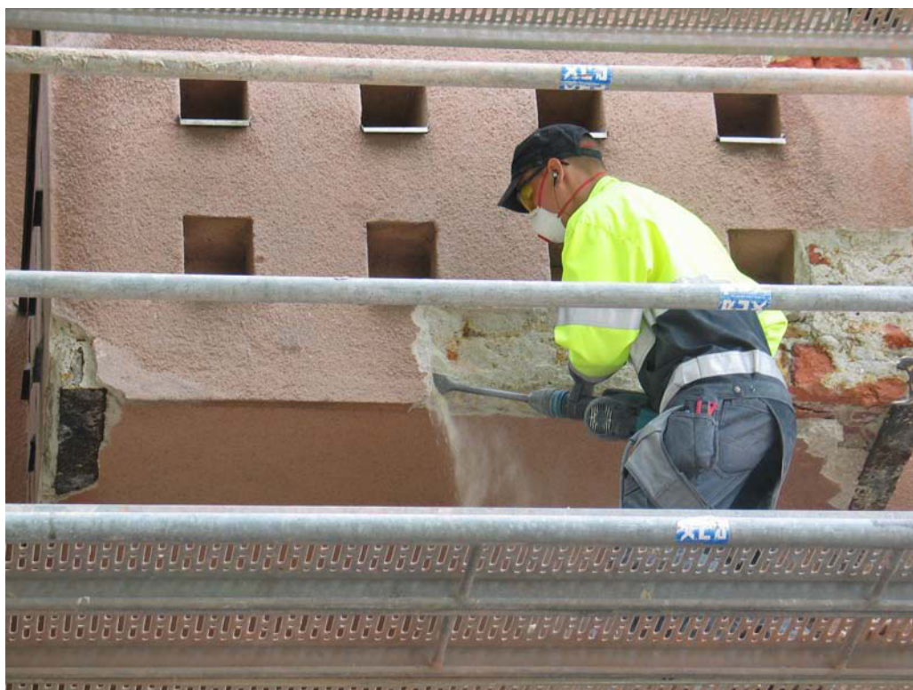
Purkutyö käynnissä. Kohde on luoteissivun uusittava parveke. MS 9.6.2010
