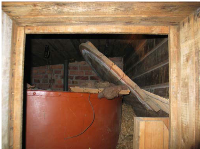
Ullakolla on vanha säiliö, jonka alapuolella on sijainnut ensimmäinen kylpyhuone.
