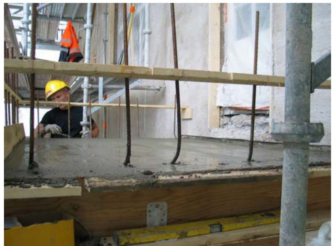
Luoteissivun parvekelaatan valutyö. MS 18.8.2010
