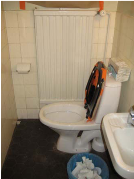
11 2 6-kulmainen keraaminen lattialaatta. VP 18.6.2010
