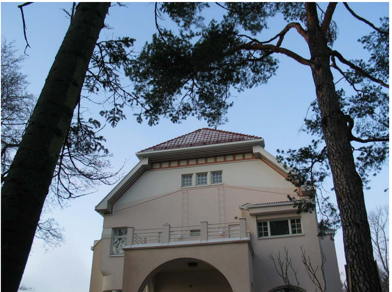
Julkisivumaalaus ja parvekekorjaus valmiina. MS 22.12.2011
