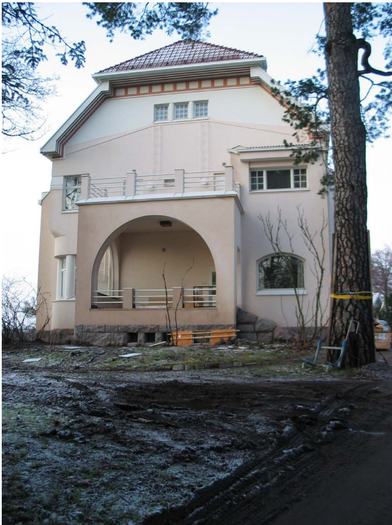
Pääty kaakkoon. Peruskorjattu vilpola ja uudestaan rakennettu parvekekaide pellityksineen. Kaksivärinen räystäslaatikko on maalattu punaisella sävyllä, joka perustuu suunnittelijoiden tulkintaan alkuperäisistä periaatteista. MS 22.12.2011
