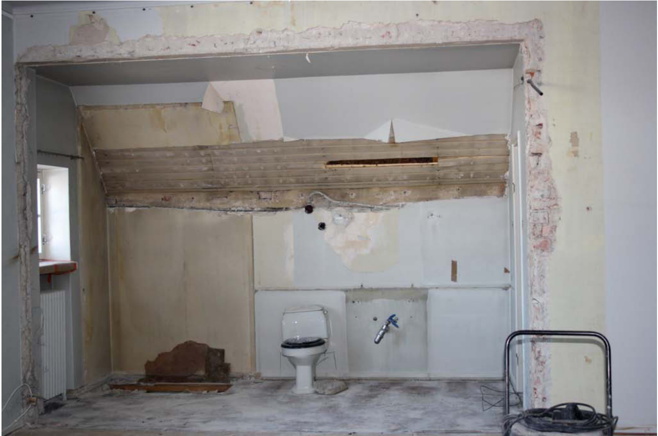
Pukeutumishuoneen 1950-luvun väliseinä on purettu ja kylpyhuoneen purku on alkamassa. Oikeanpuoleiseen tiilliseinäähän puhkaistaan uusi oviaukko esteettöntä wc:tä varten. Välipohjaan puretaan aukko uutta kevythissiä varten. MS 2.3.2011
