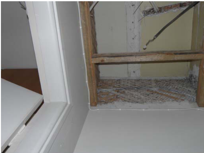
2. kerros h. 212 välikön katto, vanhat maalipinnat ja puretun seinän säilyneet jäljet näkyvät alakaton yläpuolella. MaS 1.6.2011
