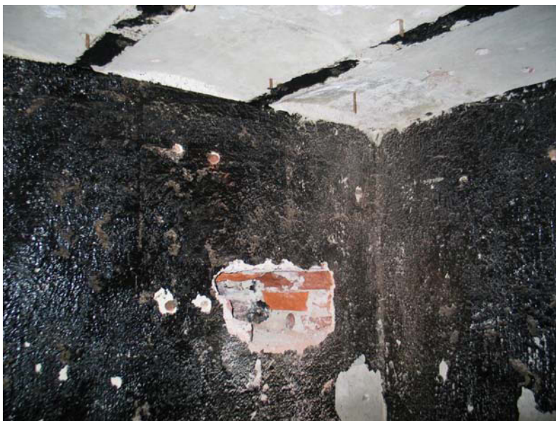
Kellarin perusmuuriin purettiin aukko ryömintätilaan. Ensimmäinen yritys ei onnistunut, vaan uusi aukko tehtiin eri kohtaan. MS 10.8.2010
