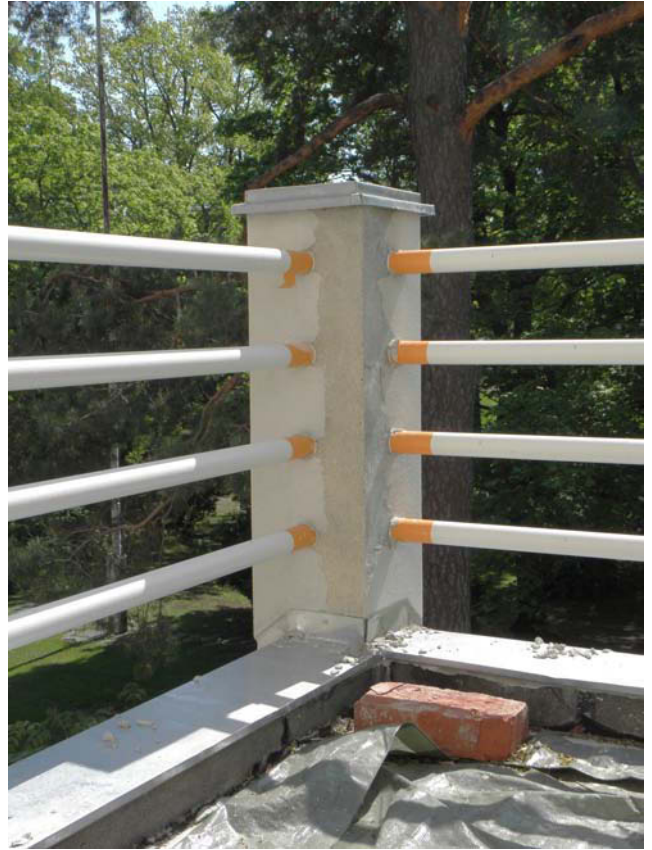
Uudet kaidepilarit, putket ja peltihatut. MaS 1.6.2011
