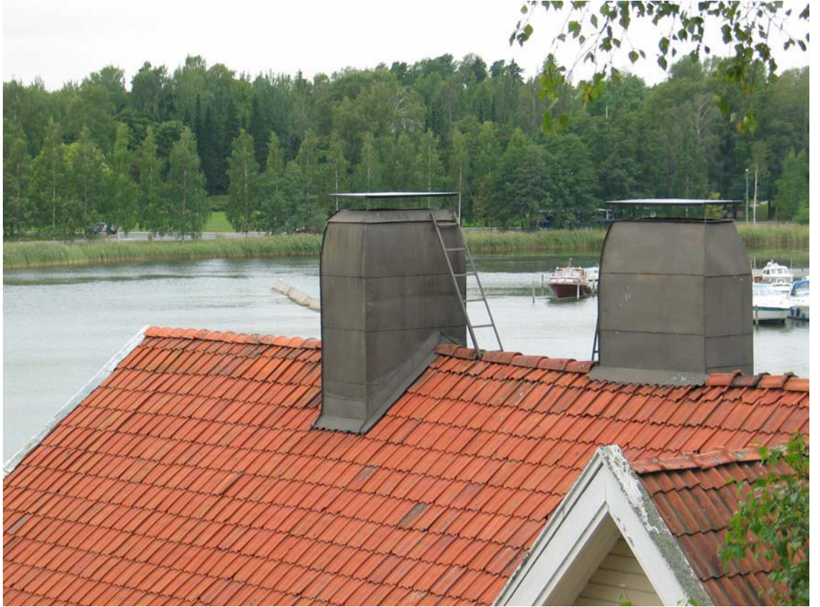
Eteläisen lappeen kaksikouruinen kattotiili on samaa tyyppiä kuin päärakennuksen vuonna 1956 uusitus- sa vesikatteessa, joka uusittiin vuonna 1974 ruotsalaisilla savikattotiilillä.
