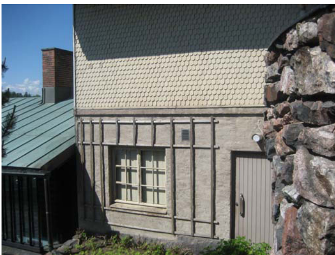
Länsipään kellarin tiilestä muurattu ulkoseinä on muutettu vuonna 1956 ja ilmeisesti silloin slammattu. Ulkoseinän slammaukset on mahdollisesti uusittu vuonna 1975.
