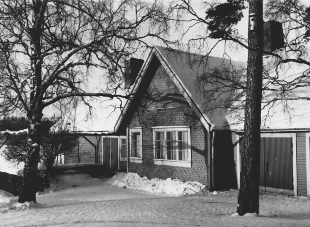
Eteläsivu. Ulko-ovien väritys on julkisivupintaa tummempi. Kuva Timo Syrjänen, MV
