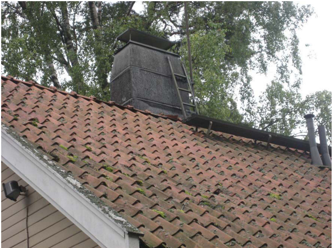
Pohjoisen lappeen yksikouruinen kattotiili on samantyyppinen kuin päärakennuksen alkuperäisessä vesi- katteessa vuodelta 1904.
