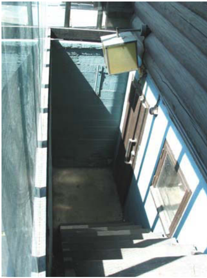
Eteläsivu. Portaat saunan maanalaiseen lämmityshuoneeseen.
