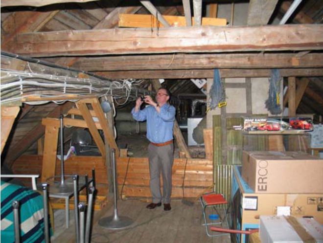
Huoltorakennuksen hirsirungon yläosat näkyvät ullakkotilassakin.
