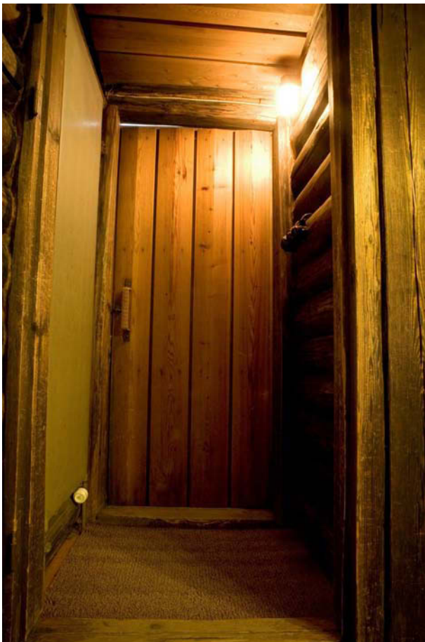
Pyöröhirsiseinällä erotettu tuulikaappi on vuodelta 1956. Ovi on päällystetty muotohöylätyllä mäntypaneelilla. Kuva Saara Salmi, MV
