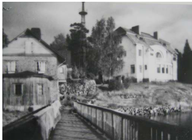
Valokuva laiturin suunnalta. Vasemmalla talousrakennuksen pääty v. 1915 suunnitelma vastaavassa asussa. Kellarin julkisivu on puhtaaksi muurattua tiiltä. Edessä puurakenteinen, monikulmainen puuvaja. Pihaterassilla näkyy tuulipumpputorni. Kuva on mahdollisesti 1920-luvulta. MV nro 188330
