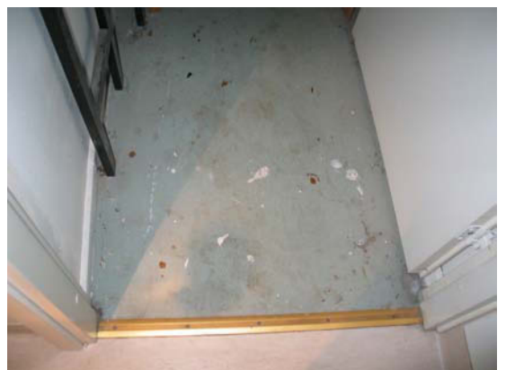
Autovajan takaseinä rajaa kapean käytävän / varaston ulkoseinän viereen. Lattia on betonia.
