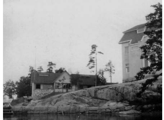
Talusrakennus ennen itäpään laajennusta. Anne Marie Appelgrenin valokuvakokoelma Nissenin perheen ajoilta. www.livsstiggar.se
