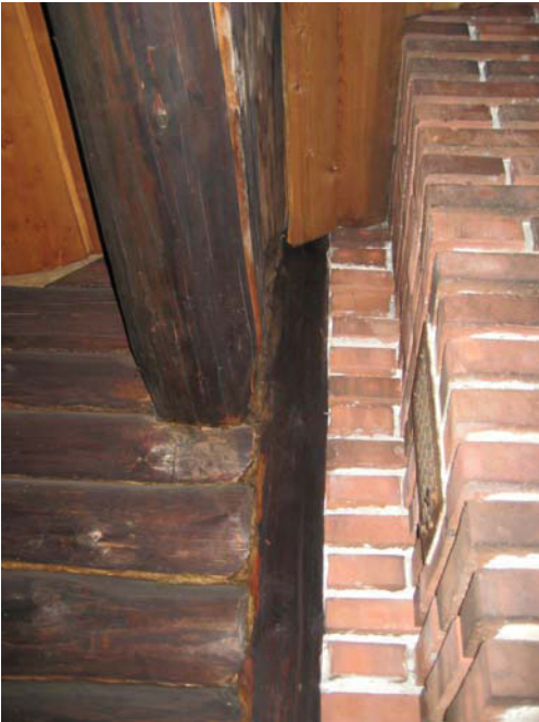
Tiilimuurauksen liitos lamasalvottuun hirsi-seinään.
