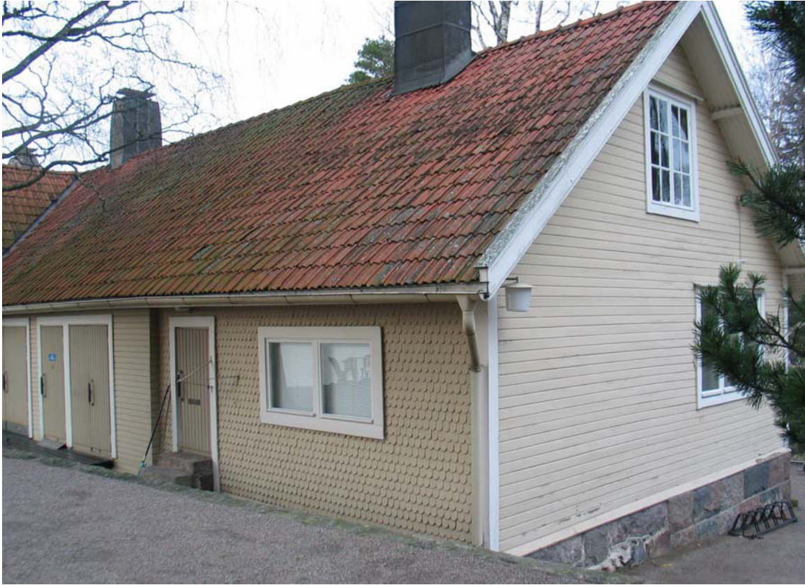
Itäpään eteläsivulla on paanuverhous, päädyssä vaakapaneeli. Ikkunat ovat 1900-luvun alusta ja 1940-1950-luvulta.
