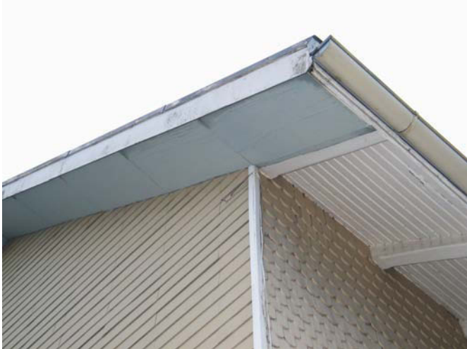
Saunan puoleisen länsipäädyn julkisivu ja räystääs verhottu palosuojauksen takia mineriittilevyillä.
