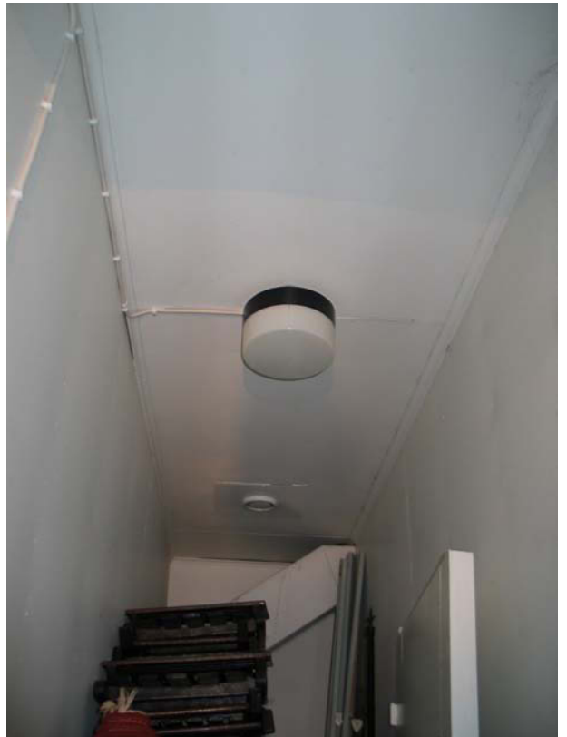
Käytävän rankarakenteiset seinät on verhottu levyillä.
