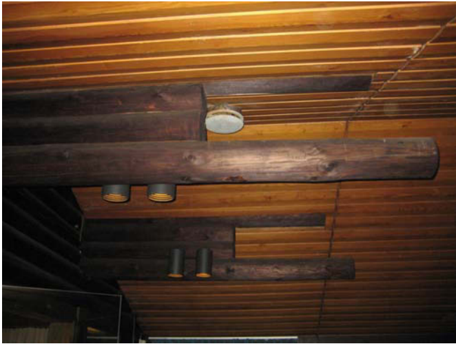
1 Vanhemman saunarakennuksen kuistin katon pyöröhirsi-rakenteet ovat säilyneet uima-allastilan puolella.
