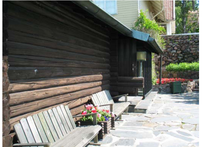
Eteläsivu. Uima-allasosan hirsipaneeliseinä.
