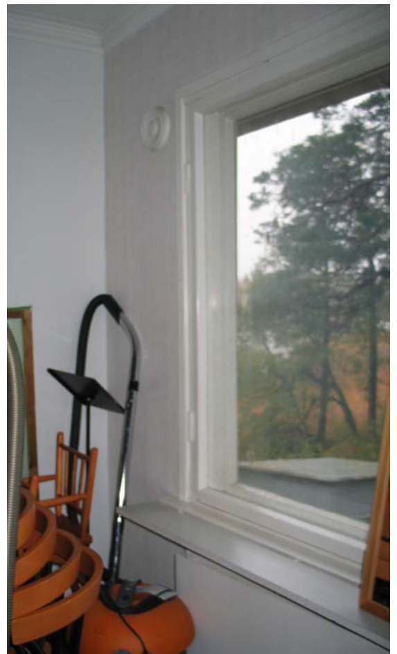
Ikkuna on 1950-luvulta.
