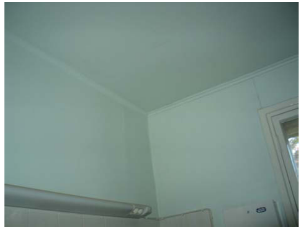
Seinät ja katto on päällystetty levyillä, saumat on tasoitettu. Katonrajassa on pieni holkkalista.
