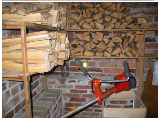
Välipohja on rautapalkkien kannattama muurattu kappaholvi.
