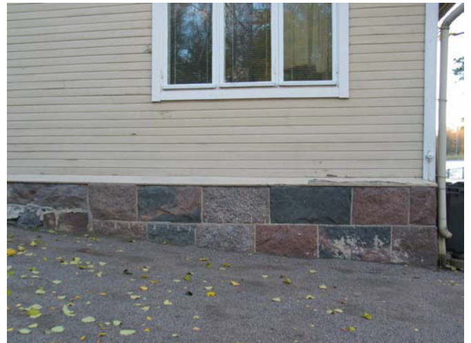
Itäpäädyn laajennusosan sokkelimuuri on rakennettu säännöllisistä harkoista v. 1904 jälkeen.
