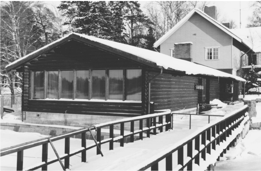
Uima-altaan pääty ja laituri. Kuva Timo Syrjänen, MV 184916
