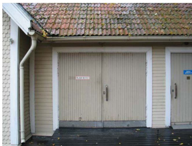
Autovaja on rakennettu entiseen, rankarakenteiseen vajaan 1940-luvun alussa. Julkisivuverhouksena on vaakasuuntainen ponttilauta.
