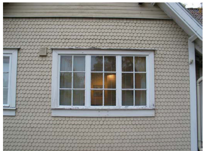
Vanhimman hirsirunkoisen osan pieniruutuiset ikkunat ovat vuoden 1904 rakennusvaiheesta. Paanupäällyste lienee vuodelta 1915. Kylmän ullakkotilan julkisivussa on vaaka-paneeli.
