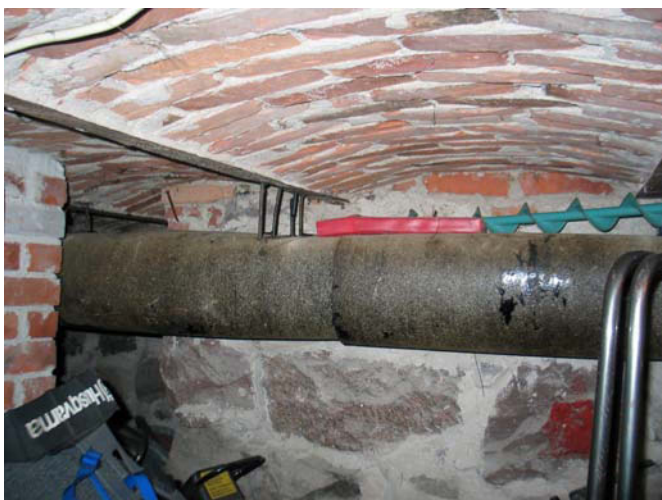
Taustalla harmaakivimuurausta, tulisijan ja hormiryhmän perustus.
