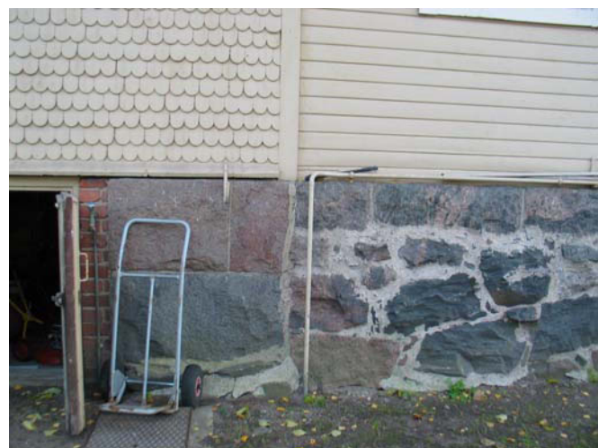
Pohjoissivun uudempi harkkokivisokkeli (1915), vanhempi sokkeli oikealla.
