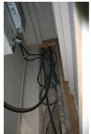
Lattia on betonivalua. Seinät ja katto on levytetty.
