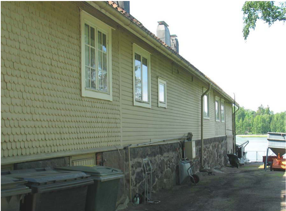
Pohjoissivun päätyosissa on paanupäällyste ja keskiosassa, joka on muutettu lämpimiksi tiloiksi vuonna 1956, on vaakapaneelijulkisivu. Etualalla itäpään pieniruutuinen ikkuna 1900.luvun alusta.
