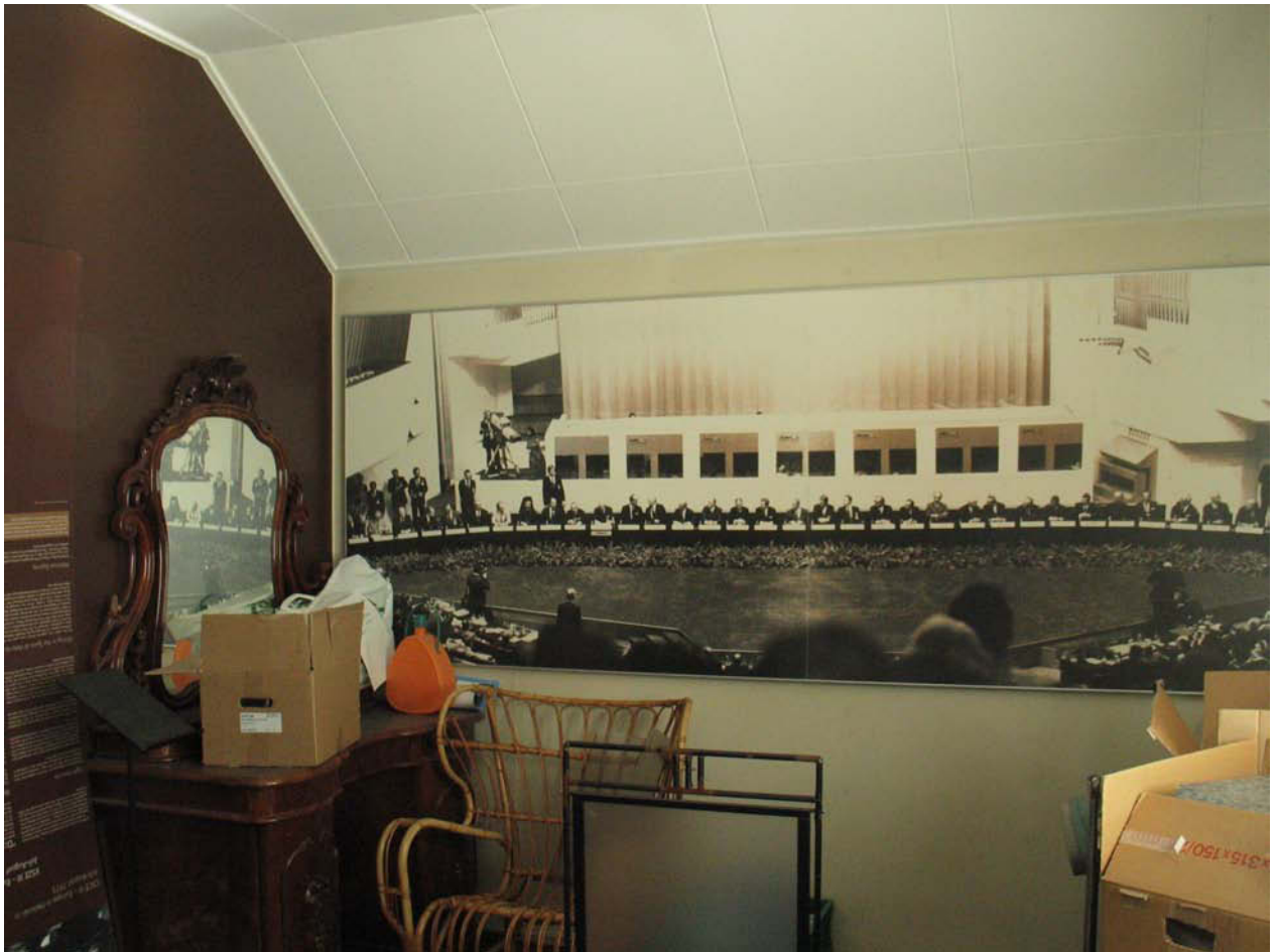
Seinät on päällystetty levyillä, saumat tasoitettu. Katto on vuorattu viistoreunaisilla kuitulevyillä.
