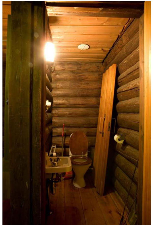
Pyöröhirsiseinällä erotettu wc-tila on vuodelta 1956. Ovi on päällystetty muotohöylätyllä mäntypaneelilla. Kuva Saara Salmi, MV
