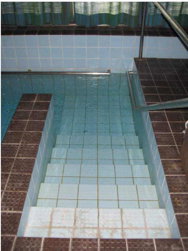
Portaat on laatoitettu nastapintaisilla laatoilla ja altaan seinät sileillä.
