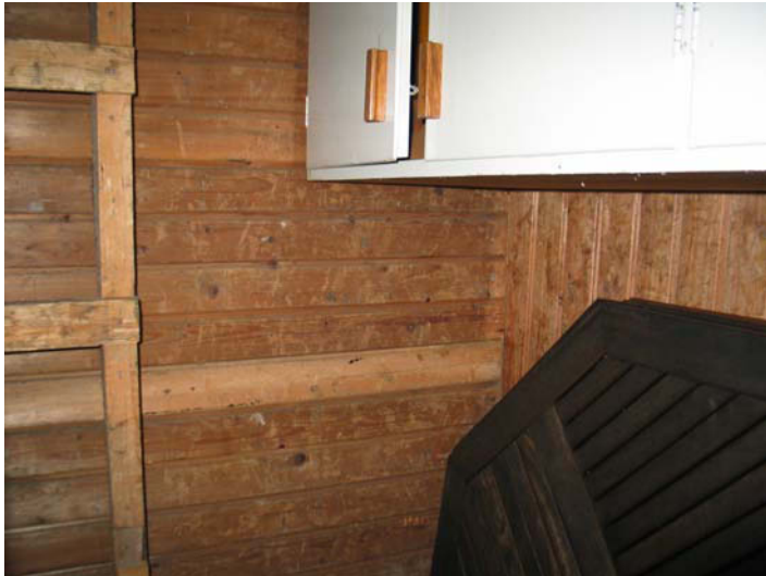
Eri seinillä on eri vaiheissa rakennettuja puupaneeliverhouksia. Vasemmalla ullakon tikkaat. Seinällä 1950-luvun keittiöstä tai tarjoiluvälisestä siirretty kaapiston yläkaappi
