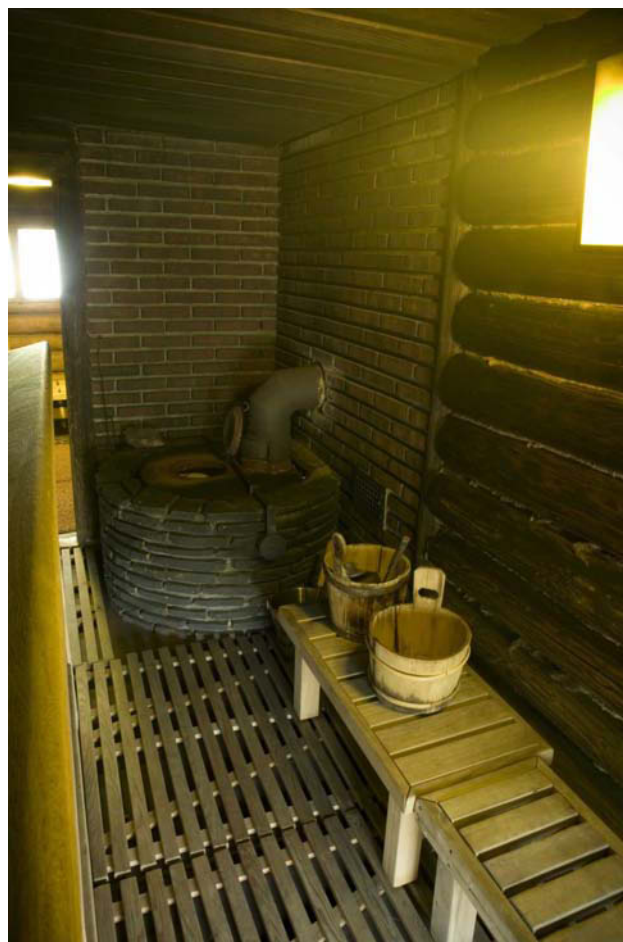
Kiukaan viereinen hormimyrhmä ja väliseinä on muurattu tummaksi poltetusta punatiilestä korostetu in vaakasaumoin. Kuva Saara Salmi, MV
