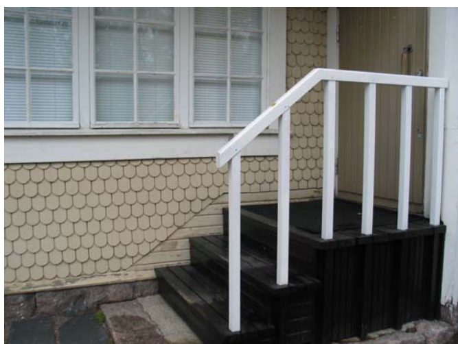
Huoltorakennuksen entisen väentuvan, museokahvilan ulkoportaat on uusittu 1990-luvulla.
