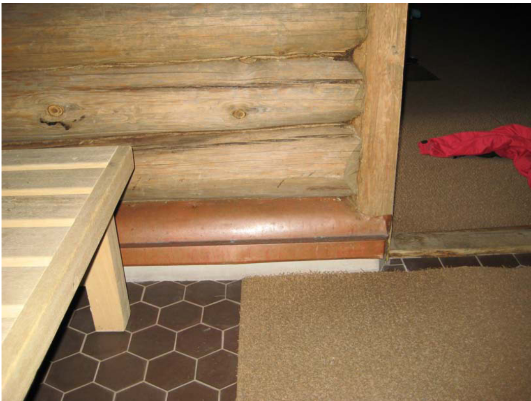
Lattian laatoitus on mahdollisesti uusittu 1970-luvulla. Jalkalistana on muotoiltu kuparipeltiprofiili.
