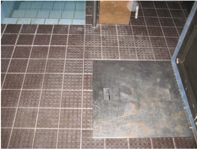
1 Uima-altaan huoltokäytävän luukku on ruostumatonta terästä.
