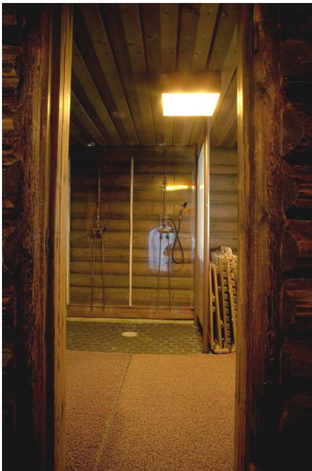
Näkymä takkahuoneen oven suunnalta. Suikhujen taka-seinässä on muovilevyt hirsiseiniin suojana. Kuva Saara Salmi, MV
