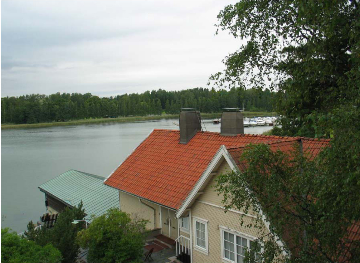
Huoltorakennuksen eteläinen lape ja poikkipäätty, taustalla sauna- ja uimahallirakennuksen kuparikatto.
