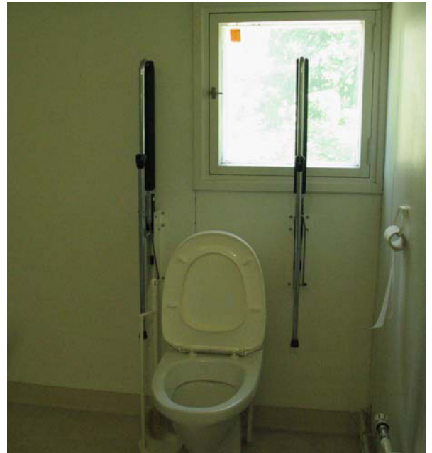
Käytävän päähän on 1994 rakennettu 1994 levyrakenteinen, esteetön WC-tila.
