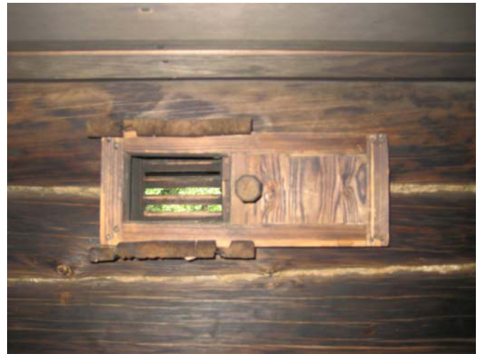
2 Puusta tehty räppänä pohjoisseinässä.
