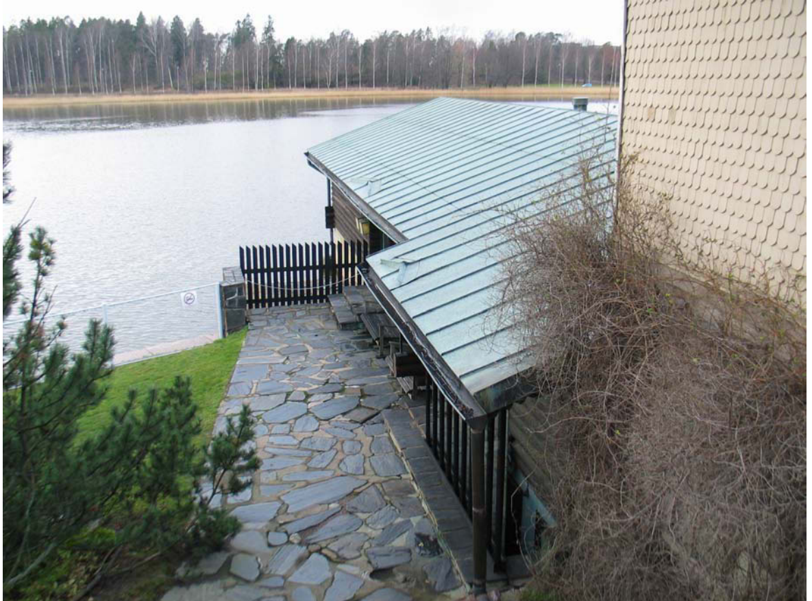
Liuskekivillä kivetty terassi sauna- ja uima-allasrakennuksen eteläpuolella on rakennettu nykyiseen asuunsa uima-allaslaajennuksen yhteydessä 1969 ja korjattu myöhemmin. Laituri on purettu.
