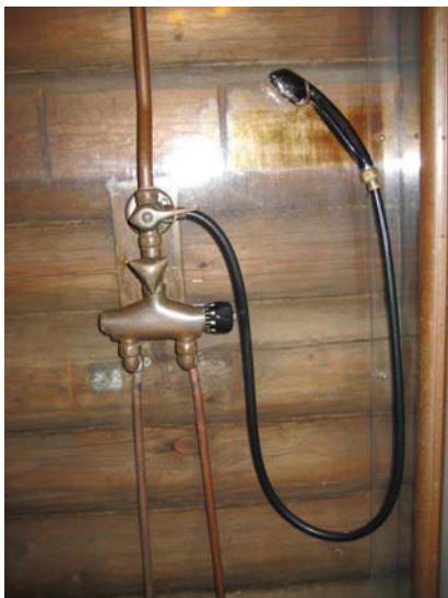
Hirsiseinä on suojattu muovilla.
