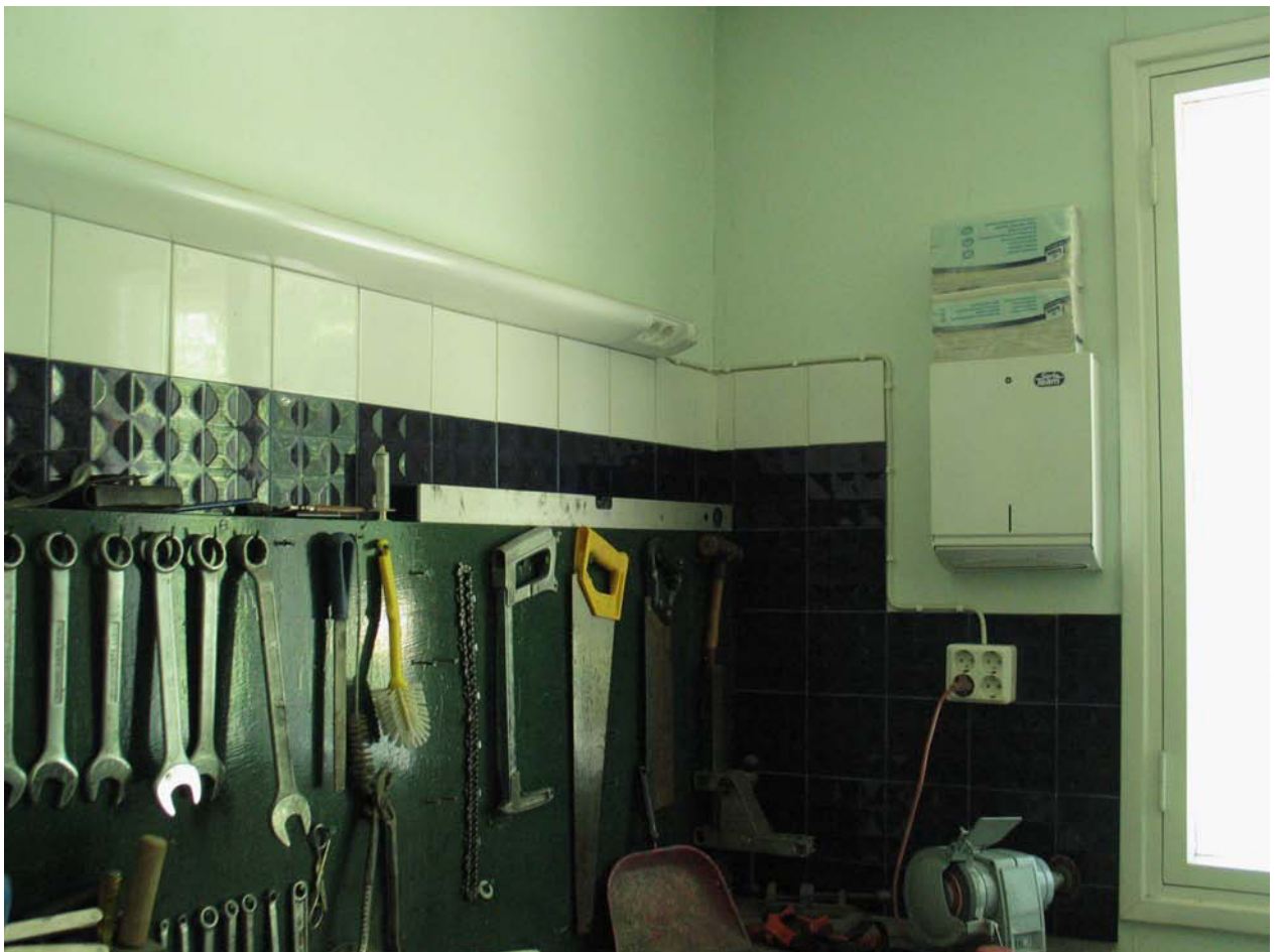
Entisen silityshuoneen työtason taustan laatoitus on sama kuin päärakennuksen kylpyhuoneessa 215. Kuvat MS
