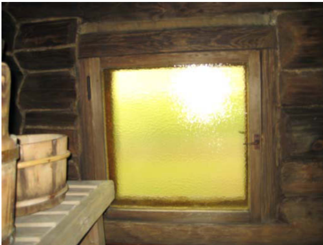
1 Ikkuna pohjoisseinän alaosassa. .
