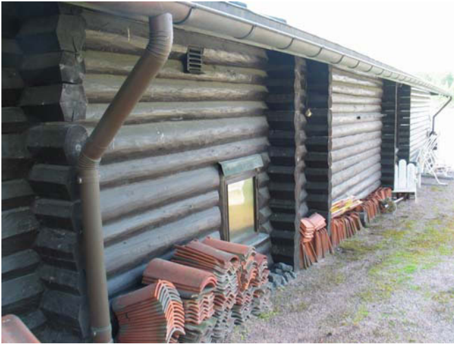
Pohjoissivun saunan lamasalvottu pyöröhirsiseinä vasemmalla, sen jatkeena on uima-allasosan hirsipintainen, teräsrunkoinen ulkoseinä.
