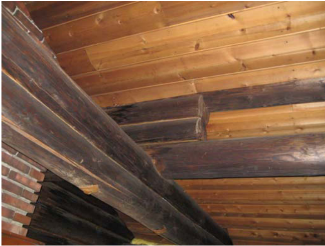
Pyöröhirsirakenteeseen kuuluvat katonkannattajat.
