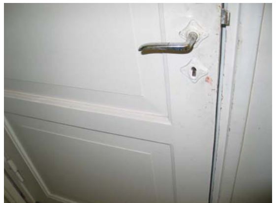
Käytävän ovi on peilimallia, mahdollisesti 1920-40-luvulta.
