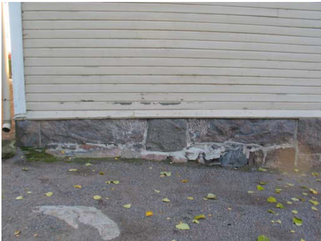
Itäpäädyssä näkyy vanhimman osan sokkelimuurin jäänteitä.
