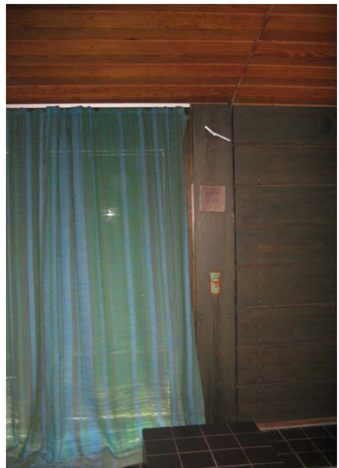
4 Eteläseinän laiteasennus ja kuparinen muistolaatta vuodelta 1969.
