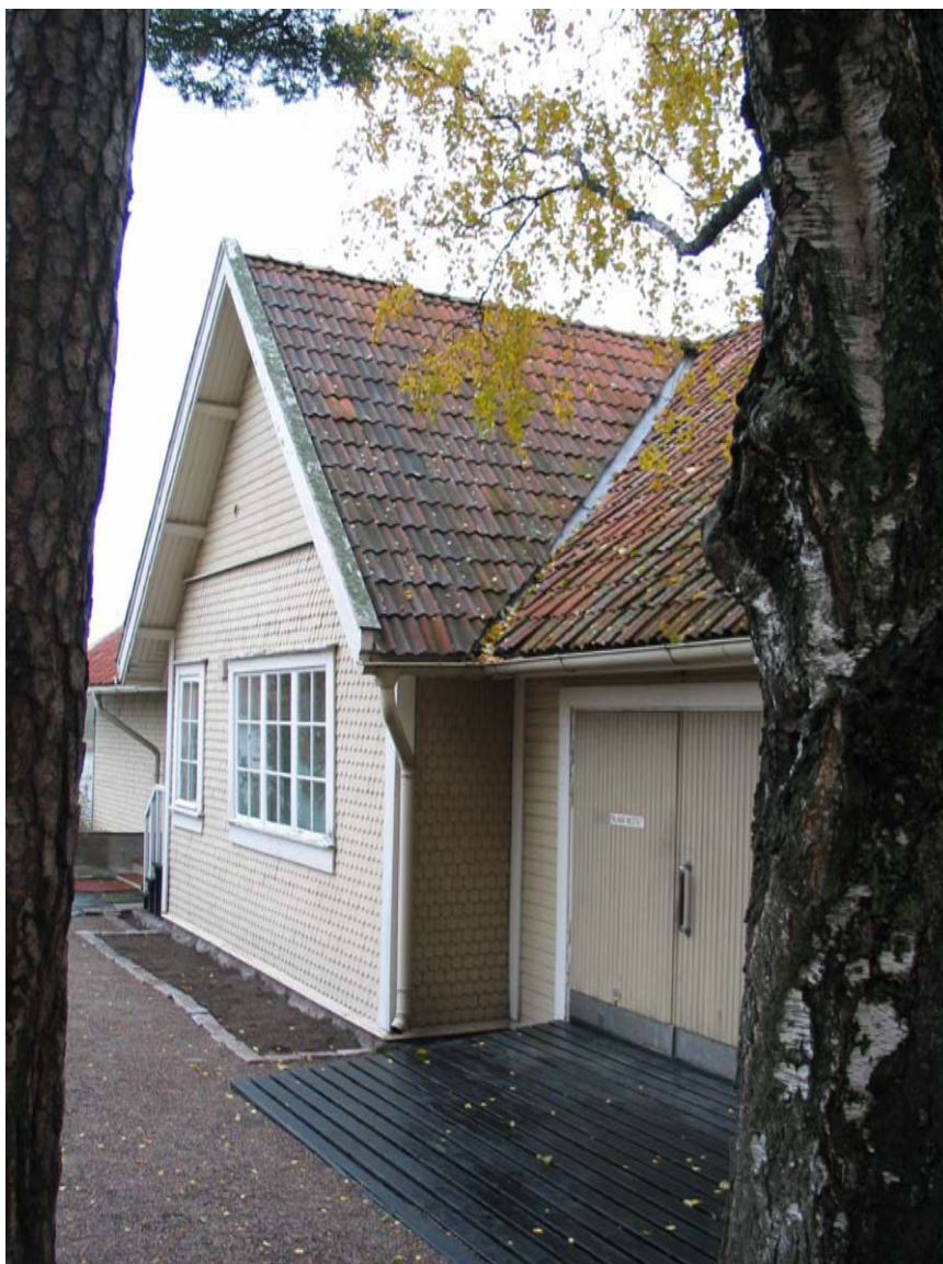
Julkisivu etelään. Hirsirunkoinen osa poikkipäättyineen ja paanujulkisivuineen. Etualalla rankarakenteinen autotalli- ja varasto-osa.
