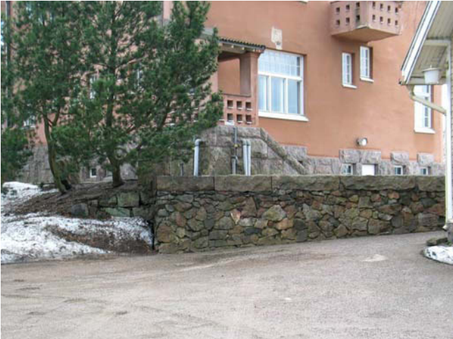
Huoltorakennuksen ja päärakennuksen välisen pihan terassimuri
