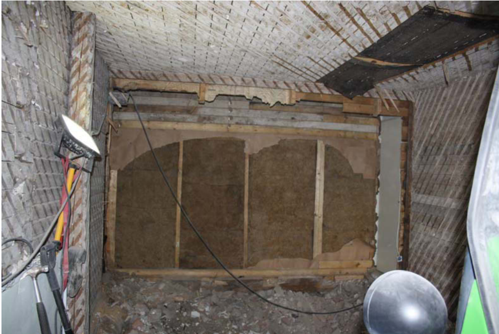
Autovajan purkutyö. Taustalla pohjoinen ulkoseinä. MS 2.3.2011
