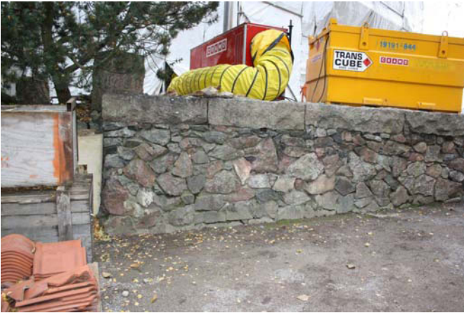
Päärakennuksen ja huoltorakennuksen välinen tukimuuri, nykyasussaan muuri lienee 1950-luvulta. MS 26.10.2010
