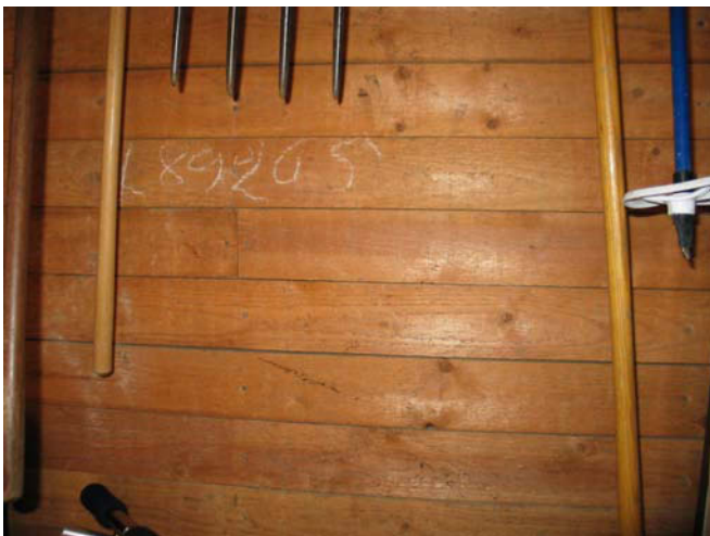
Länsiseinän vaakalautaverhous ja suksitelineet. MS 29.10.2009
