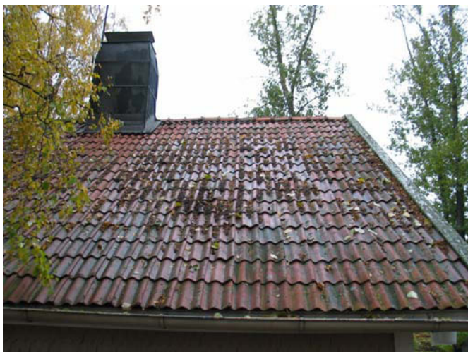
Eteläinen lape, kaksikouruinen kattotiili. MS 23.10.2009
