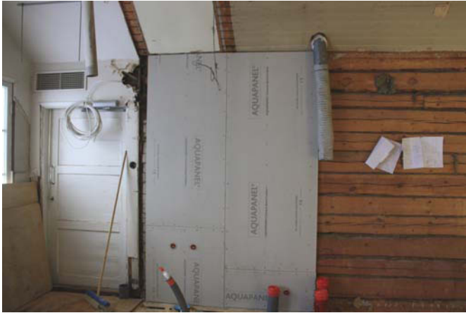
T113 Kahvila. WC-tilojen rakentaminen on alkanut. Seinien levytys. MS 22.9.2011
