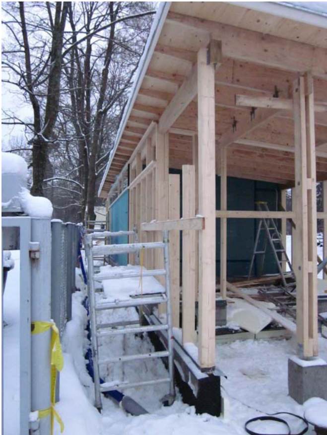
Pihavajan julkisivutyö. MS 20.1.2012
