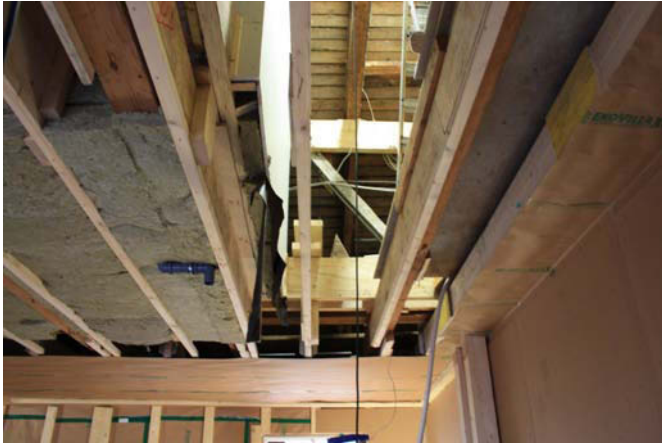
T110 Kahvila. Vahvistettu yläpohjarakenne. MS 22.9.2011
