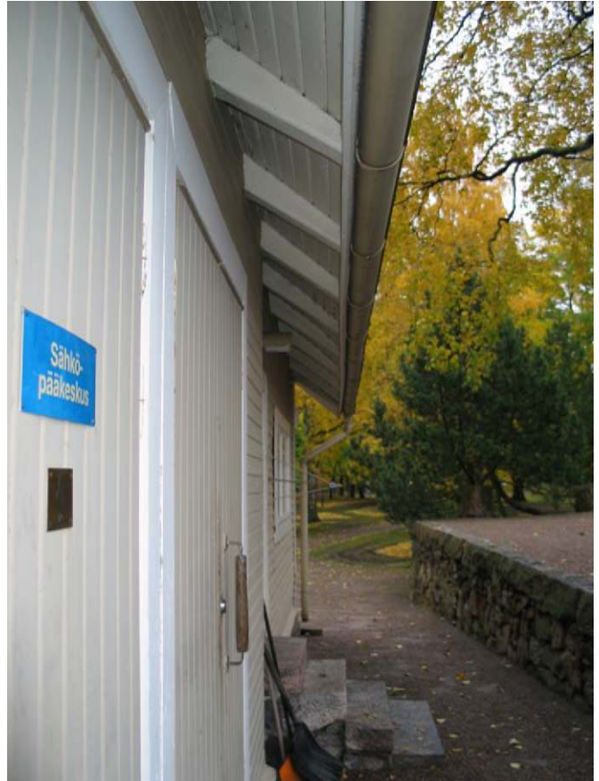
Eteläsivun ulko-ovet ja räystääs. MS 2009
