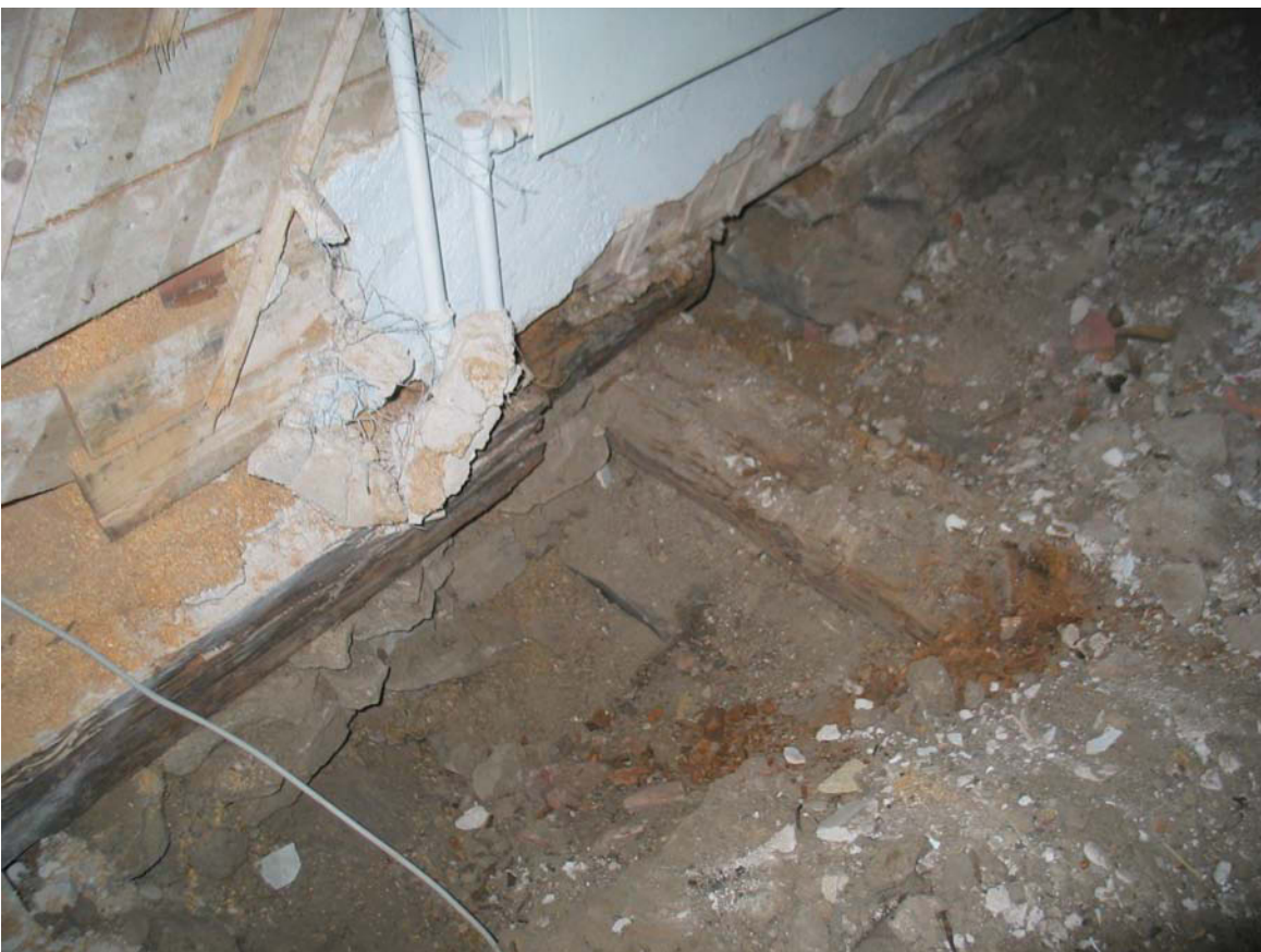
Autovajan itäseinä. Alapohjan purkutyö jatkuu. MS
