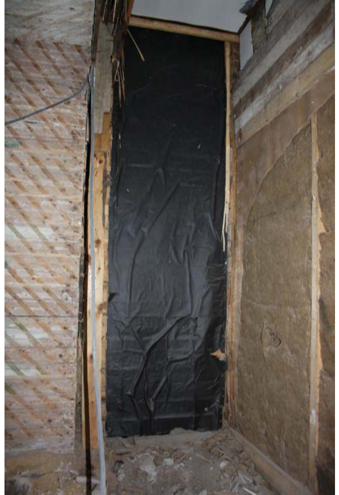
Vanha oviaukko autovajan länsiseinässä, oikealla pohjoinen ulkoseinä . MS 2.3.2011
