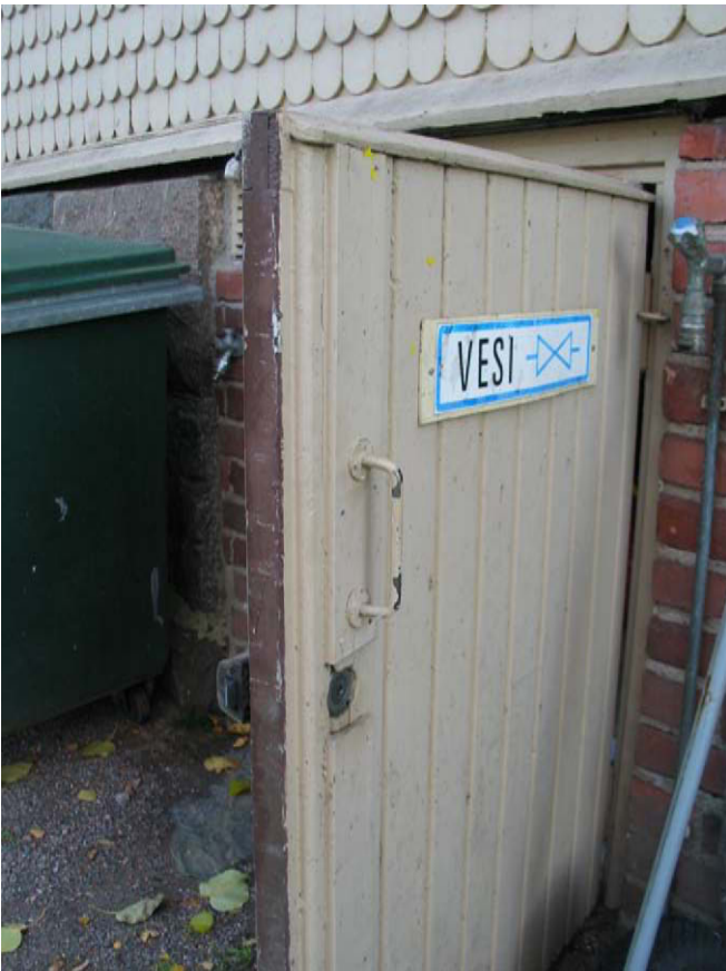
Pohjoissivun kellarin ulko-ovi. MS 29.10.2009
