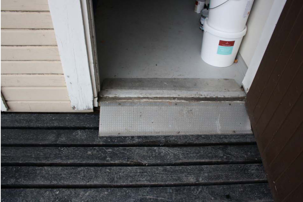
Esteettömän wc:n ja huoltokäytävän ulko-ovi, kynnyskiila ja lpuurakenteinen sisäänkäyntitaso. MS 26.10.2010
