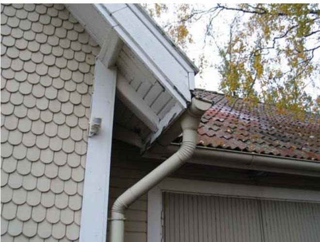
Eteläinen lape, Syöksytörvi ja räystään rakenne. MS 2009
