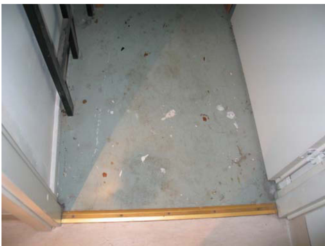
Autovajan pohjoissivulle rakennettu kapea käytävä. MS 29.10.2009.
