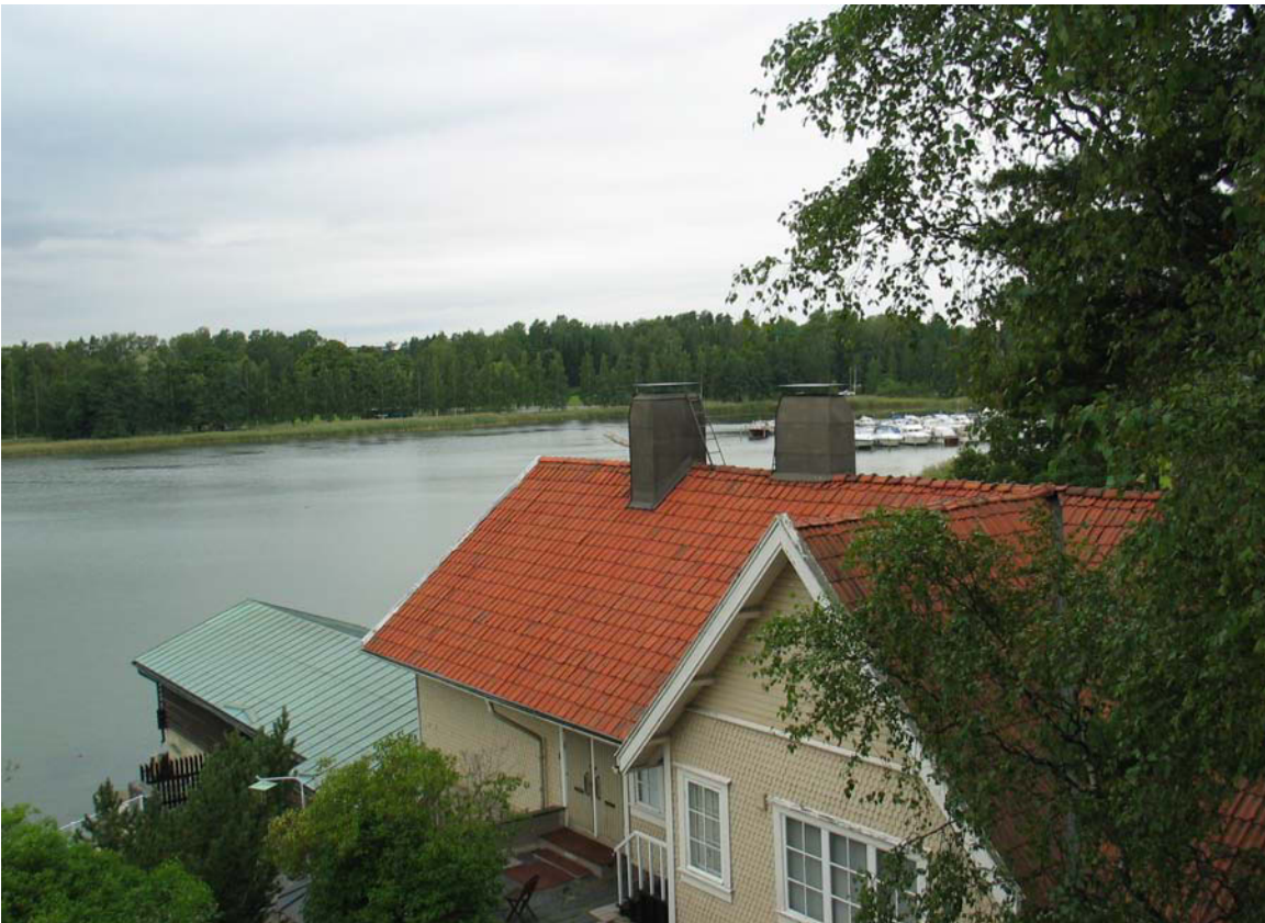
Eteläinen lape ja julkisivu, taustalla sauna- ja uimahallirakennuksen kuparikatto. MS 18.8.2010
