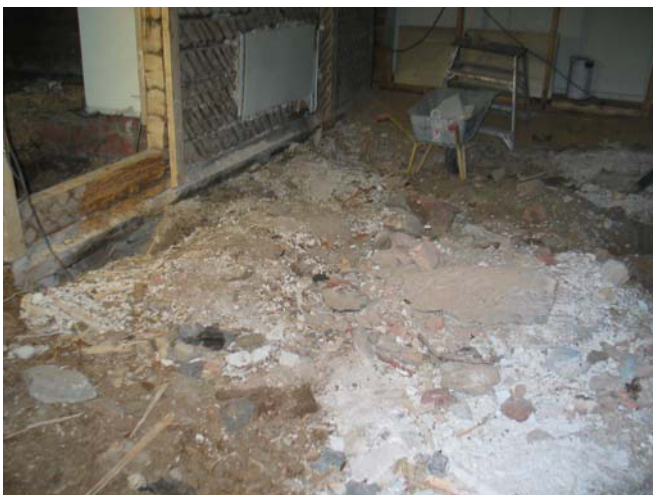
Autovaja. Lattian ja väliseinien purku. MS 23.2.2011
