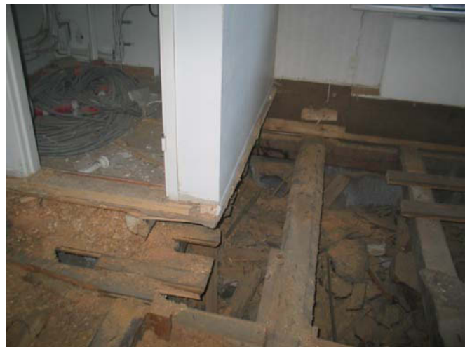
T114 Lattian purku. Vasemmalla siivouskomero. MS 23.2.2011
