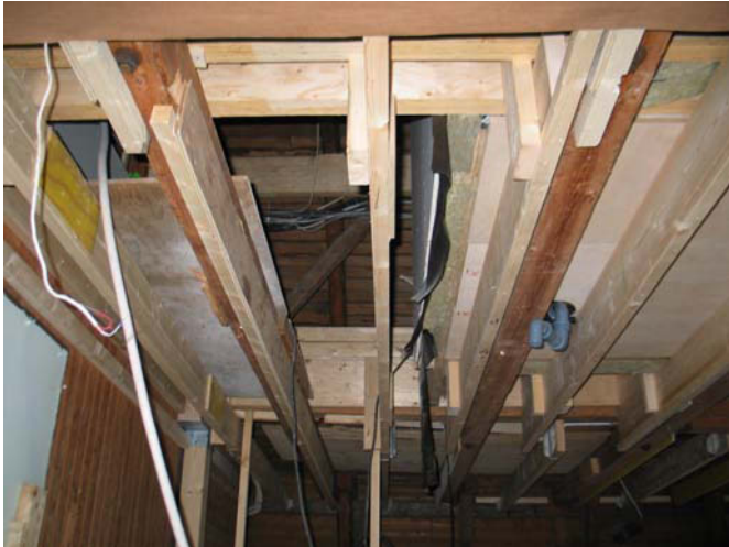
Yläpohjarakenteen lisäpalkit on asennettu, vasemmalla uusi puupilari. MS 21.9.2011
