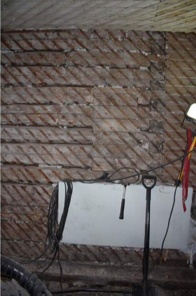
Autovajan länsiseinä. Hirsinurkka ja rankarakenne. MS 2.3.2011
