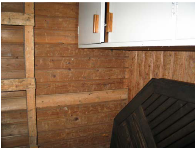
Pohjoisseinän vaakapaneeli, itäseinän pystypaneeli. MS 29.10.2009
