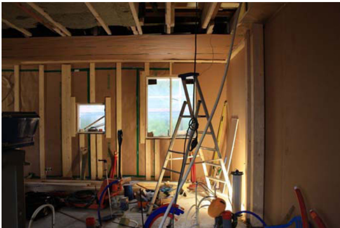
T 110 Kahvila ennen väliseinän rakentamista.. MS 22.9.2011
