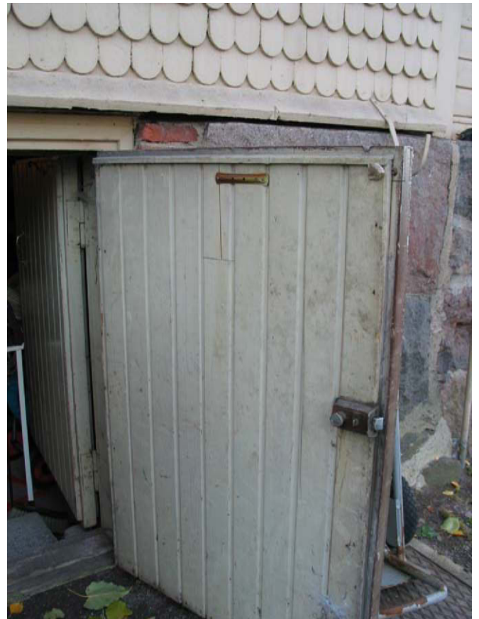
Pohjoissivun kellarin ulko-ovi. MS 29.10.2009
