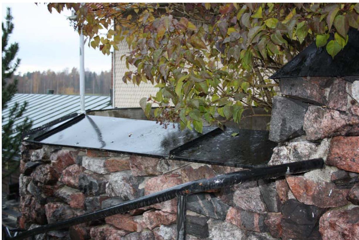
Pihaterassin tukimuurin vesipelti. MS 26.10.2010.
