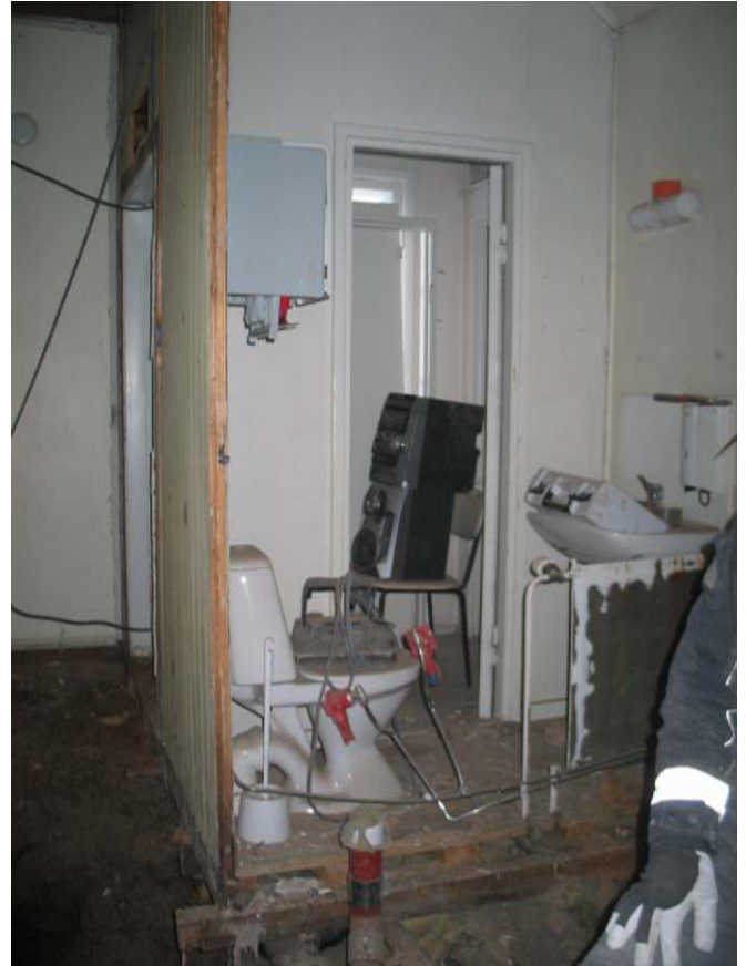
Lattian ja väliseinien purku. MS 23.2.2011
