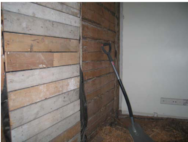
Väentuvan hirsiseinä, itäseinä. Vanha oviaukko autovajan puoleiseen varastoon. . MS 23.2.2011
