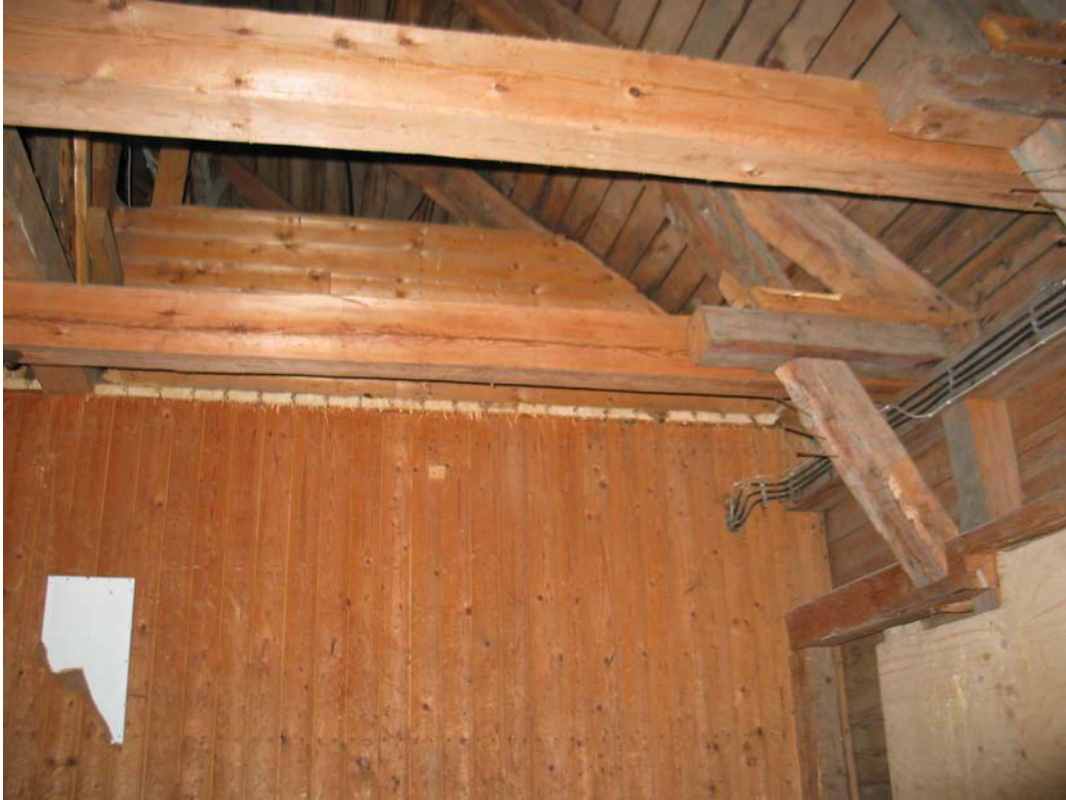
Varaston vanha itäseinä. Yläpohja avattu. MS 6.4.2011
