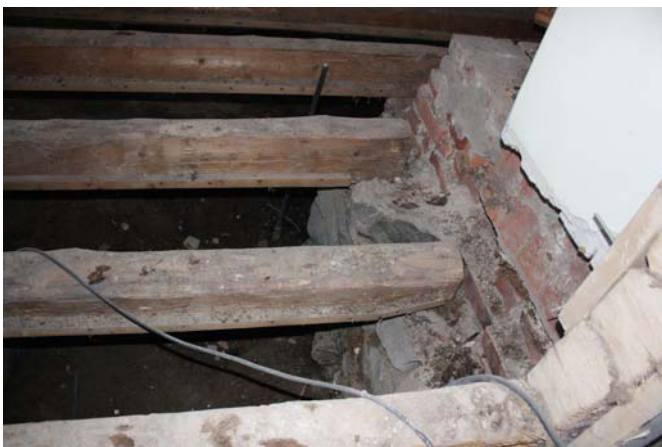
Oikealla hormiryhmän perusmuuri. MS 2.3.2011
