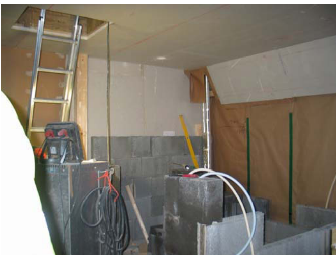
T 109. Harkkoseinän rakentaminen. MS 12.10.2011
