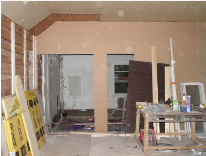
T113. Taustalla keittiön uusi väliseinä. . MaS 4.10.2011
