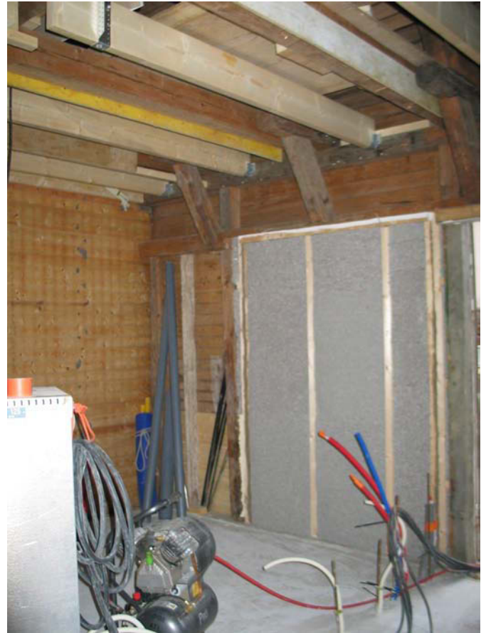
T 109. Oikealla ulkoseinän suljettu ja eristetty oviaukko. Yläpohjarakenteen lisäpalkit. MS 21.9.2011
