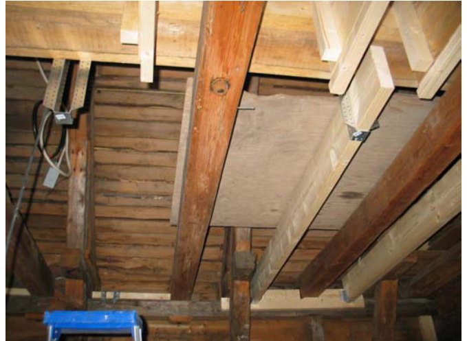
Yläpohjarakenteen lisäpalkit. MS 21.9.2011
