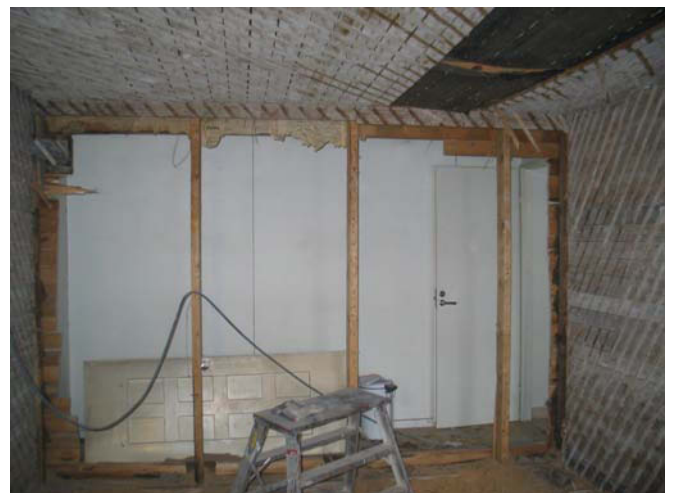
Autovaja. Pohjoisen väliseinän purku. MS 23.2.2011
