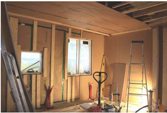
T 110 Kahvila. Ulkoseinään on lisätty lämmöneristettä. MS 22.9.2011
