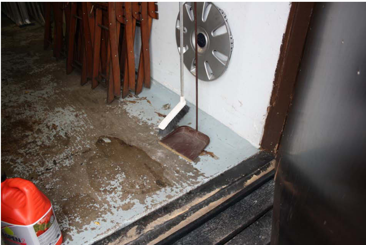
Autovajan ulko-ovi, edessä puurakenteinen sisäänkäyntitaso. MS 26.10.2010
