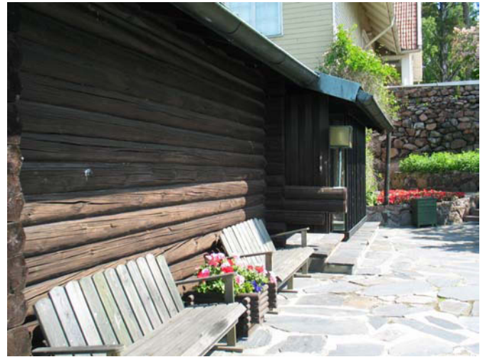
Eteläsiivu. Uima-allasosan hirsipaneeliseinä. MS 13.6.2009.
