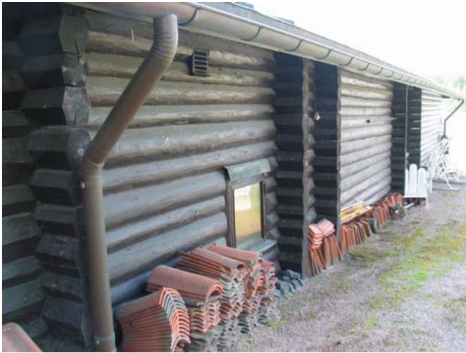
Pohjoissivun hirsiseinä, uima-allasosan hirsipaneeliseinä. MS 13.6.2009.
