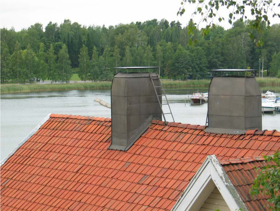
Eteläinen lape, kaksikouruinen kattotiili. MS 18.8.2010
