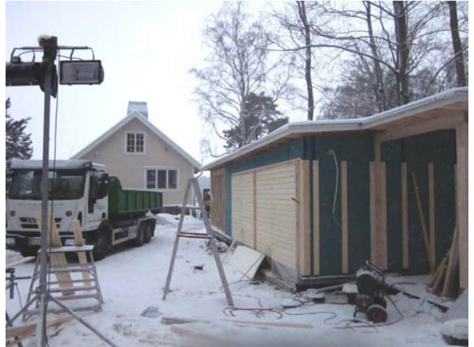
Pihavajan julkisivutyö. MS 20.1.2012
