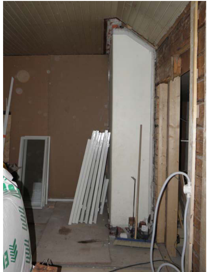
T113. Hormiryhmä. Taustalla keittiön uusi väliseinä. . MaS 4.10.2011
