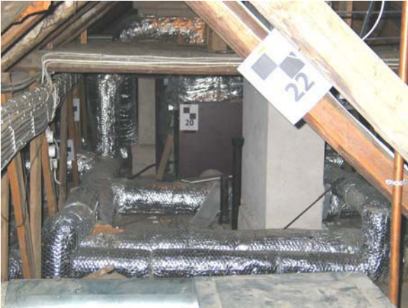
Ullakko, muuratut hormit,
