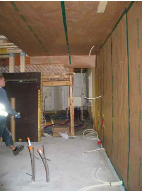
T 111. Kahvilan tuleva myyntitila. Taustalla tuleva keittiö. Lattian betonivalupinta. MS 21.9.2011
