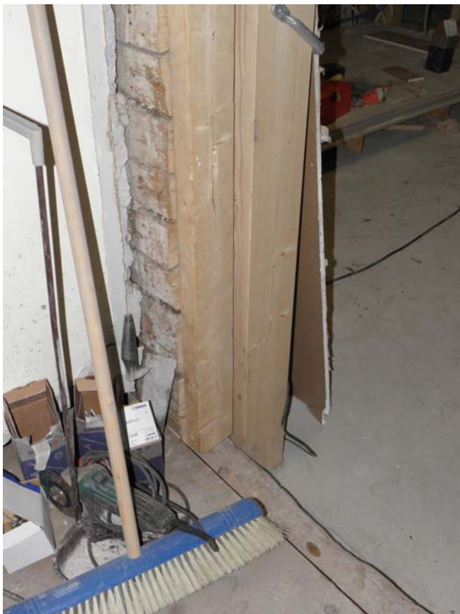
Kulkuaukko myyntitilaan T 111 rakenteilla. MaS 4.10.2011
