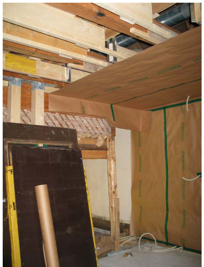
T 111. Vasemmalla ent. autovajan länsiseinä. Taustalla tuleva keittiö. Vasemmalla kaksi uutta pilaria. MS 21.9.2011
