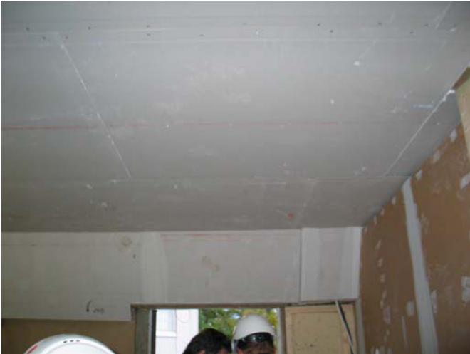
T 111. Yläpohjarakenteen levytys. MS 12.10.2011
