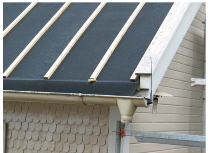
Uusi aluskate ja alempi rimakerros. Rästään yläpuolella oleva vaakalista on vanhaa rakennetta. MS 21.9.2011
