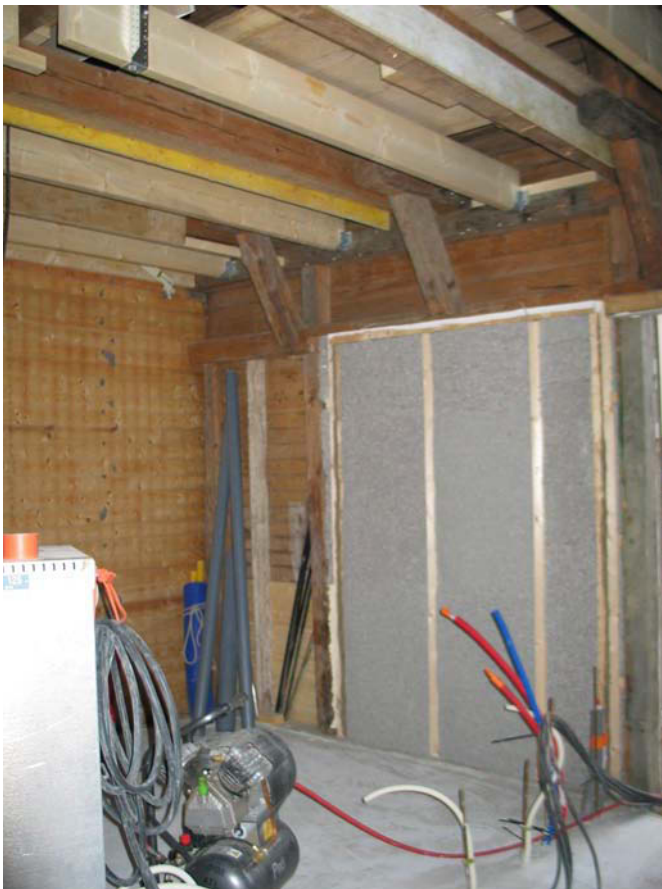
T 109. Oikealla ulkoseinän suljettu ja eristetty oviaukko. Yläpohjarakenteen lisäpalkit. MS 21.9.2011
