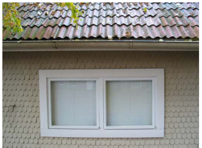
Itäpäädyn työhuoneen uudempi ikkuna. MS 2009
