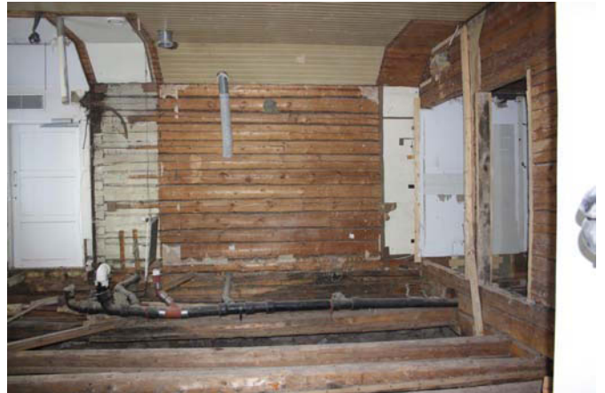
Entisen kahvilan purkutyöt. WC purettu, alapohjapalkit jäljellä. MS 2.3.2011
