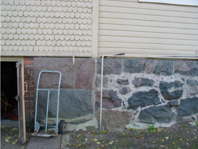
Pohjoissivun uudempi harkkokivisokkeli (1915), vanhempi sokkeli oikealla. MS 29.10.2009
