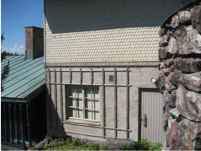
Huoltorakennuksen kellarin slammattu ulkoseinä. MS 2009
