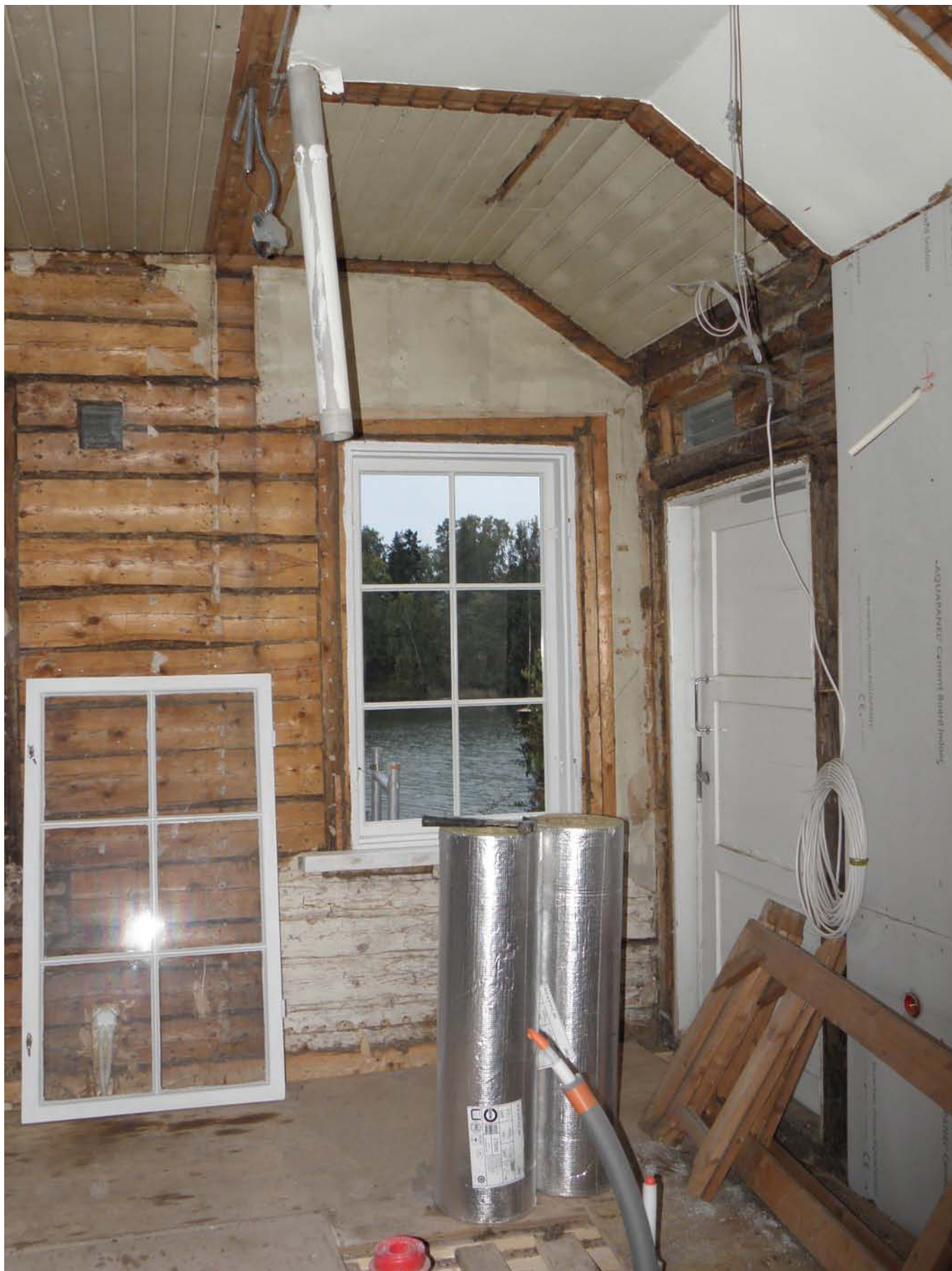
Kahvilan eteinen rakenteilla. MaS 4.10.2011
