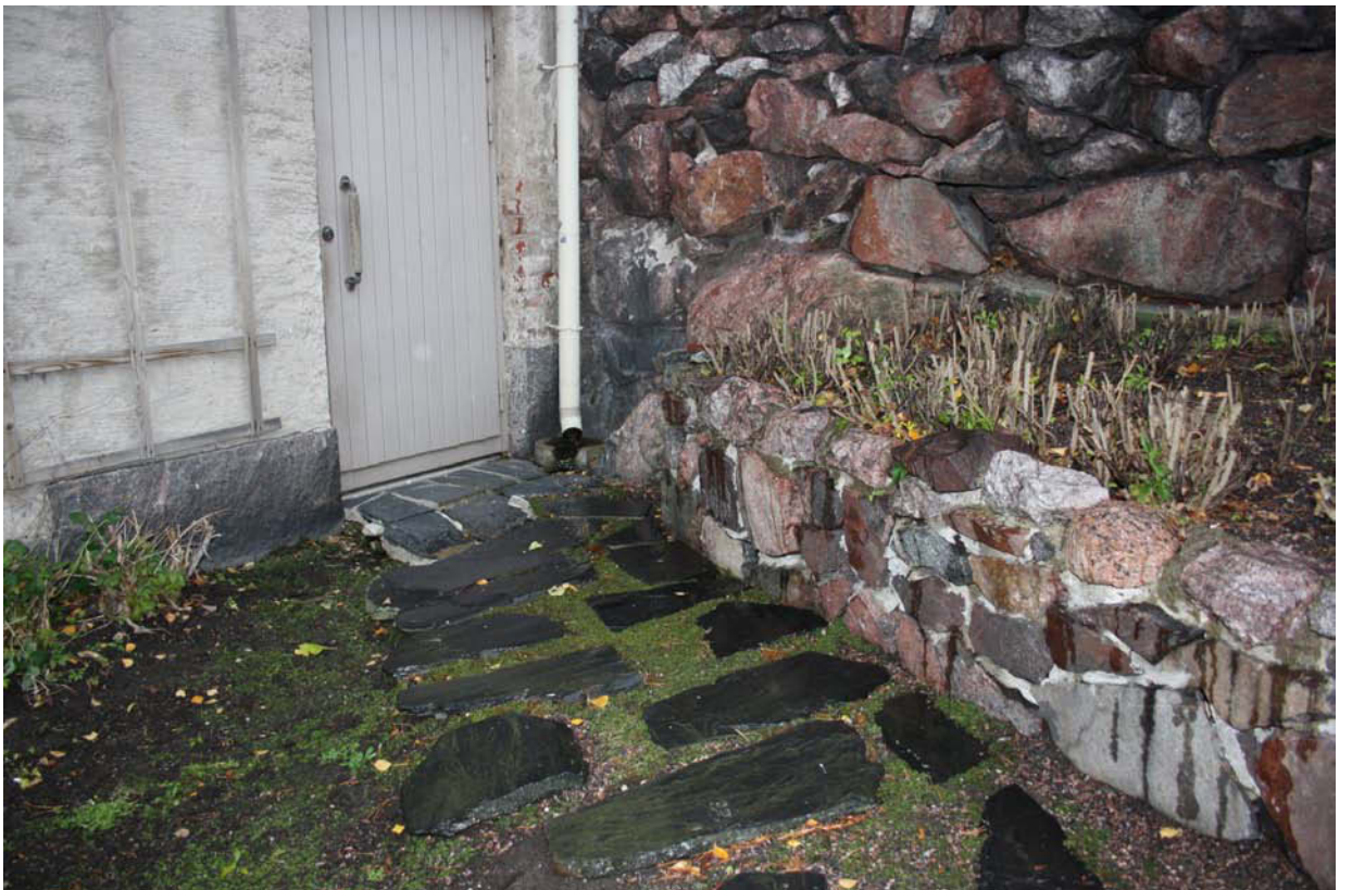
Muurin juurella pengerretty istutus, edessä kivetty käytävä ja ovi henkilökunnan saunaan. MS 26.10.2010.
