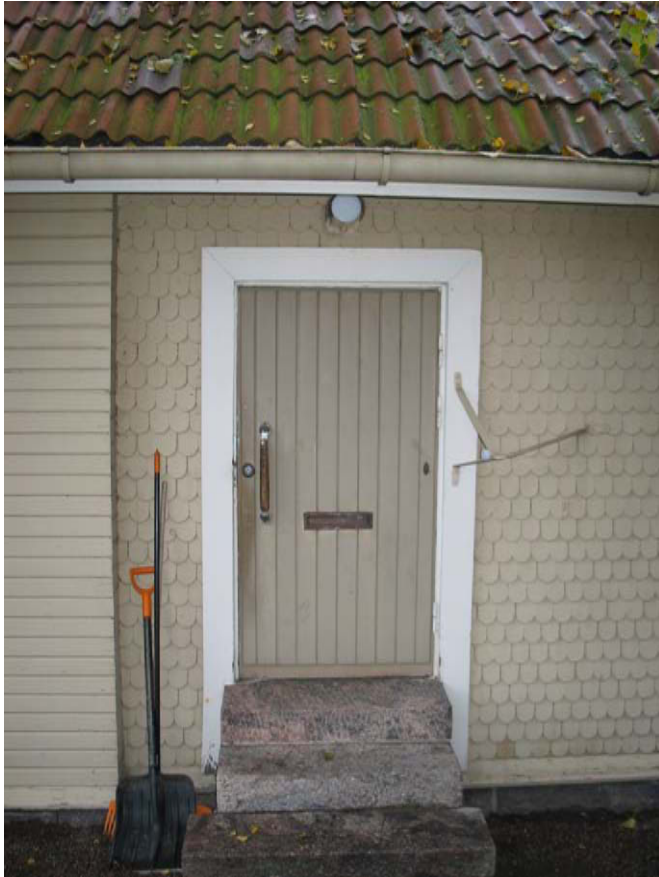
Itäpäädyn työtilojen ulko-ovi. MS 2009
