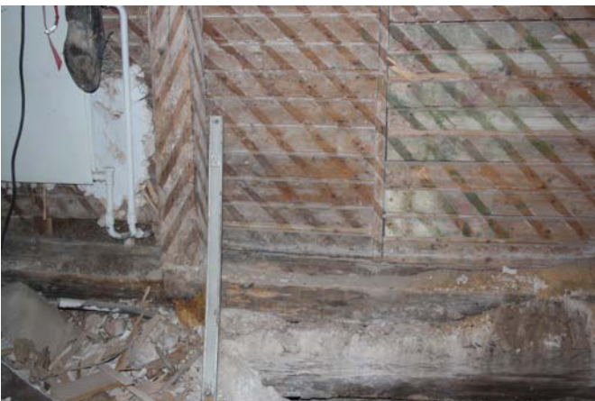
Autovajan länsiseinä. MS 2.3.2011
