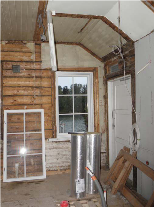
Kahvilan eteinen rakenteilla. MaS 4.10.2011
