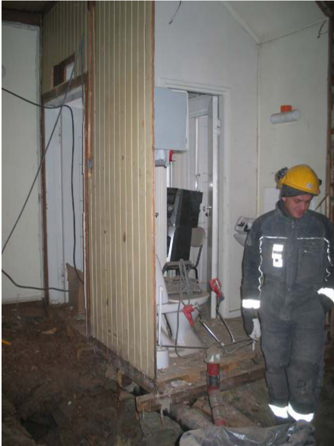
Lattian ja väliseinien purku. MS 23.2.2011
