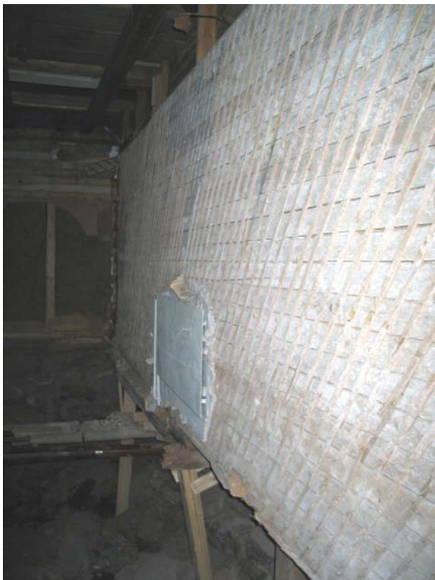
Itäseinän rankarakenne tuettuna alapohjan purkutyön aikana . MS 4.6.2011
