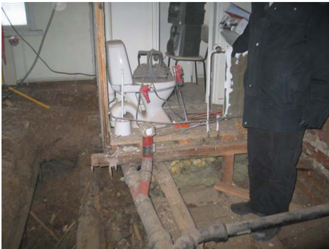
Lattian ja väliseinien purku. MS 23.2.2011
