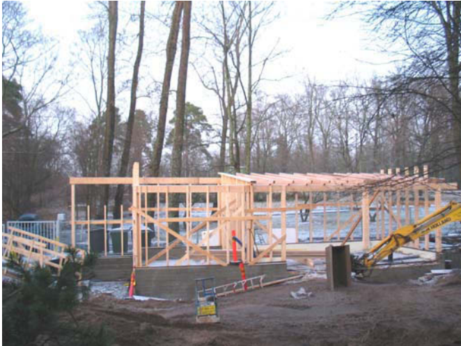
Pihavajan runkotyö. MS 22.11.2011
