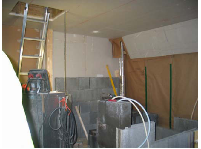
T 109. Harkkoseinän rakentaminen. MS 12.10.2011
