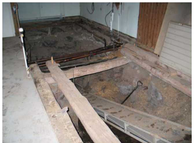
Varasto ja silityshuone. Väliseinän ja alapohjan purkutyö. MS 4.6.2011
