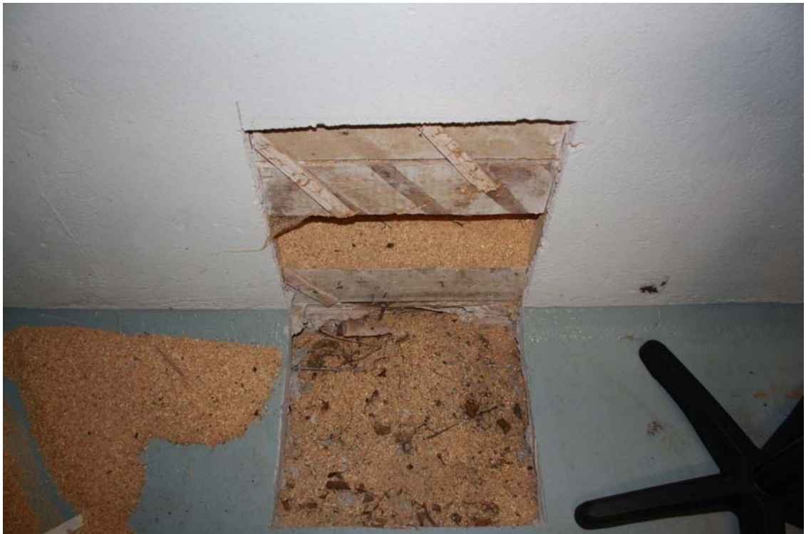
Autovajan / verstaan seinän ja lattian rajassa tehtiin rakenteen koeavauksia 26.10.2010. Kuvassa näkyy seinän päällysteenä käytetty, vinorimoituksella pohjustettu Luginomassa tai vastaava. MS
