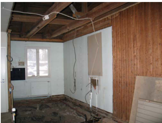
Varaston ja silityshuoneen väliseinän ja alapohjan purkutyö. Yläpohja avattu. MS 6.4.2011
