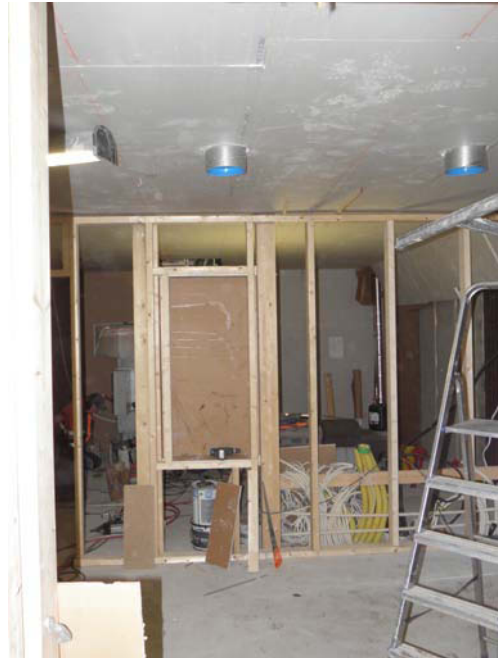
T 111/T106 uusi väliseinä rakenteilla. MaS 4.10.2011
