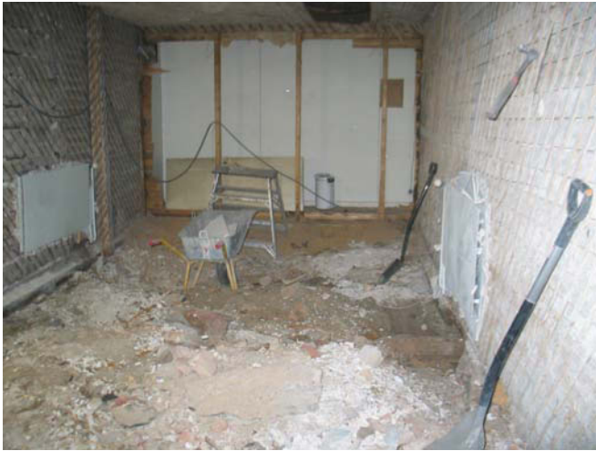
Autovaja. Taustalla pohjoisseinä Lattian ja väliseinien purku. MS 23.2.2011
