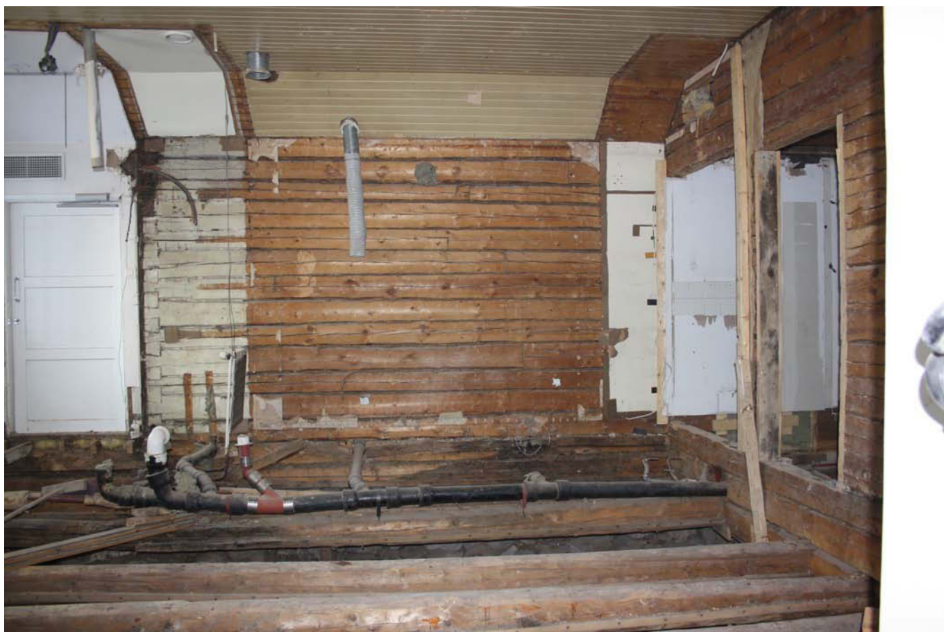
WC purettu, alapohjapalkit jäljellä. Vanha paneelikatto on paljastunut levytyksen alta. MS 2.3.2011
