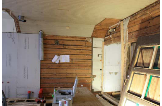
T113 Kahvila. WC-tilojen rakentaminen on alkanut. Oikealla aukko keittiön suuntaan. MS 22.9.2011
