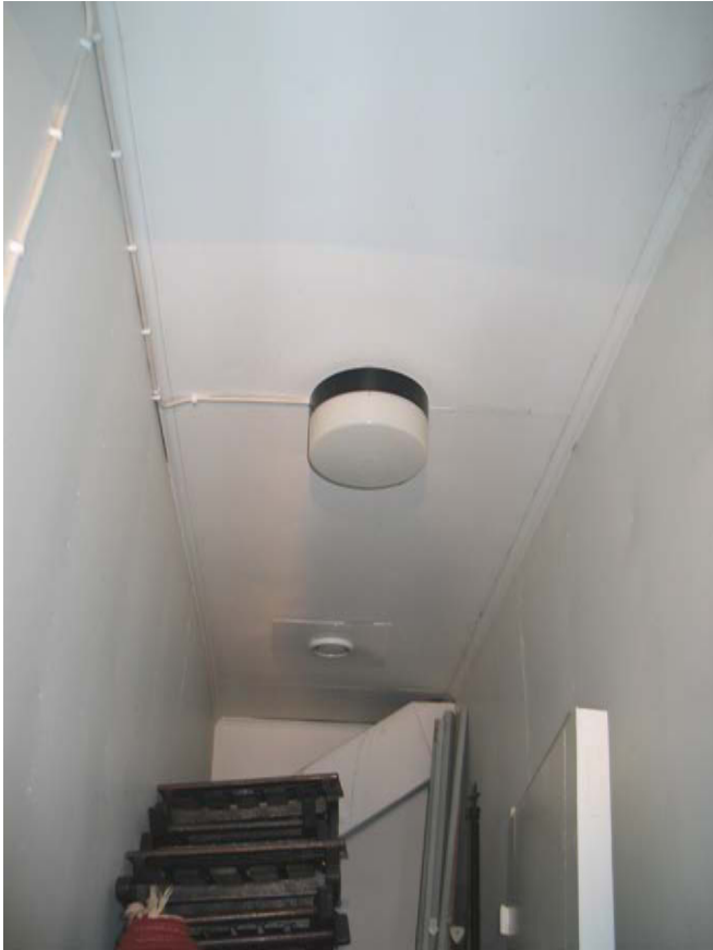
Autovajan pohjoissivulle rakennettu kapea käytävä. MS 29.10.2009.
