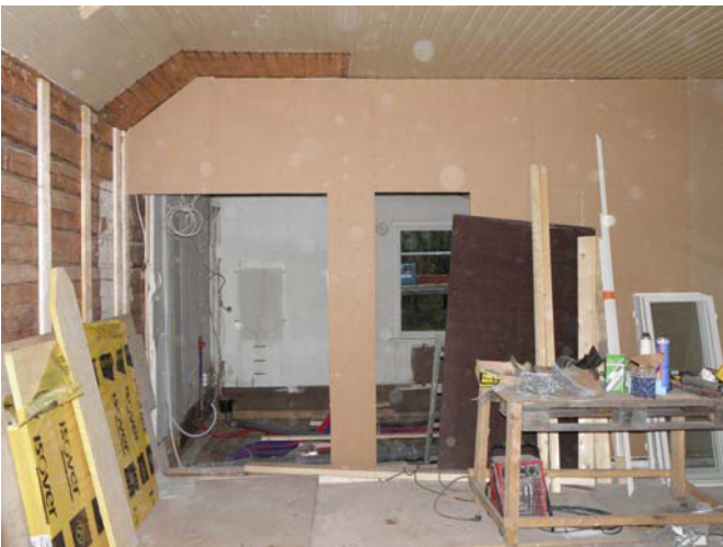
T116. Keittiön väliseinän rakentaminen. Lattia ennen valua . MaS 4.10.2011
