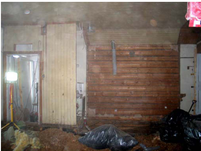
Lattian ja väliseinien purku. MS 23.2.2011
