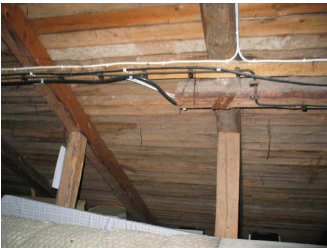
Ullakon keskialueen sähkö- ja iv-asennukset. MS 14.8.2009
