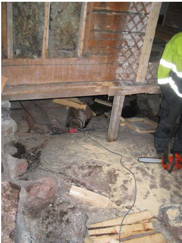
Autovaja. Länsiseinän väliakainen tuenta. MS 16.5.2011
