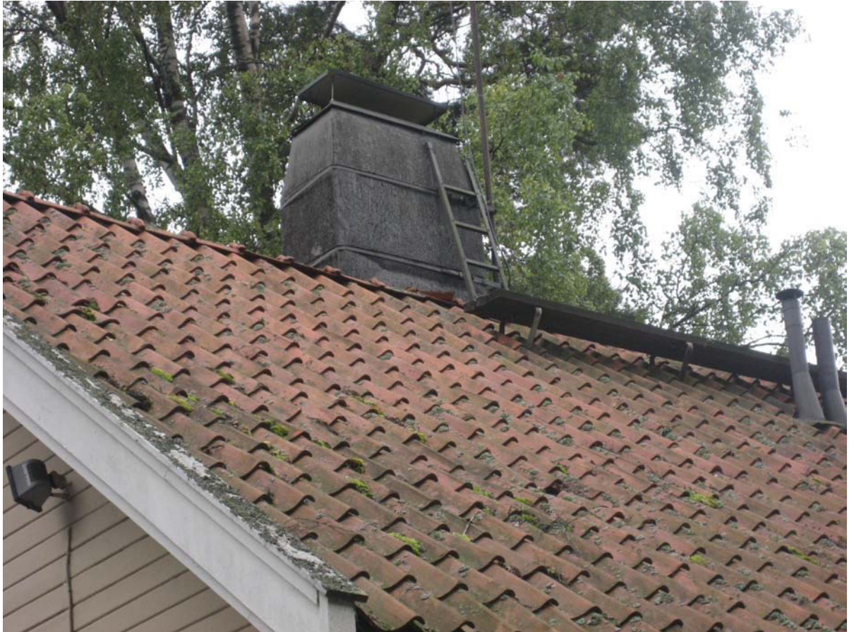
Pohjoinen lape, yksikouruinen kattotiili. MS 28.8.2009
