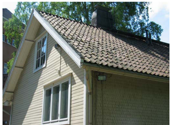
Pohjoinen lape, yksikouruinen kattotiili. MS 13.6.2009
