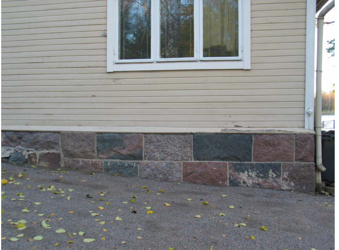
Itäpääty, vasemmalla vanhempi sokkelimuuri, oikealla sokkelimuuri v. 1904 jälkeen. MS 29.10.2009
