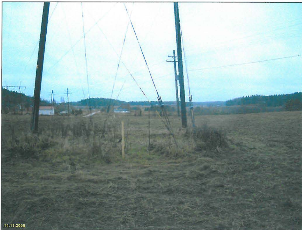
Uuden pylvään paikka vanhan vieressä, sen pohjoispuolella. Taustalla näkyy törmän reuna, jonka äärellä on asuinpaikan ydin. Kuvattu etelään.
