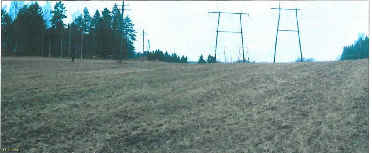
Panoraamakuvu törmän alarinteestä pohjoiseen.
