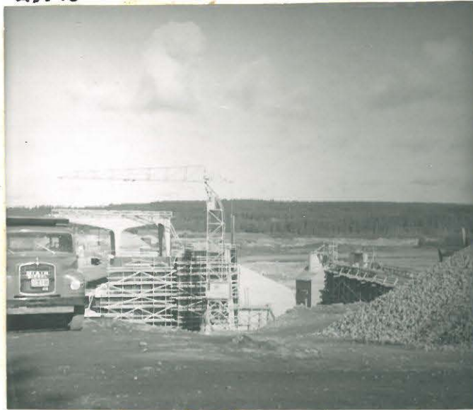
12. LEPPIKOSKEN VOIMALAITOS. NUOLEN OSOITTAMALLA KOHDALLA RAKEN- NELMIEN VÄLISTÄ NÄKYV LATO, JONKA LUONA OLEVALLA PELLOLTA TULI LÖYTÖJÄ
