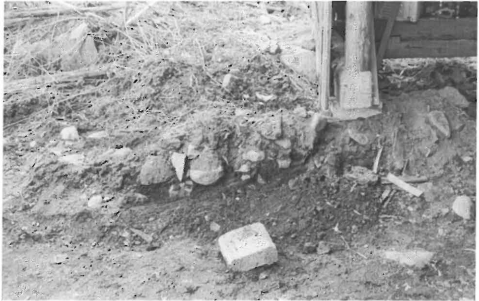
136755. Keskitalon tilan ulkovaja, jonka pohjamaat kaivettu pois. Vuonna 1930-luvun tietojen mukaan vajan alla olisi ollut kalmistoa vielä jäljellä. Idästä.
