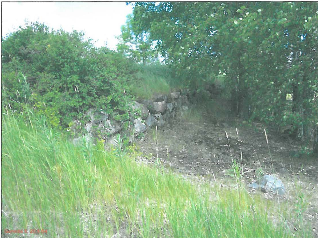
Rakennuksen pohjan kaakkoisreunan kivijalka. Kuvattu pohjoiseen.
