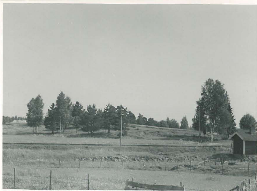
Kuva 24. Ristkankare Kosken taloon vievältä maantieltä kuvattuna. Oike- assa reunassa Rungon pysäkin raken- nuksia.
