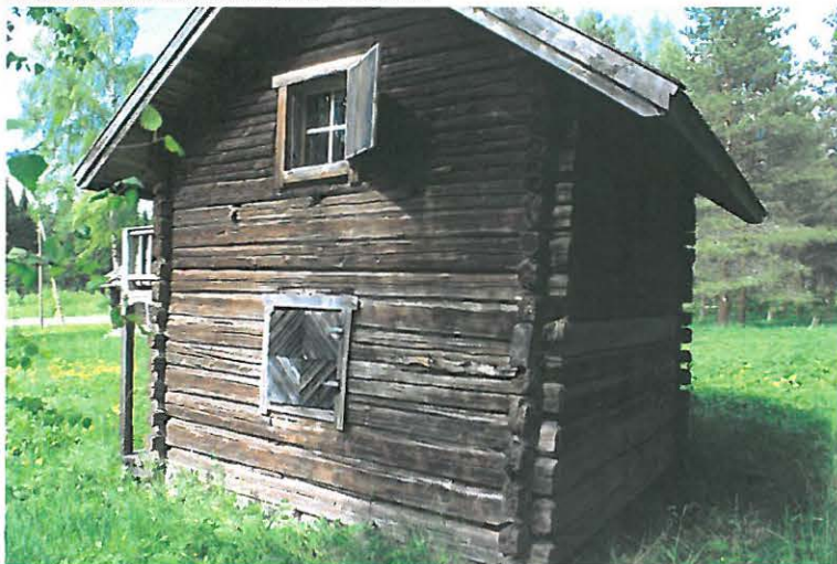
Kaksikerroksinen aitta sivulta.
