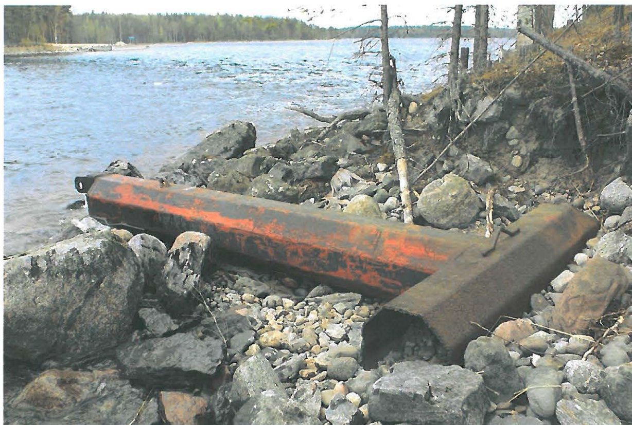
DSC01510. Pulkkilanharju Karinsalmi, lossinpaikka. Kiinnitysteline lähempää kuvattuna, lounaasta. 14.5.2009.
