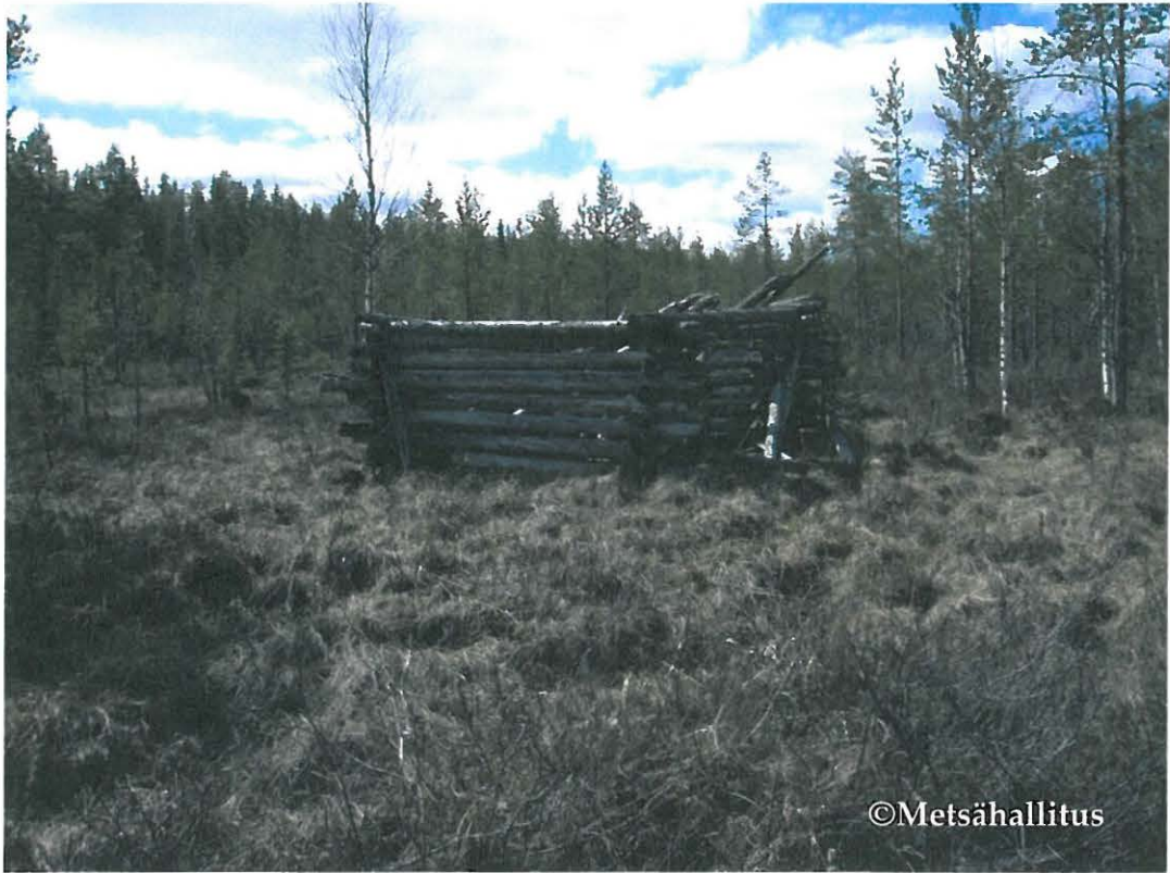
Kuva 16. Paasonjoki. Ladon jäännökset. Kuvattu pohjoisesta.
