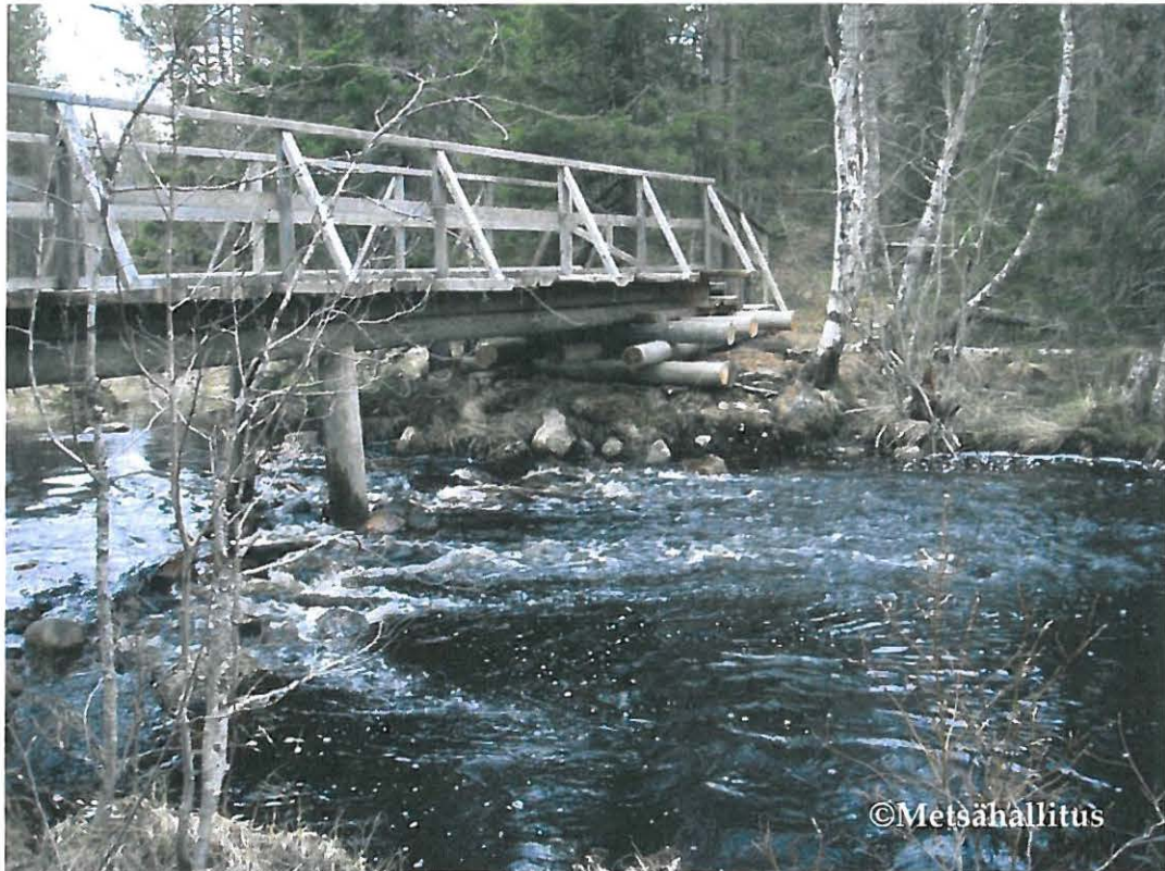
Kuva 21 . Paha-Paaso. Tammen jäänteet näkyvät sillan eteläpään kannatinpalkkien alla. Kuvattu pohjoisesta.
