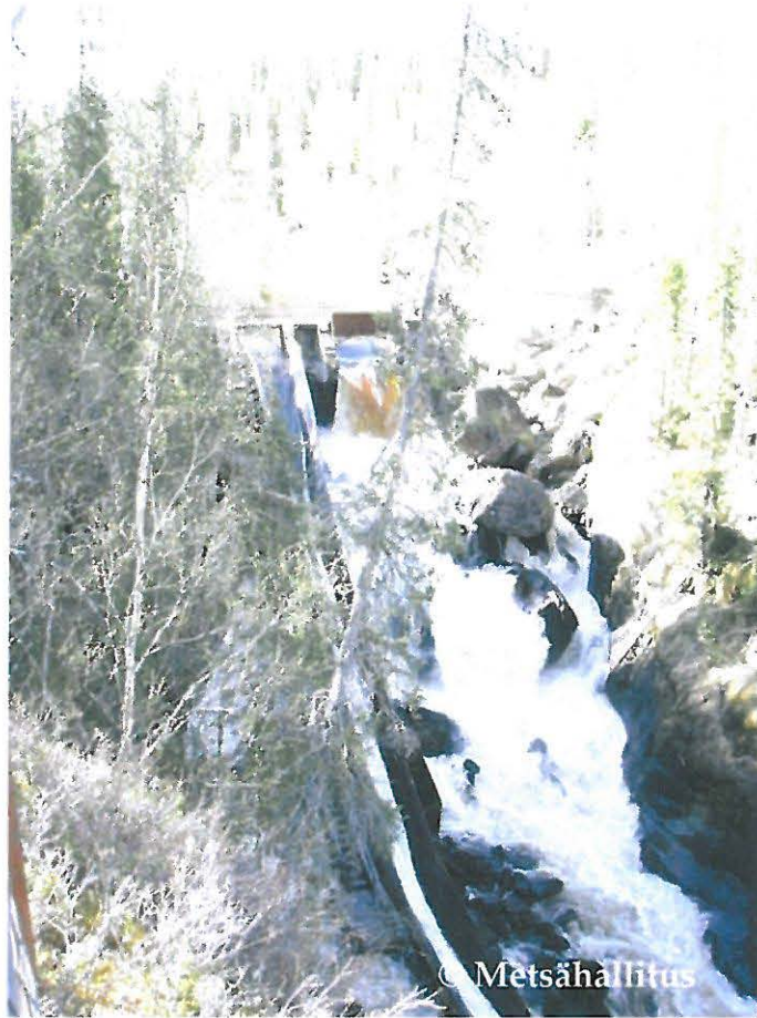
Kuva 18. Auttiköngäs 7. Uittoruuhi ja pato. Kuvattu koillisesta.
