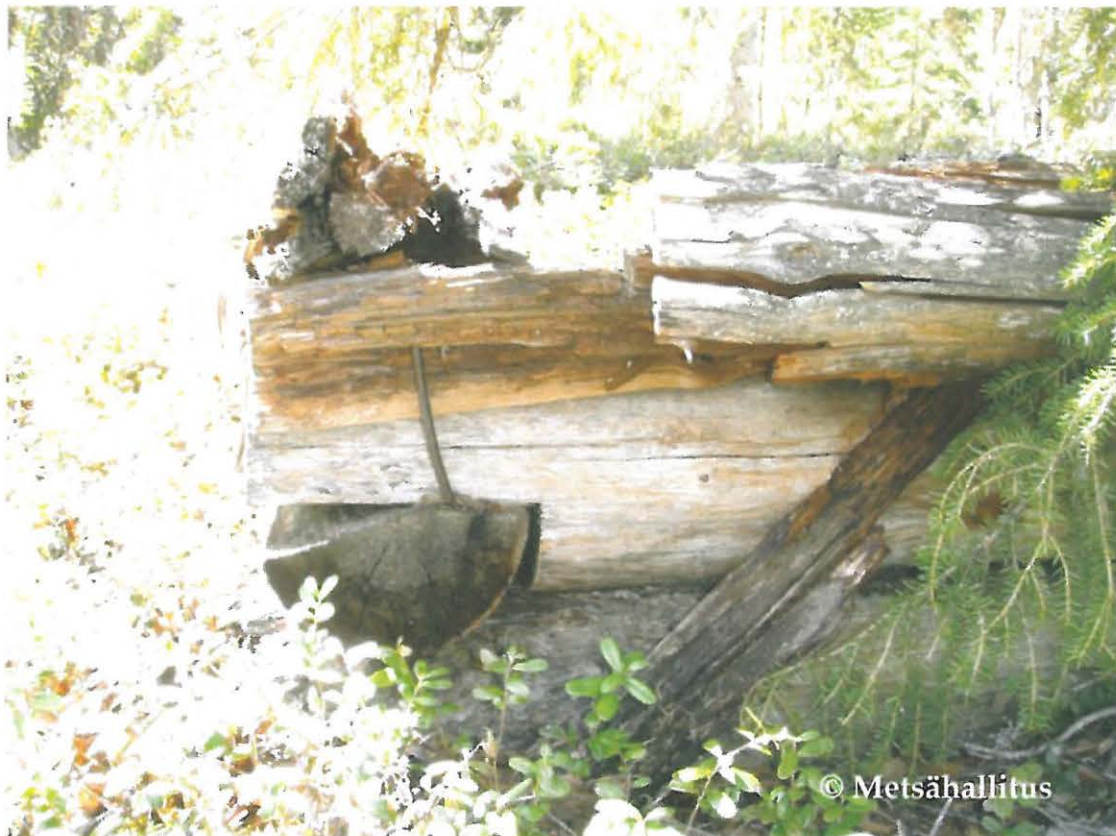
Kuva 22. Auttijoki 43. Hirsirakennuksen kulma.
