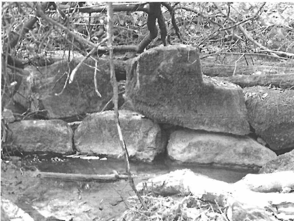
Kuva 41. Yksityiskohta rakenteesta kuvattuna koillisesta. Kuva: Elina Terävä.
