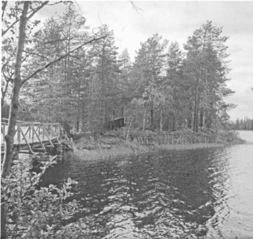
Kuva 6. Keräsensalmen silta Aittojärvessä. (Dia numero 41775.)
