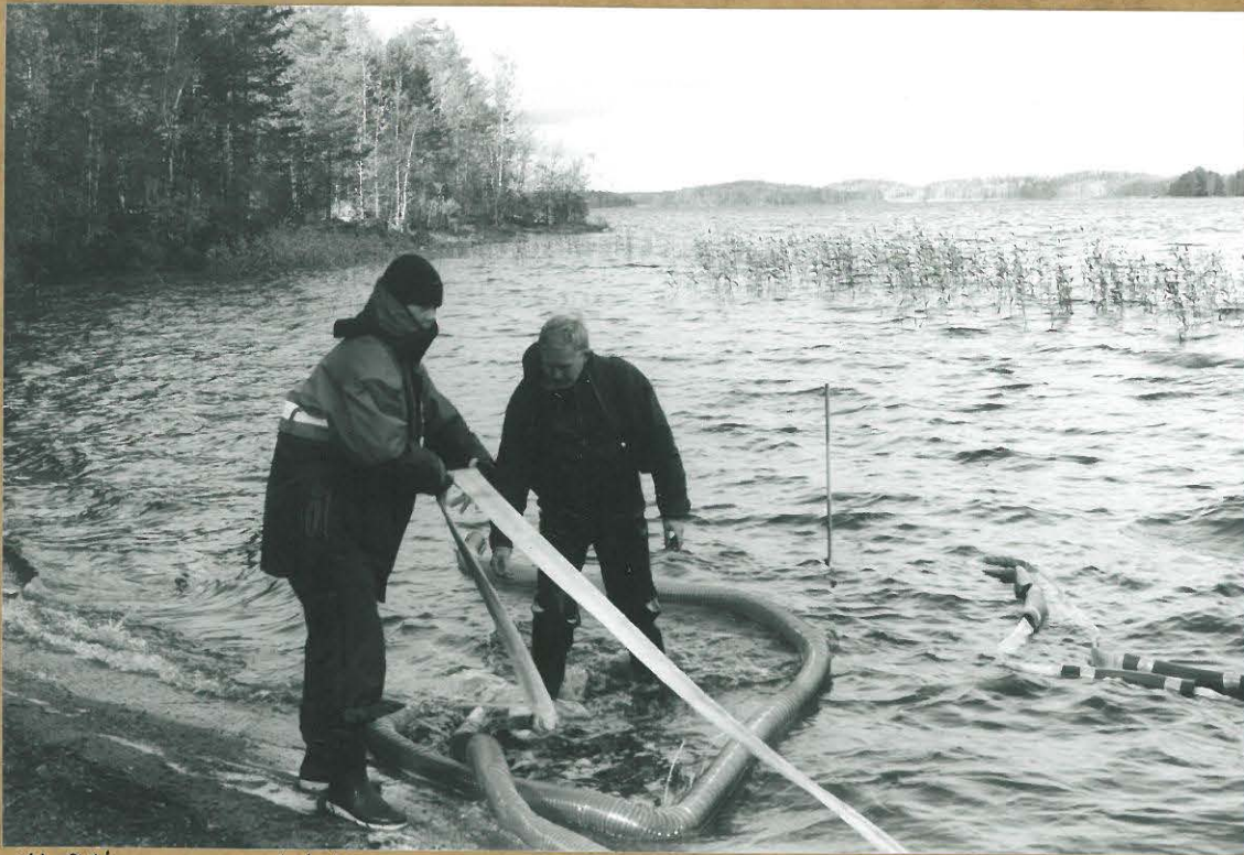
Ejektorigumpun asennus. Kuvassa Sallomaria Tikkanen ja Antero Kukulampi. W-E. 25.9.98. Kuvaaja: M. Koivikko.
