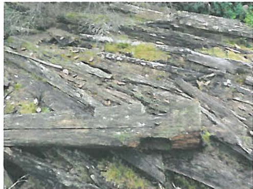
Kuva 80453-52641 Pitämävaara kämppä. Puretun kämpän hirret, joista yhdessä erottuu salvettu pää.
