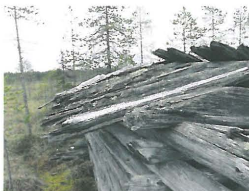
Kuva 80460-52648 Paskalampi niittylato. Ladon halkaistusta puusta ja tuohesta tehty katto.
