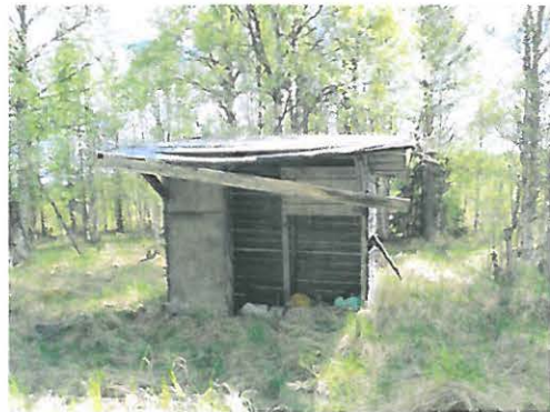
Kuva 80450-52639 Kiekkiperä verkkomaja. Koviojärven Kiekkiperän lautarakenteinen verkkojen säilytysmaja.
