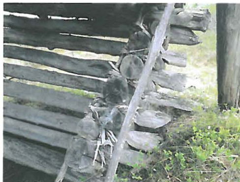
Kuva 80460-52647 Paskalampi niittylato. Oven pielen vitsapunos ylhäältä kuvattuna.
