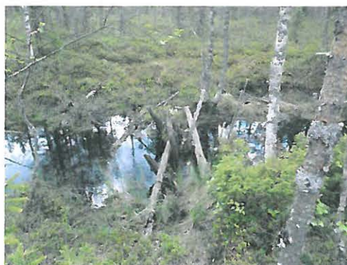
Kuva 80420-52573 Kaivosoja niittypato. Tammen pato kaivetussa kanavassa, kuvattu etelään.
