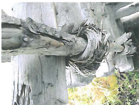
Kuva 80460-52647 Paskalampi niittylato. Oven pielen vitsapunos ylhäältä kuvattuna.
