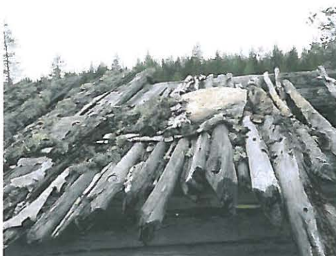
Kuva 80460-52654 Paskalampi niittylato. Katon tuohikatetta, joka on osin lentänyt tuulen mukana ympäristöön.
