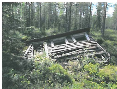
Kuva 80400-52521 Taivalvaara kämppä. WC kuvattuna koillisesta.
