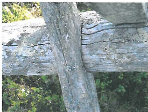
Kuva 80276-52258 Pyöreälampi 3 parkkauspukki. Pukin jalkojen liitos.
