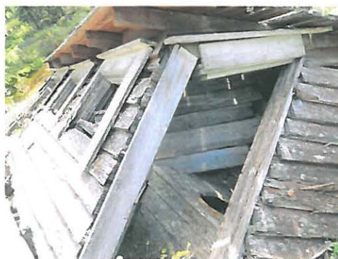
Kuva 80400-52522 Taivalvaara kämppä. WC kuvattuna pohjoisesta.
