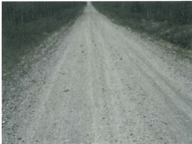
Kuva 52774 Metsäkylä kenttärata (80201) Kenttäradan linjaus kuvattu Talja- vaaran kohdalla etelästä.
