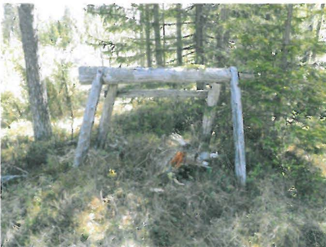
Kuva 52311 Hiltusten Rytisuo silta (80306) Siirretty sillanpukki kuvattu lännestä.
