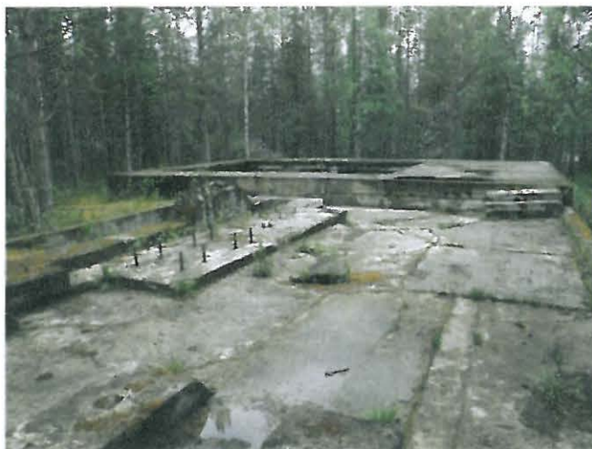
Kuva 52599 Palokumpu 3 pilketehdas (80443) Pilketehtaan perustukset kuvattu kaakosta.
