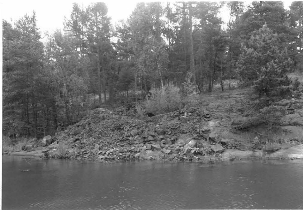
Kuva 7. Kohde 11: Älgön rautakaivoksen kaivoskuilu meren puolelta; Älgö,Näseudden. Kuvattu pohjoisluoteesta. (9138;22)
