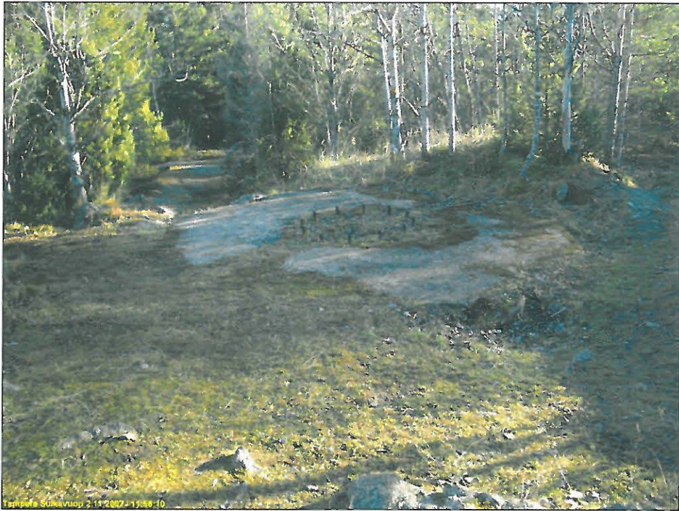
Betoninen tykinperusta. Näitä alueella on seitsemän.
