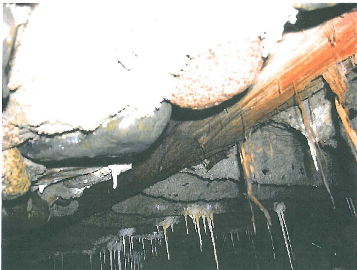
DSCN0009.JPG Betonikattoisen rakenteen sisätilaa/katon sisäpuolta. SW, 6.10.2008, Vadim Adel.
