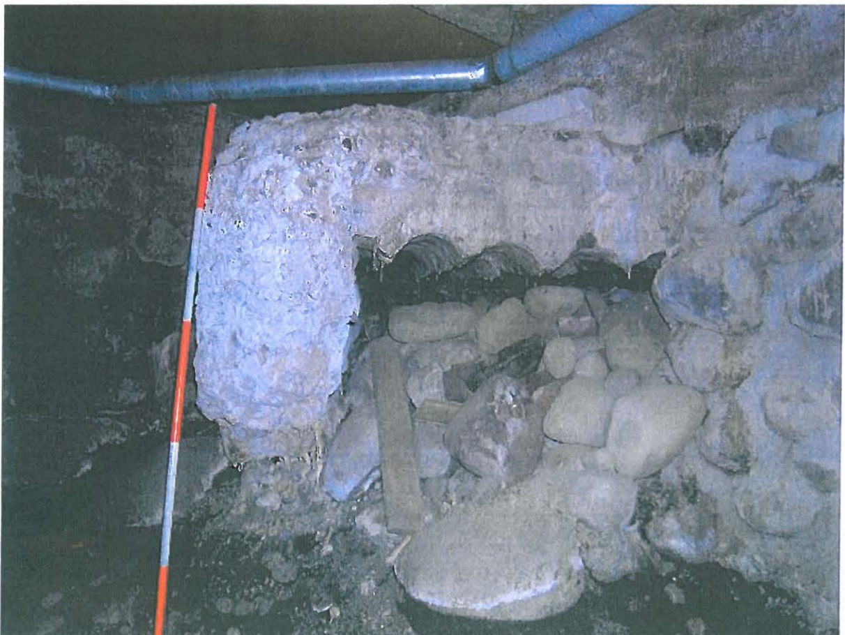
DSCN0386.JPG Pispalanharju, Pispalanharju 34. Betonirakenne. Itäkoillisesta. 14.5.1008, Vadim Adel.
