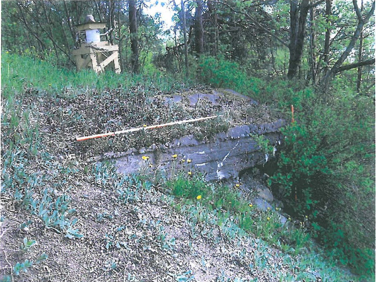
DSCN0347.JPG Pispan koulu. Rakenne 1. Koillisesta. 12.5.2008, Vadim Adel.
