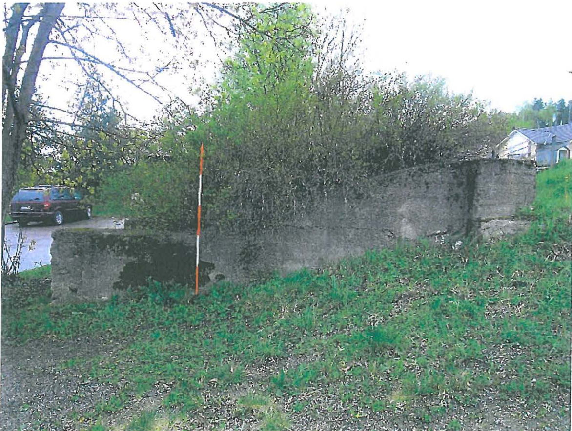
DSCN0302.JPG Pispalan tukkitie 1, betonirakenne. Idästä. 7.5.2008, Vadim Adel.
