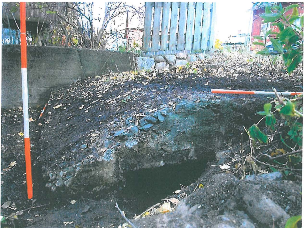
DSCN0015.JPG Betonirakenteen SW-sivua (NW-osa). SW, 6.10.2008, Vadim Adel.
