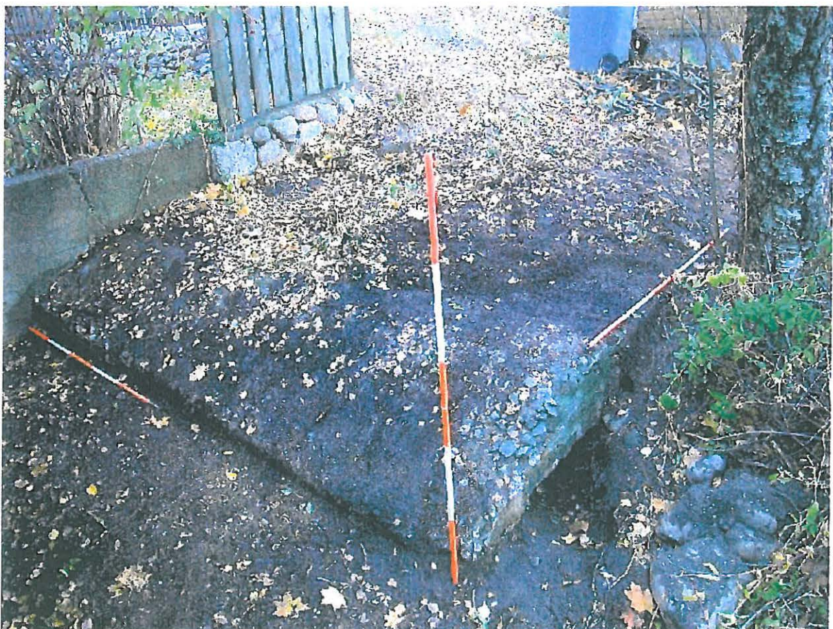
DSCN0014.JPG Yleiskuva betonirakenteesta. WSW, 6.10.2008, Vadim Adel.
