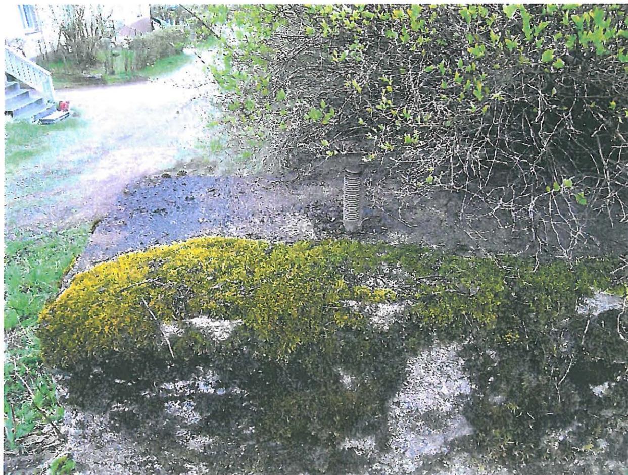
DSCN0306.JPG Pispalan tukkitie 1, betonirakenne. Pultti rakenteen NE-kulmassa. 7.5.2008, Vadim Adel.
