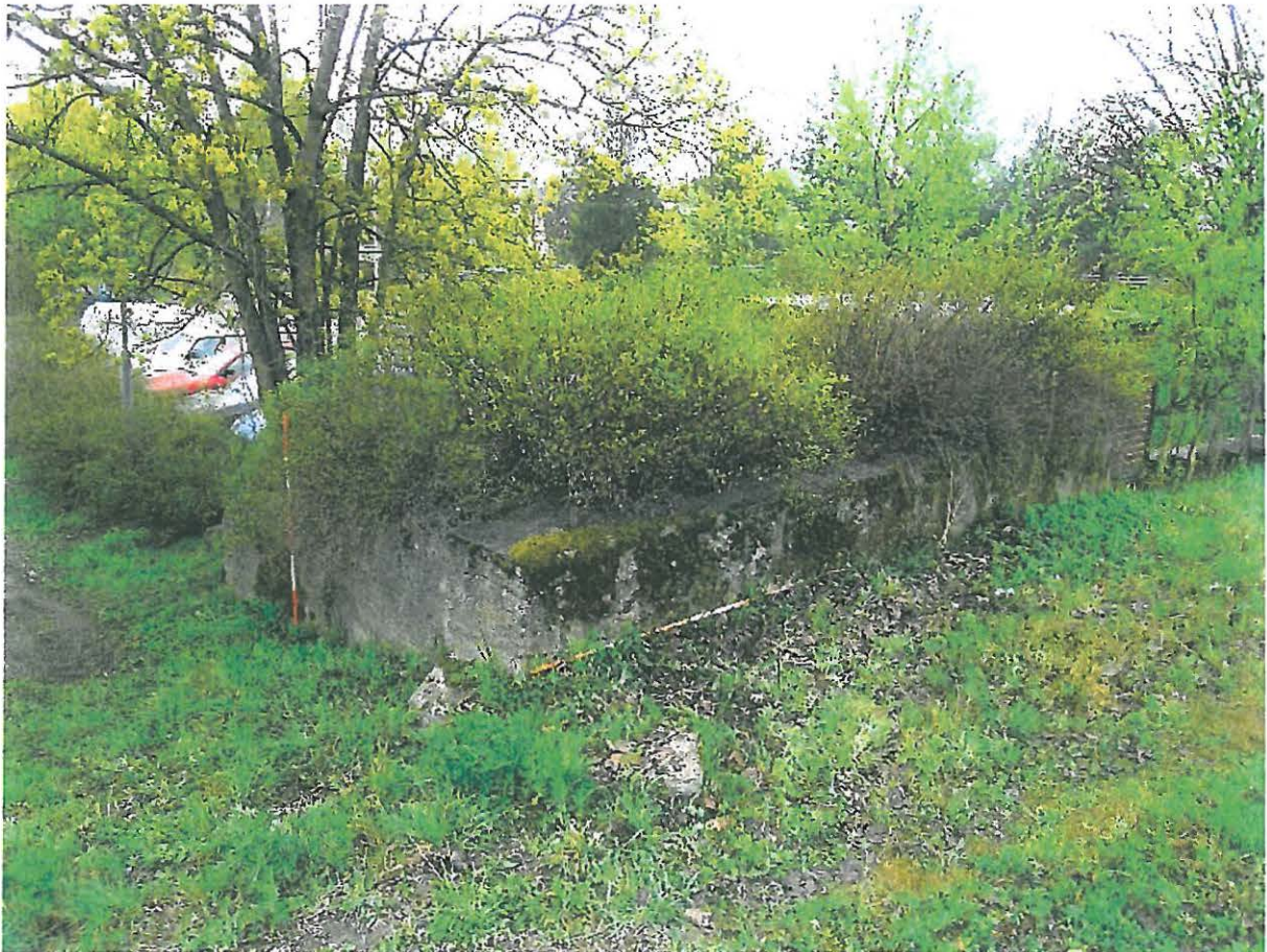
DSCN0303.JPG Pispalan tukkitie 1, betonirakenne. Koillisesta. 7.5.2008, Vadim Adel.
