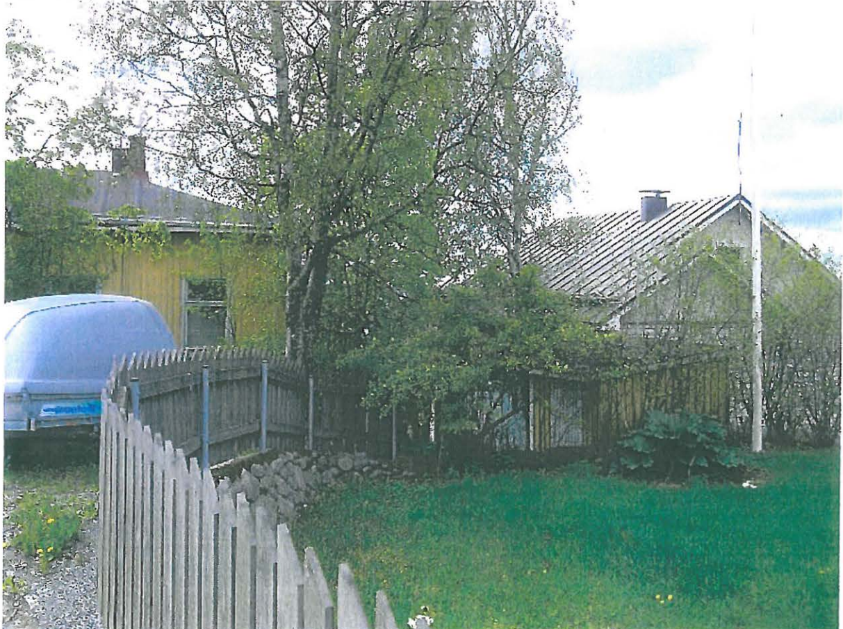
DSCN0403.JPG Mäkikatu 43. Yleiskuva piha-alueella olevasta mj-alueen osasta. Koillisesta. 19.5.2008.
