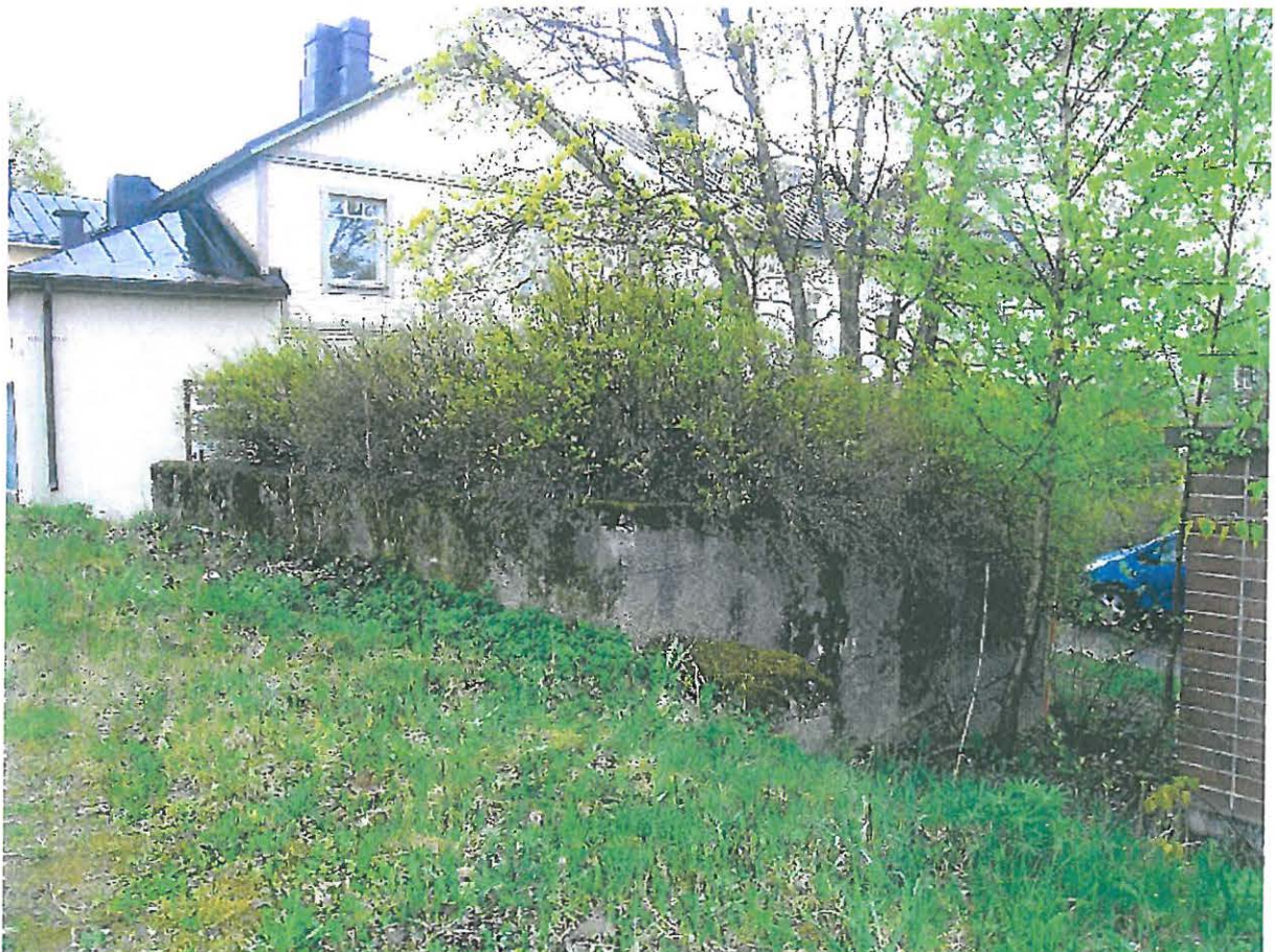
DSCN0305.JPG Pispalan tukkitie 1, betonirakenne. Luoteesta. 7.5.2008, Vadim Adel.
