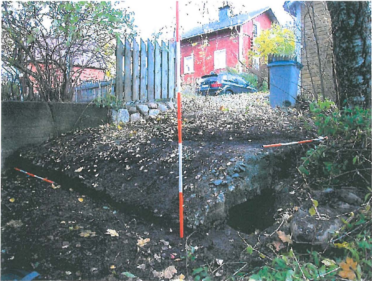
DSCN0012.JPG Betonirakenne. WSW, 6.10.2008, Vadim Adel.
