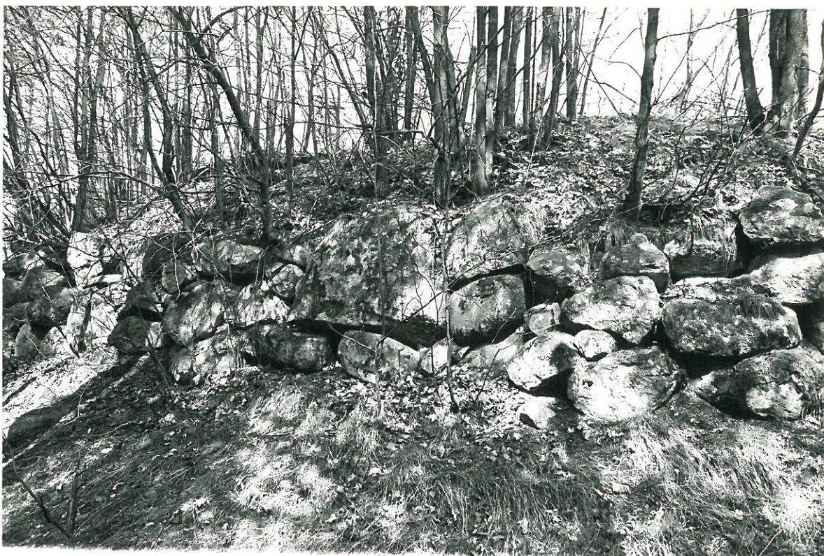
15. Turku, Hirvensalo, Jänessaari. Tykkipatterin ulkoreunan kylmämuurausta S.
