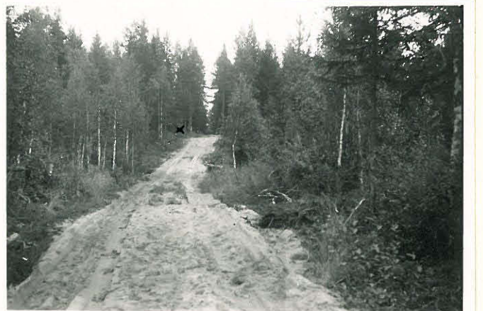
UTAJÄRVI, ALASUVANNON K.K. METSÄNRINNE EDULLISESTÄ MAANTIELLE PÄIN. KUVA OTETTU OJAN RUMMULTA. KVAARTSI STU. PÄÄSSÄ VASEMMALTA (X)
