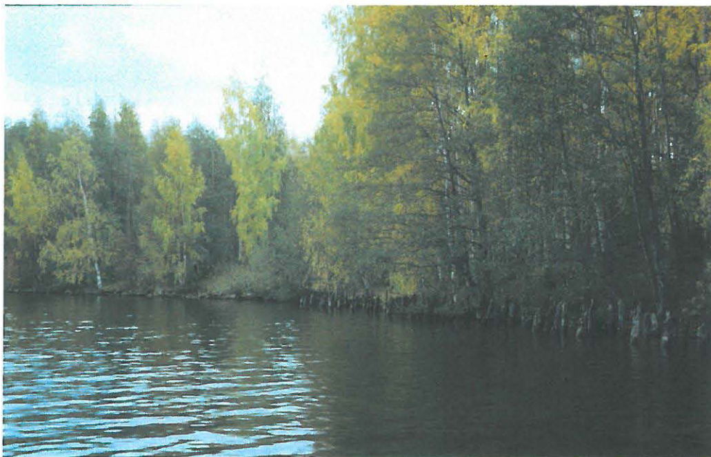
Kuva 3. Suosaaren pohjoisrannan pystypaalutusta. Kuva MA200729:22.
