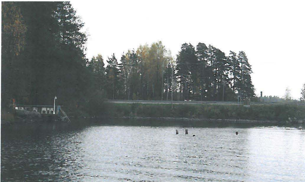
Kuva 7. Pystypaalurakennelman jäänteet Sorsasalon sillan länsipuolella. Kuva MA200729:3.
