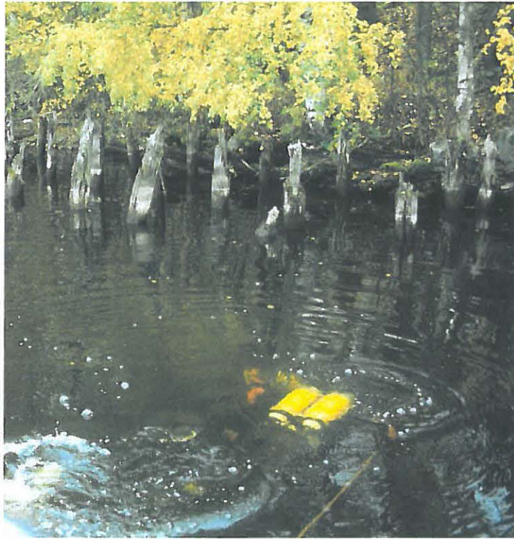
Kuva 4. Sukeltaja tarkastamassa Suosaaren paalurakennelmit. Kuva MA200729:25.
